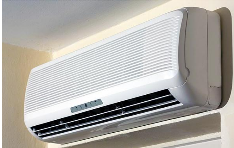
Εικόνα 2.22: Διαιρούμενη κλιματιστική μονάδα τοίχου
