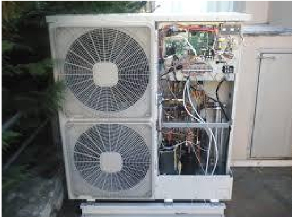
Εικόνα 2.32: Αντλία θερμότητας για οικιακή χρήση. 26
