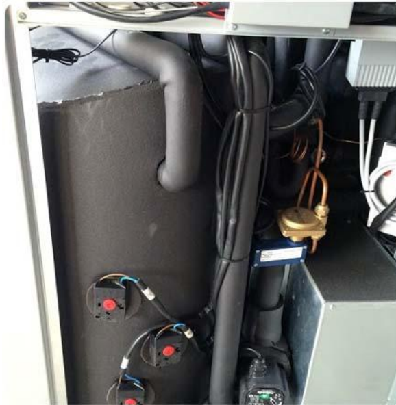
Εικόνα 2.40: Αντλία θερμότητας λειτουργίας εδάφους/νερού
