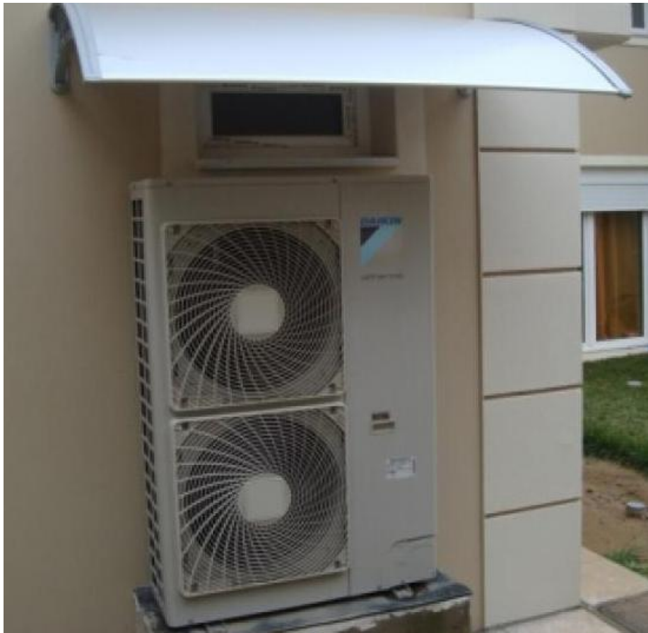
Εικόνα 2.41: Αντλία θερμότητας υψηλών θερμοκρασιών 34
