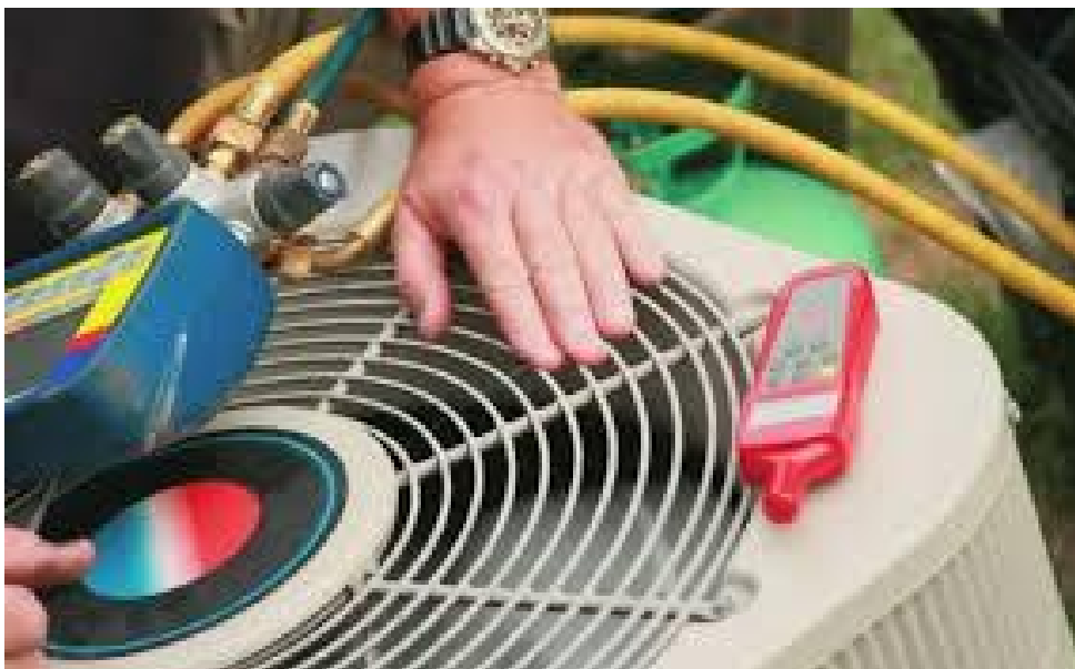
Εικόνα 1.2: Στιγμιότυπο από εγκατάσταση εξωτερικής κλιματιστικής μονάδας 4
