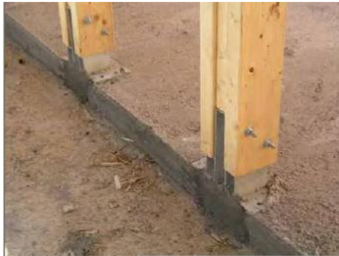
Εικόνα 1 Μεταλλικός σύνδεσμος στη βάση ξύλινου υποστυλώματος
