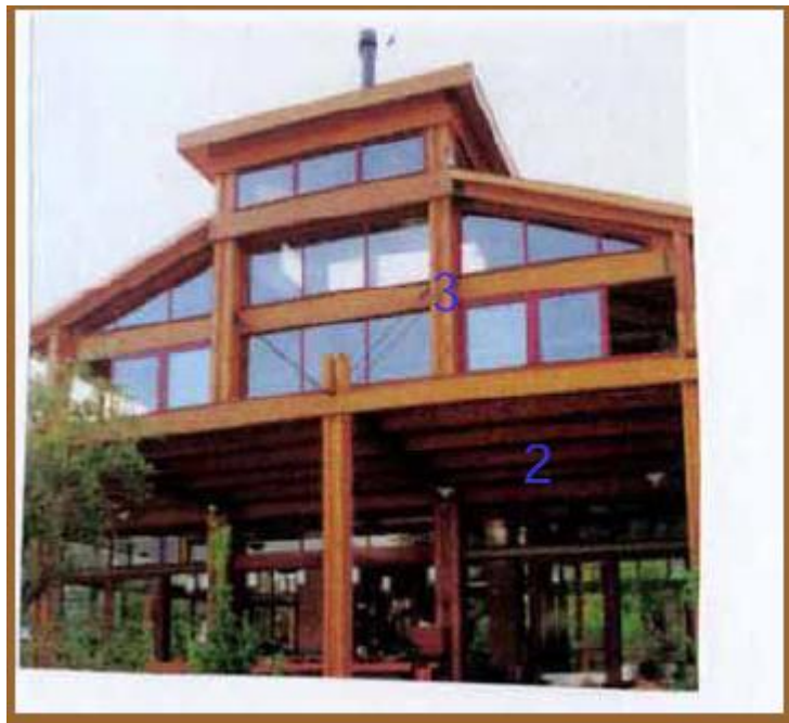
Εικόνα 7 Στεγασμένες ανοιχτές ξύλινες κατασκευές (κατηγορία υγρασίας 2)
