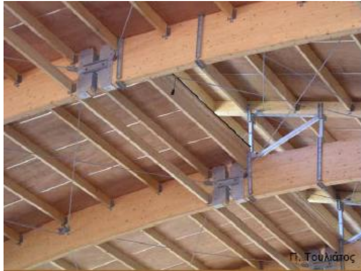
Εικόνα 2 Φορείς με ξύλινα και χαλύβδινα μέλη
