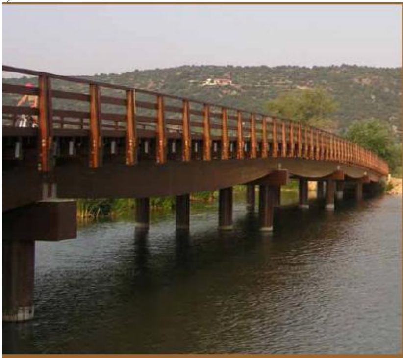
Εικόνα 5 Εκτεθειμένες στις καιρικές συνθήκες ξύλινες κατασκευές (κατηγορία υγρασίας 3)
