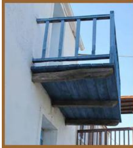
Εικόνα 6 Κατηγορία υγρασίας 2 για τα μέλη που είναι μη εκτεθειμένα, και κατηγορία υγρασίας 3 για τα ξύλινα μέλη που είναι εκτεθειμένα
