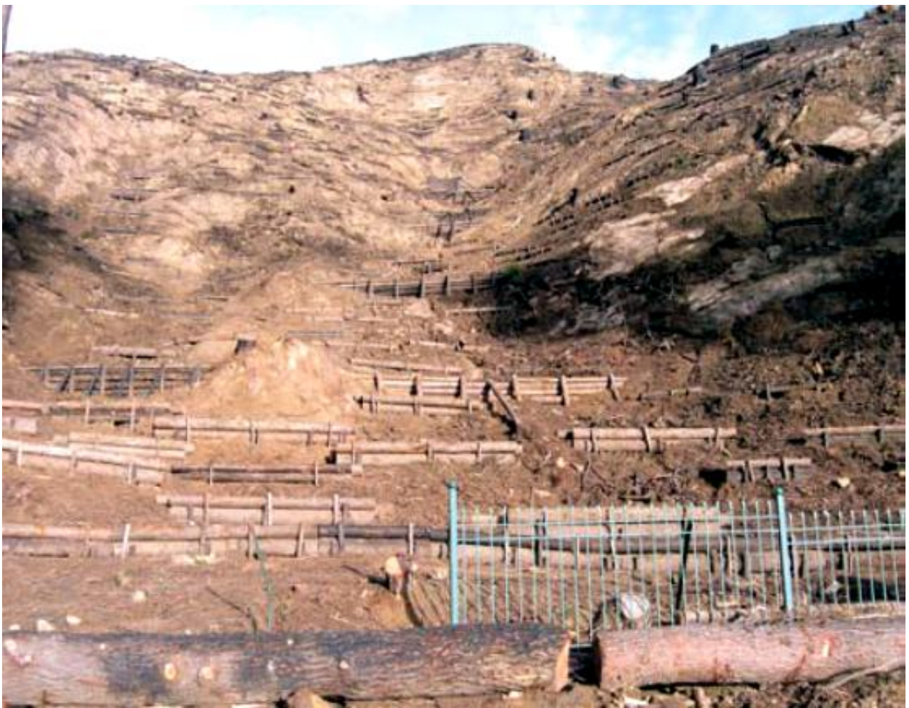
Εικόνα 15, Προστασία παλαιάς γεωλίσθησης στη νότια πλευρά του Κρόνιου λόφου, με την κατασκευή κορμοφραγμάτων και κορμοδεμάτων (2-11-2007)
