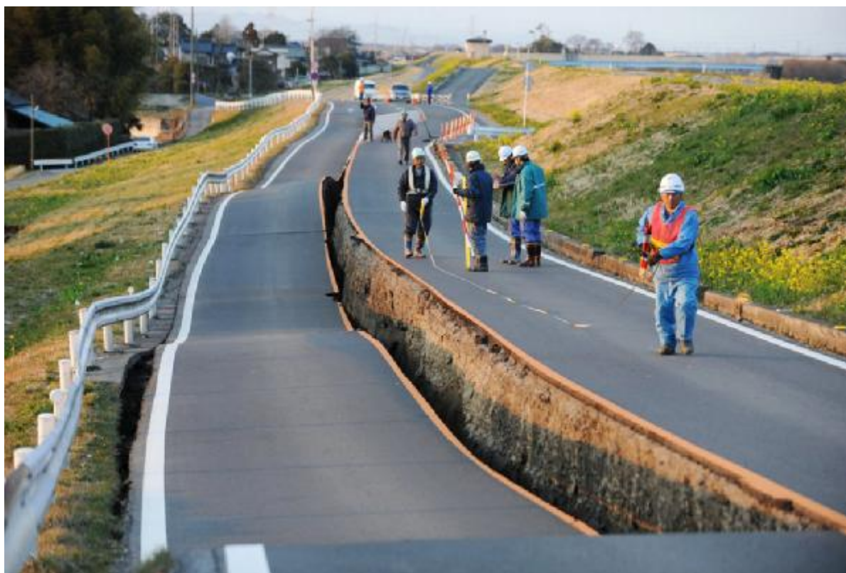
Εικόνα 4, Σεισμικό ρήγμα σε δρόμο της Ιαπωνίας κατά το σεισμό τον Μάρτιο του 2011
