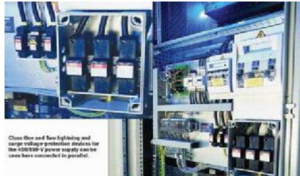
Εικόνα 15: Εκτροπείς υπερτάσεων σε ανεμογεννήτριες [Πηγή: Δαγιόγλου, 2011]
