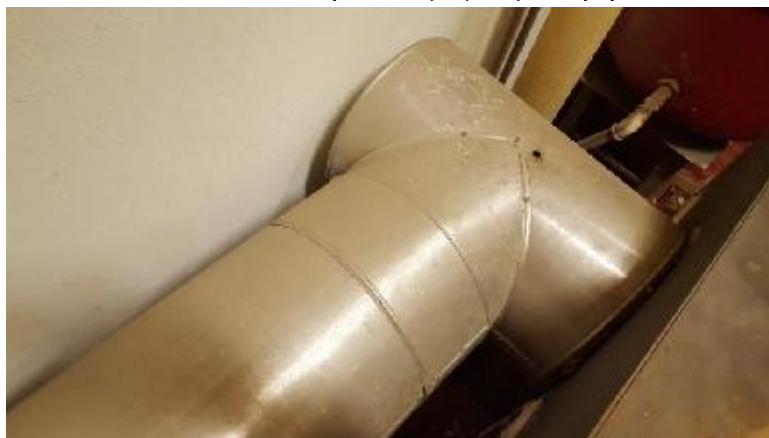
Εικόνα 3.3 : Σύνδεση καπναγωγού με λέβητα
