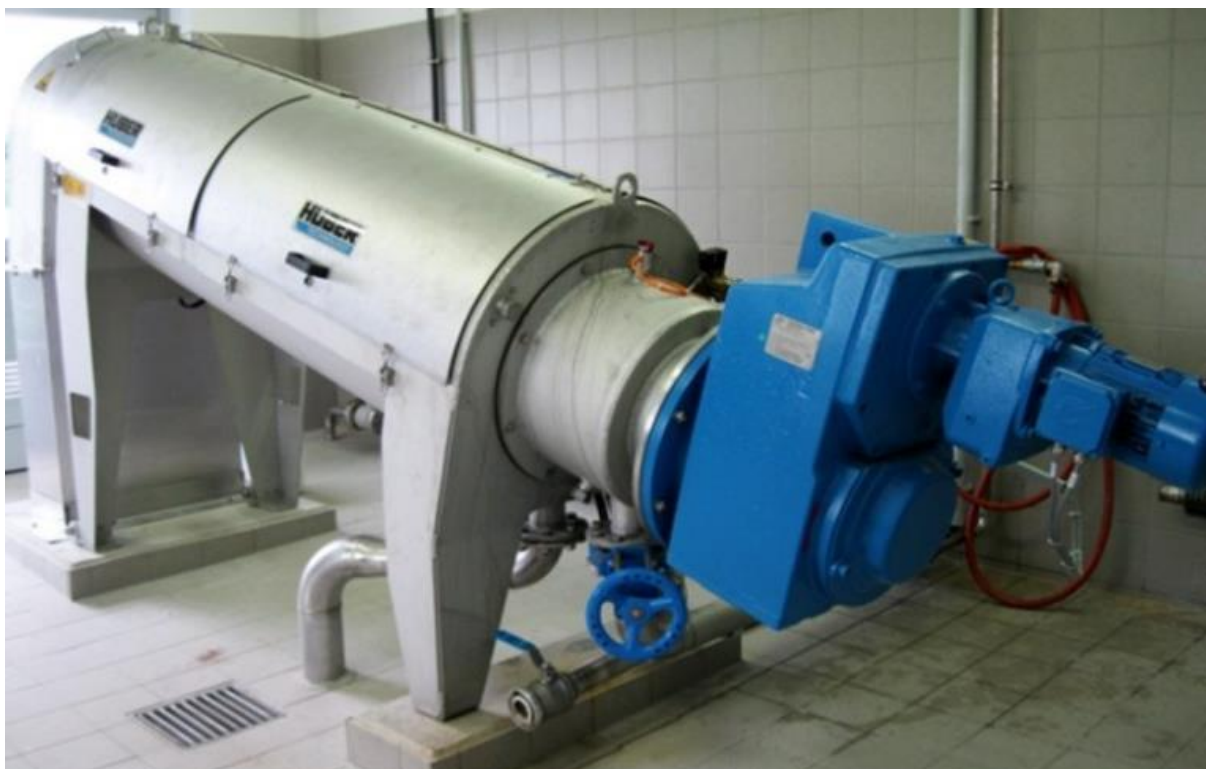
Εικόνα 3.8 Φυγοκεντρικός παχυντής
