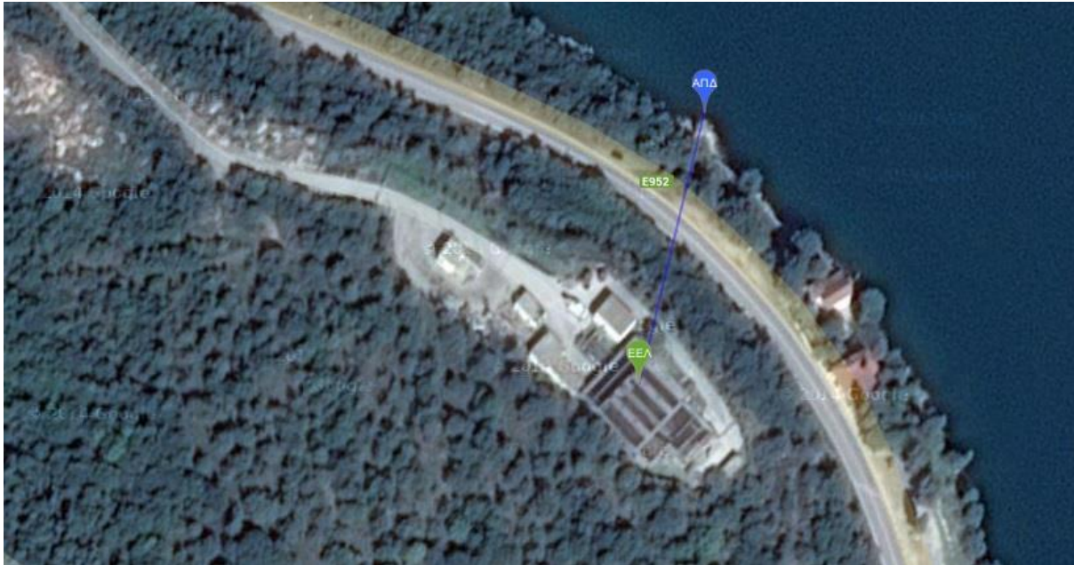
Εικόνα 4.32 Άποψη εγκατάστασης επεξεργασίας λυμάτων από ψηλά, καθώς και του ΑΠΔ : κατάληξη του χερσαίου τμήματος του αγωγού διάθεσης των επεξεργασμένων λυμάτων στον Αμβρακικό Κόλπο
