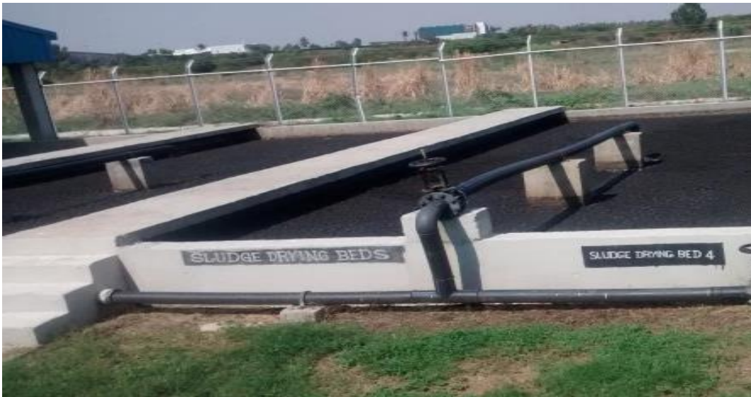
Εικόνα 3.10 Αφυδάτωση με κλίνες ξήρανσης
