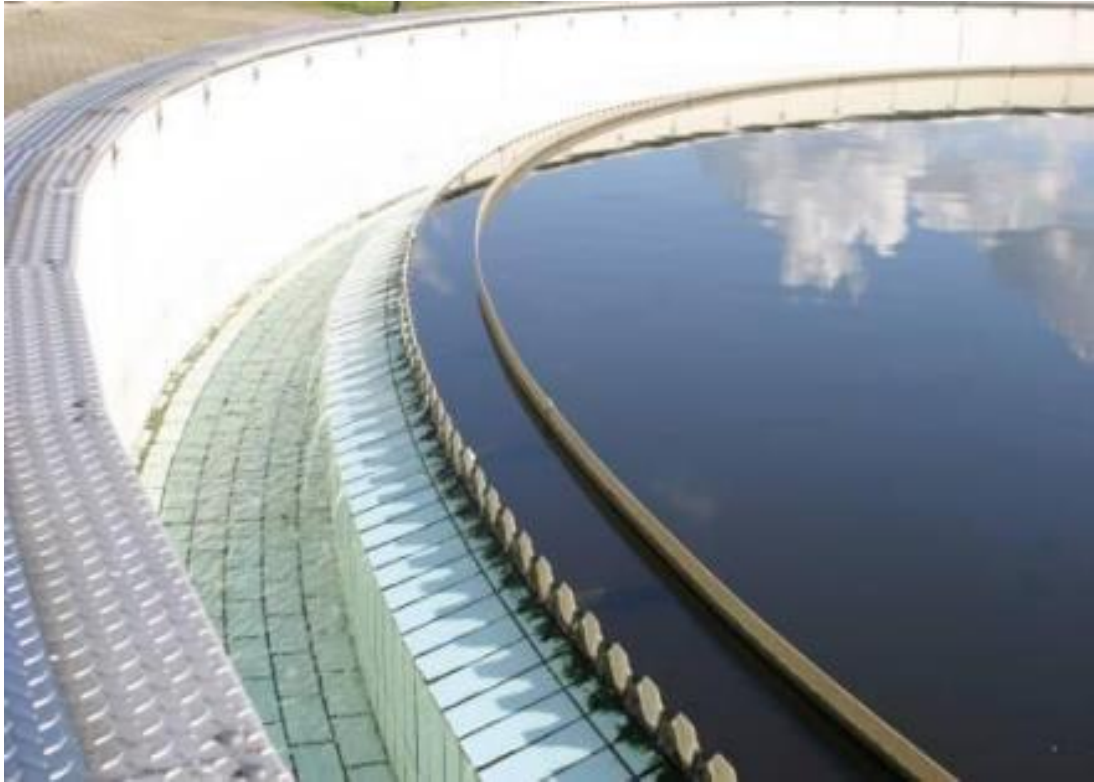
Εικόνα 3.4 Περιφερειακός οδοντωτός υπερχειλιστής
