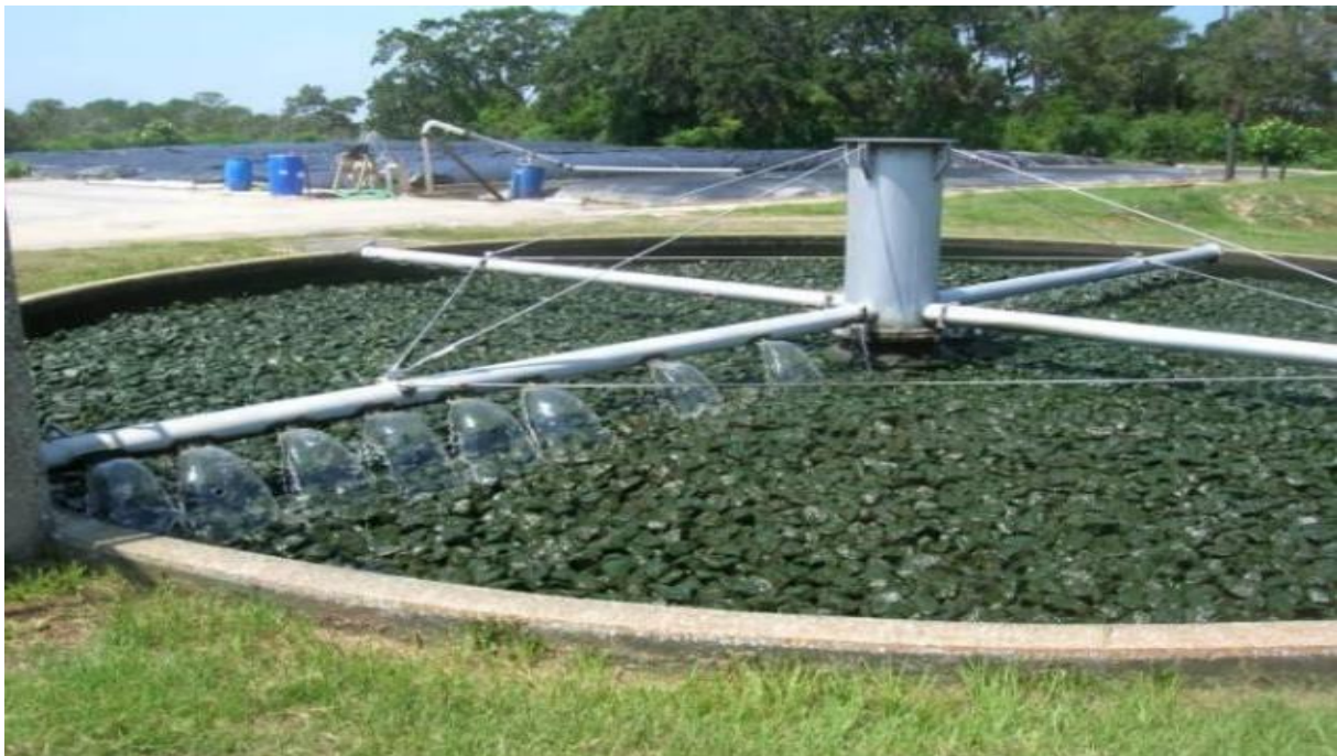
Εικόνα 2.1 Παραδοσιακό Σύστημα Χαλικοδιυλιστηρίου
