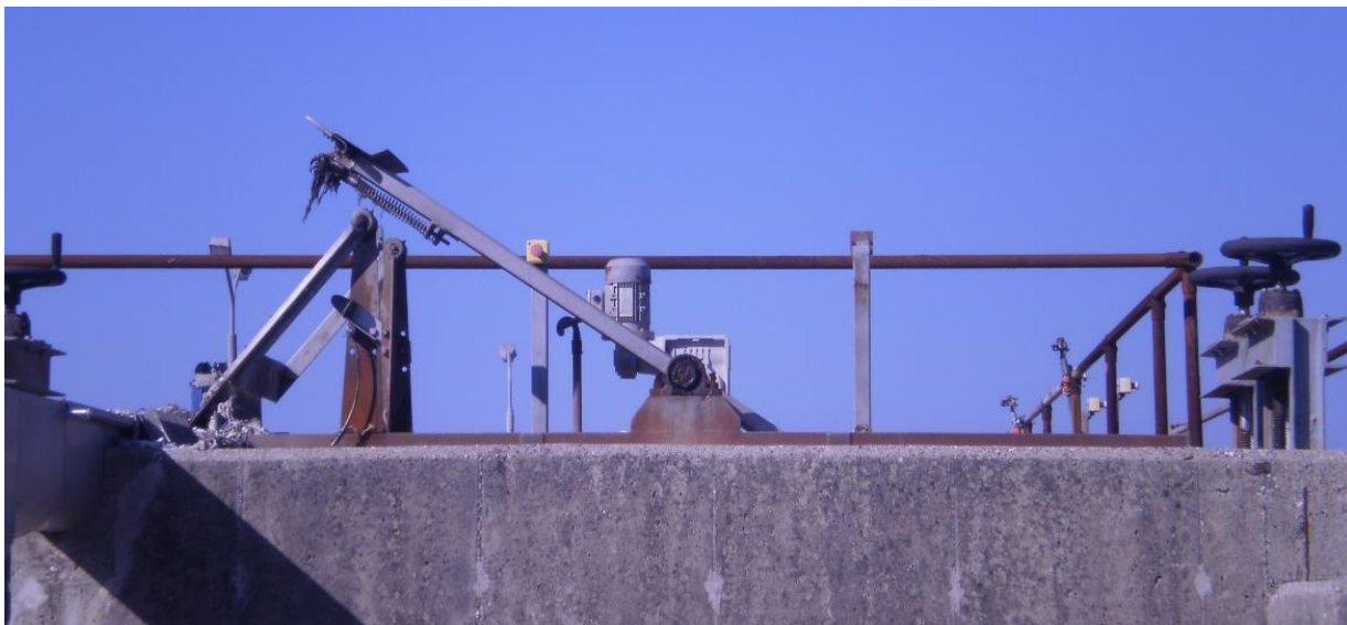
Εικόνα 4.6 Μηχανισμός καθαρισμού σχάρας
