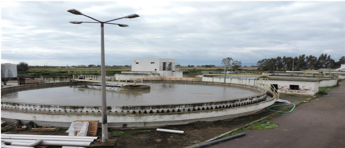
Εικόνα 3.5 Δεξαμενή τελικής καθίζησης
