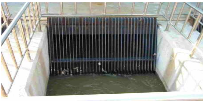
Εικόνα 3.1 Χειροκίνητη εσχάρα
