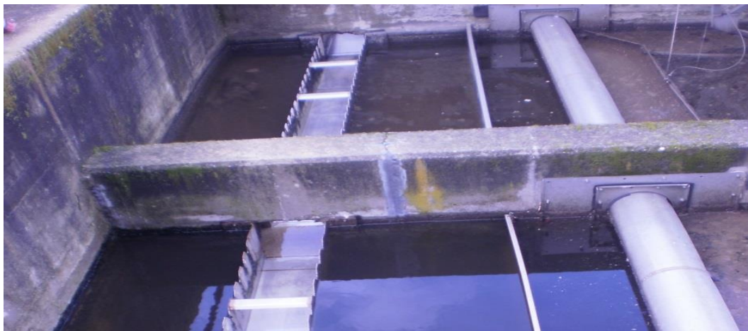
Εικόνα 4.23 Κυλινδρικός σωλήνας συλλογής επιπλέουσας λάσπης και υπερχειλιστής οδοντωτής στέψης
