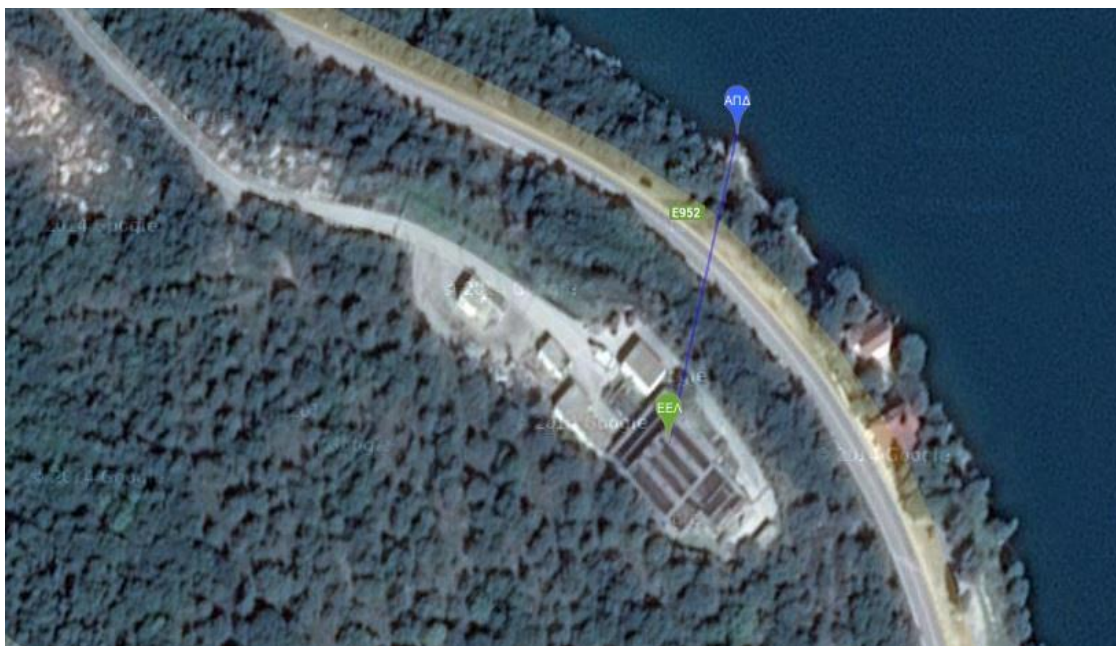
Εικόνα 4.3 : Άποψη εγκατάστασης επεξεργασίας λυμάτων από ψηλά, καθώς και του ΑΠΔ : κατάληξη του χερσαίου τμήματος του αγωγού διάθεσης των επεξεργασμένων λυμάτων στον Αμβρακικό Κόλπο.
