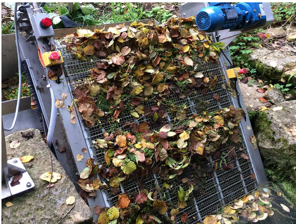
Εικόνα 3.2 Μηχανική αυτοκαθαριζόμενη εσχάρα
