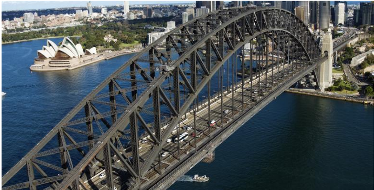
Σχήμα 2.3 Η γέφυρα του Σύδνεϋ [9]
