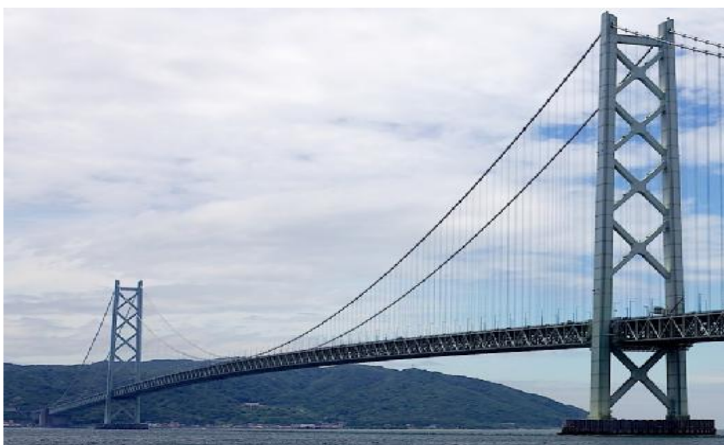
Σχήμα 2.2 Γέφυρα Ακάσι Καικιό [9]
