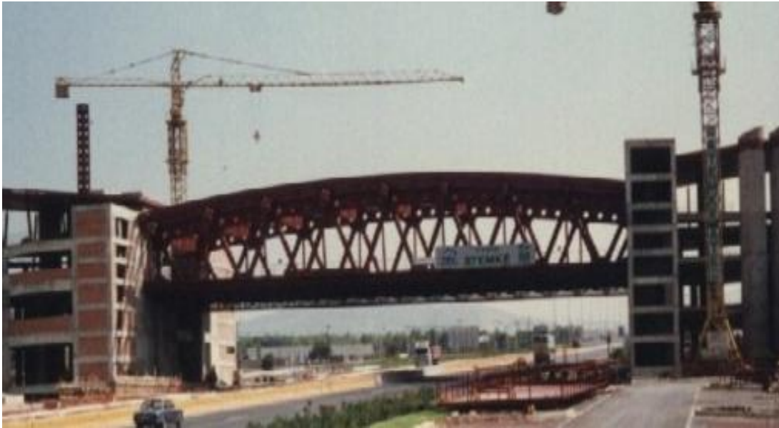
Σχήμα 3.1 Άποψη της μεταλλικής πεζογέφυρας που αναλύεται.
