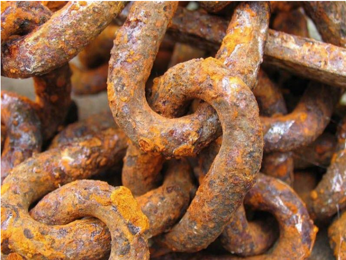
Εικόνα 1: Φαινόμενο διάβρωσης σε μέταλλο (αλυσίδα άγκυρας) 1
