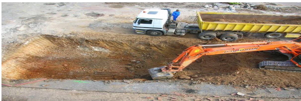
Εικόνα 5- Εκσκαφή (διαδικτυακή πηγή 6)
