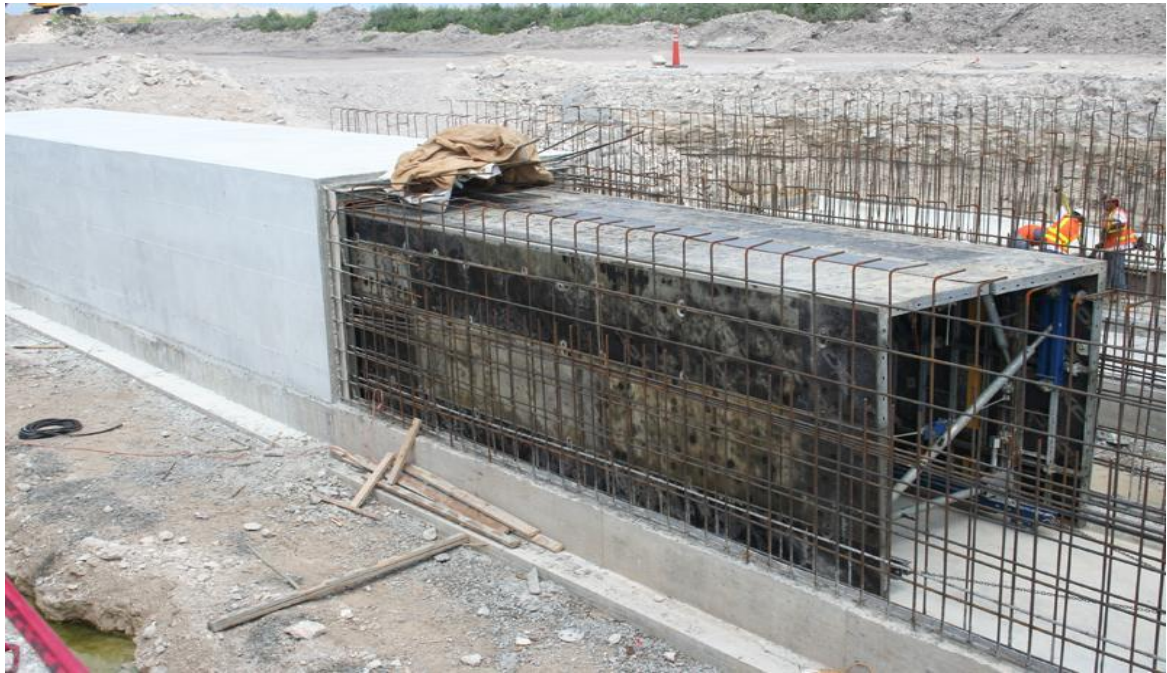
Εικόνα 1 β -Κατασκευή κιβωτοειδούς οχετού (Διαδικτυακή πηγή 1 β )
