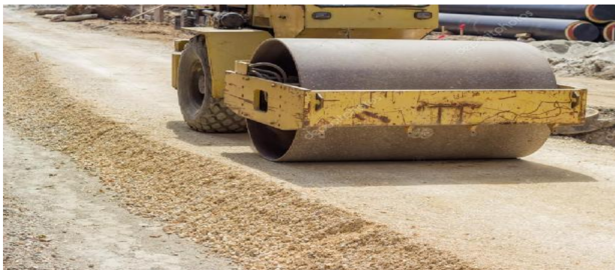
Εικόνα 6- Συμπύκνωση εδαφικού υλικού (διαδικτυακή πηγή 7)
