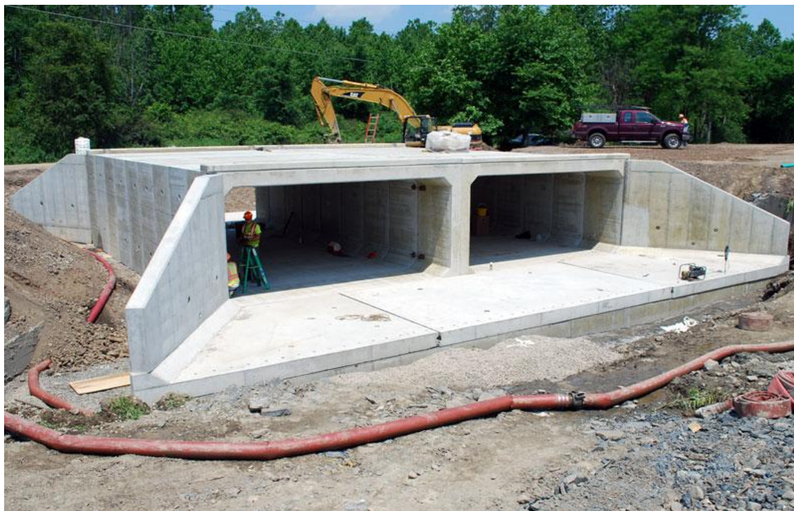
Εικόνα 1 α – Κατασκευασμένος οχετός με 2 ανοίγματα (Διαδυκτιακή πηγή 1 α )
