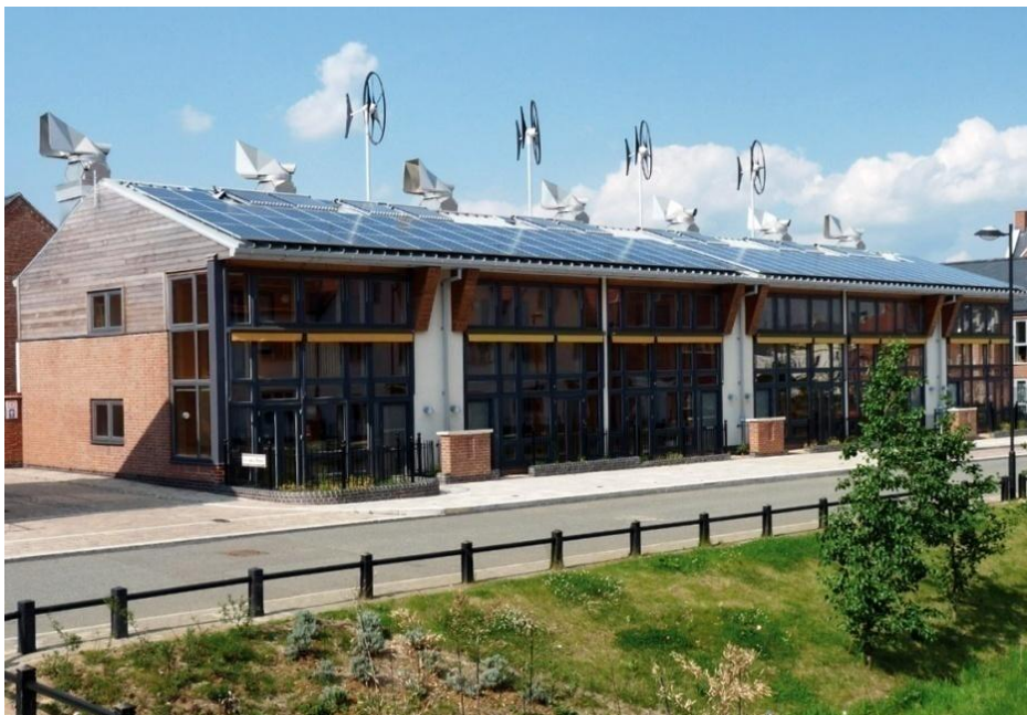
Εικόνα 5. 1 Υβριδικό σύστημα παραγωγής ηλεκτρικής ενέργειας αποτελούμενο από φωτοβολταϊκά πλαίσια και ανεμογεννήτριες ενσωματωμένο στην οροφή κτιρίου.
