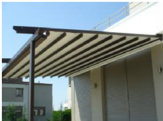
Εικόνα 17-Κινητό σύστημα σκίασης σε πρόσοψη κατοικίας
