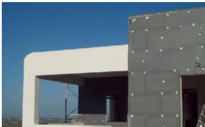
Εικόνα 23-Τοποθέτηση Εξωτερικής Θερμομόνωσης σε κτίριο Κατοικίας
