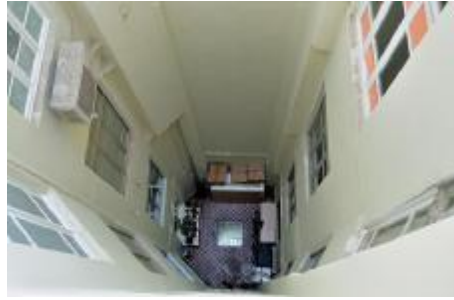
Εικόνα 34-Φωταγωγός σε πολυκατοικία
