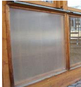
Εικόνα 35-Διαφανής Μόνωση σε κούφωμα
