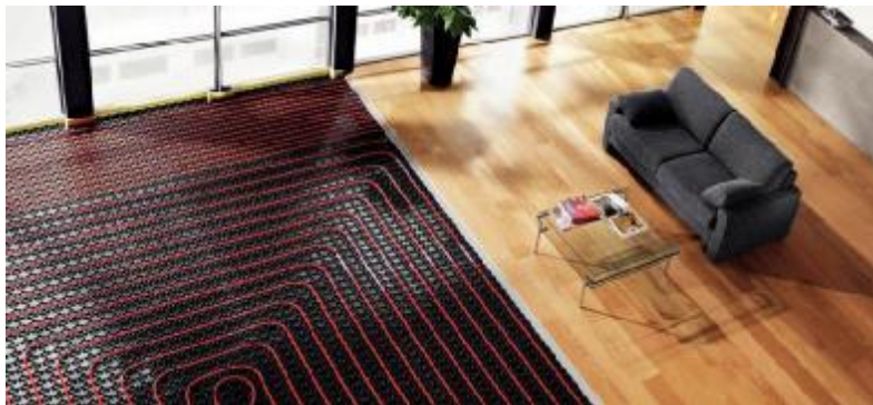
Εικόνα 46-Ενδοδαπέδια Θέρμανση σε Κατοικία
