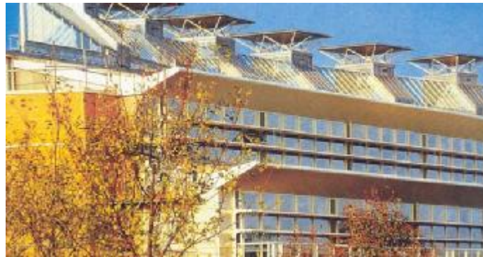
Εικόνα 24-IONICA, Κτήριο Γραφείων στο Cambridge - καμινάδες αερισμού (Αρχιτ: R. H.Partnership, 1994)
