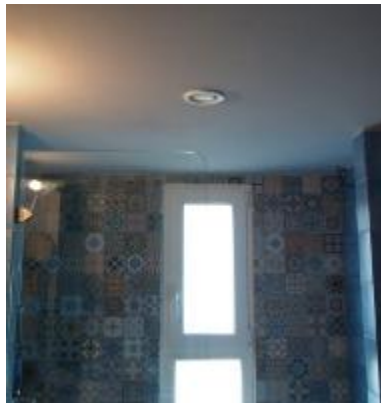
Εικόνα 50-Σύστημα μηχανικού αερισμού σε λουτρό κατοικίας
