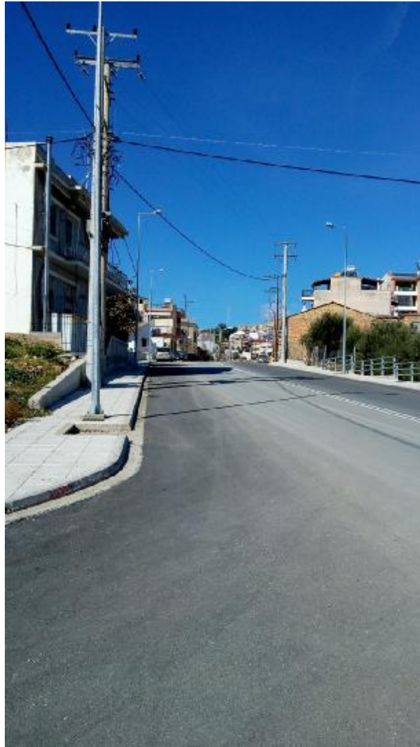
Εικόνα 7. Τμήμα της οδού
