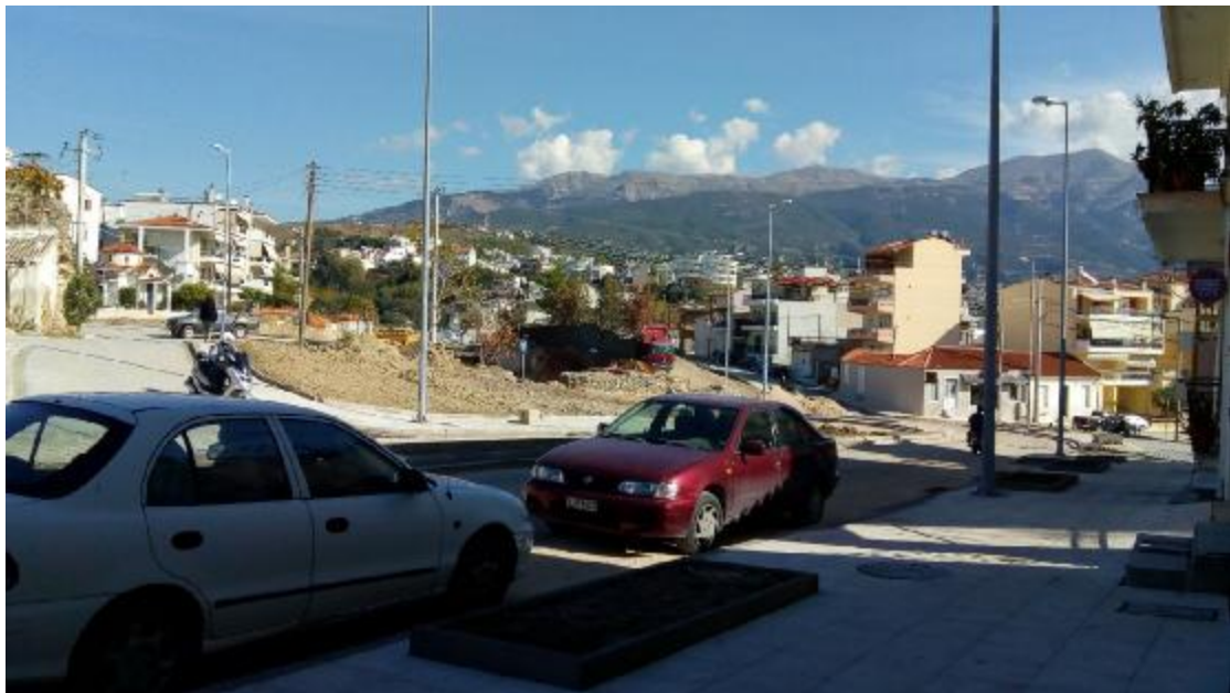
Εικόνα 8.Κόμβος μικρής περιμετρικής ανατολικά του Κάστρου της Πάτρας.
