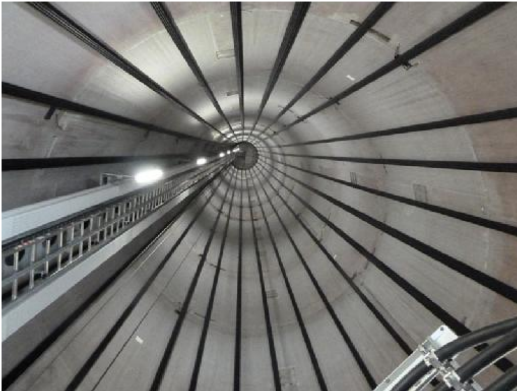
Εικόνα 3.6: Εσωτερική άποψη του πύργου της ανεμογεννήτριας.
