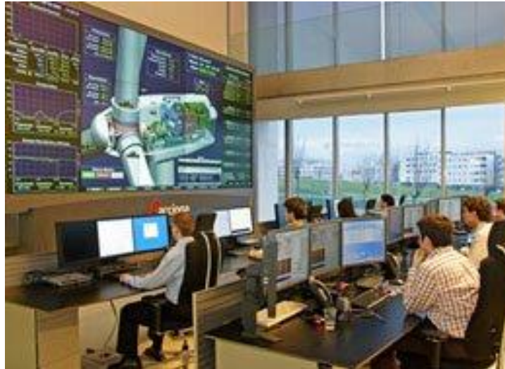
Εικόνα 4.6: Μονάδα απομακρυσμένου ελέγχου αιολικού πάρκου.
