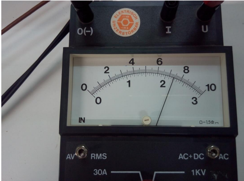
Σχήμα 7.14: Ένδειξη τάσης μετατροπέα 220 V
