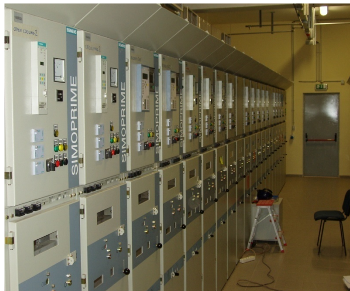
ΕΙΚΟΝΑ 39: Δίθουσα Μ.Τ ΒΒΑ και τροφοδοσιών
