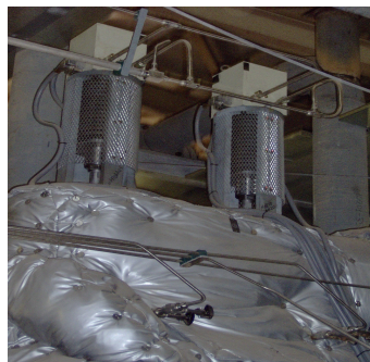
ΕΙΚΟΝΑ 28: Βάνες ελέγχου (CV)
