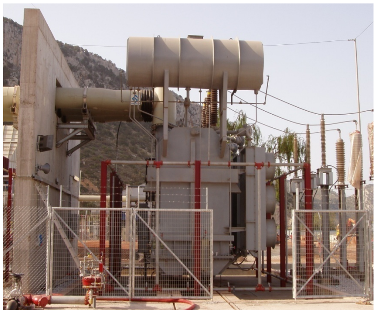
ΕΙΚΟΝΑ 34: Μ/Σ ανυψώσεως γεννητριών αεροστροβίλων
