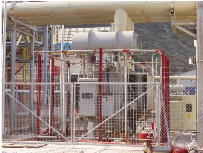
ΕΙΚΟΝΑ 36: Μ/Σ τροφοδοσίας βοηθητικών
