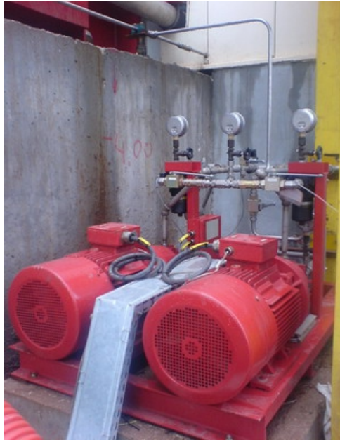
ΕΙΚΟΝΑ 22: Υδραυλικό σύστημα ανύψωσης άξονα
