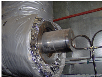
ΕΙΚΟΝΑ 27: Βάνα διακοπής λειτουργίας εκτάκτου ανάγκης (ESV)
