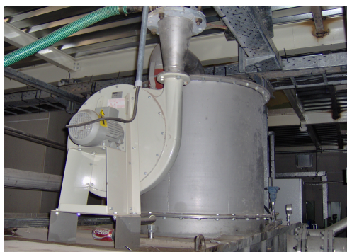
ΕΙΚΟΝΑ 75: Μονάδα φίλτρων ατμών λαδιού (oil mist)
