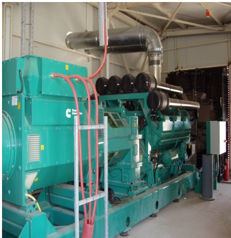
ΕΙΚΟΝΑ 41: Γεννήτρια πετρελαίου έκτακτης ανάγκης.
