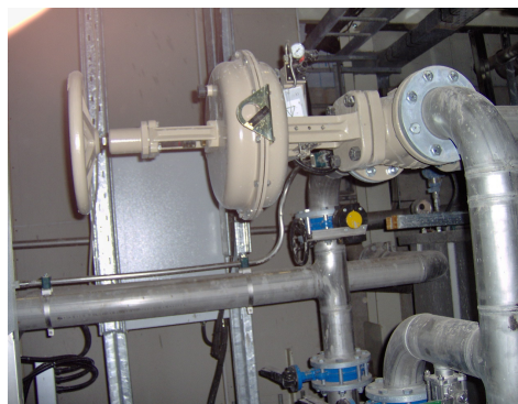
ΕΙΚΟΝΑ 73: Βάνα ελέγχου λαδιού
