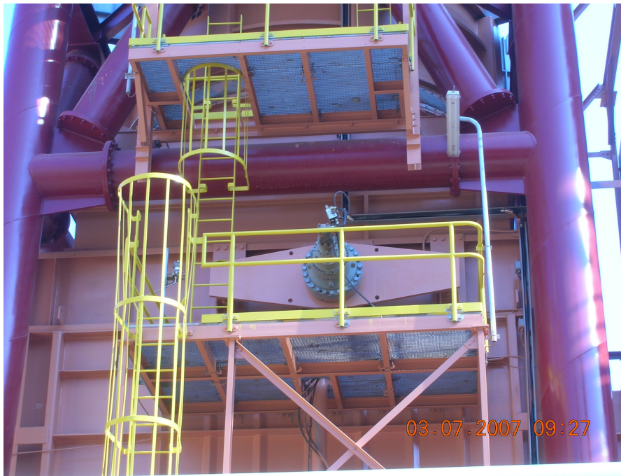
ΕΙΚΟΝΑ 52: Διαχωριστικός μηχανισμός των καυσαερίων
