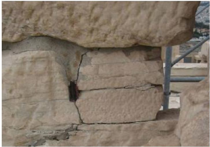
Θραύση μαρμάρου λόγω διόγκωσης λανθασμένου υλικού των συνδέσμων από προηγούμενη συντήρηση
