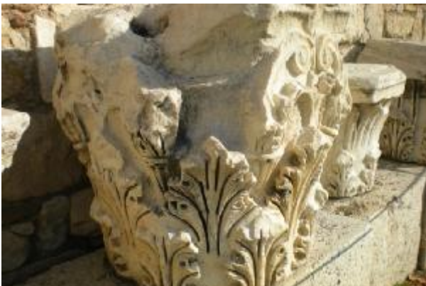
Καταστροφή της δομής του μαρμάρου και ασβεστοποίηση αυτού
