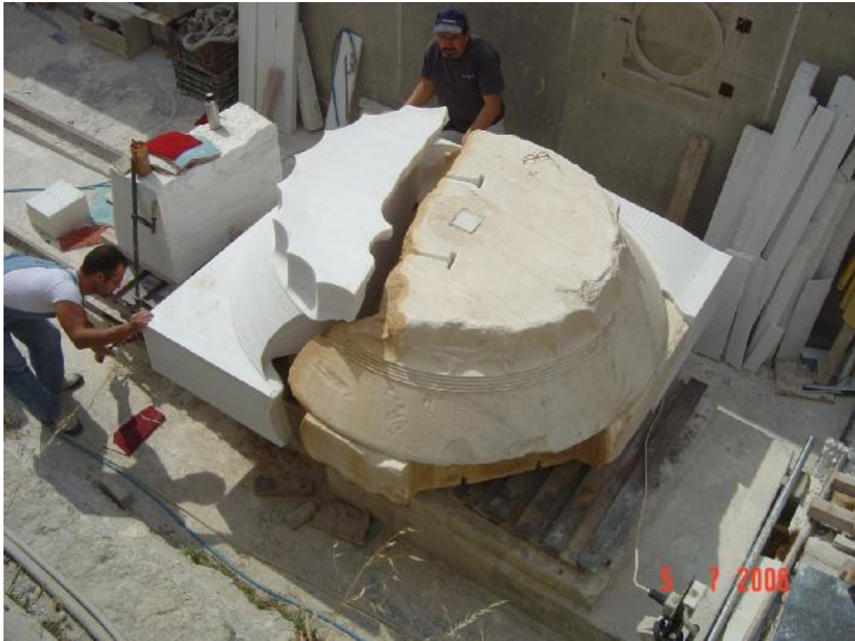
Συμπλήρωση επιπρόσθετου υλικού, στο οποίο γίνεται εμφανής η διαφορά του σε σχέση με το αρχαίο
