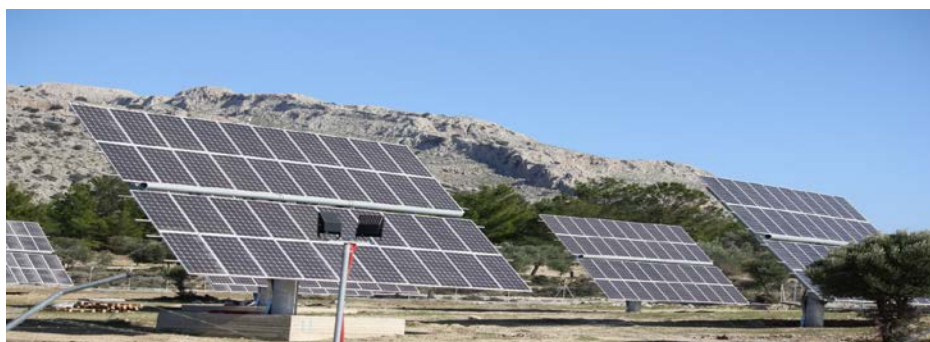
Εικόνα 2.40: Φωτοβολταϊκή εγκατάσταση με συστήματα tracking
