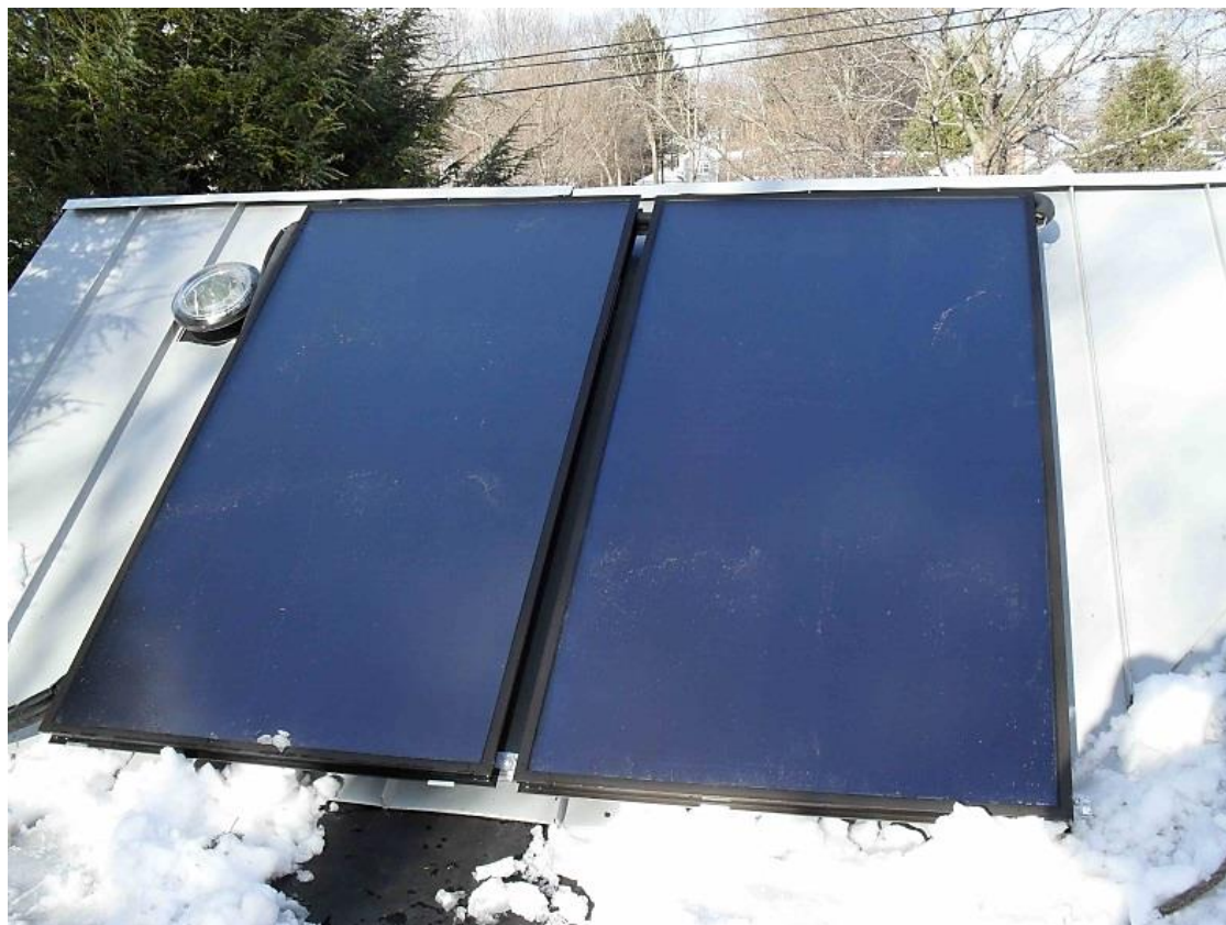
Εικόνα 3.11: Επίπεδοι Ηλιακοί Συλλέκτες σε κατοικία σε περιοχή με ψυχρό κλίμα
