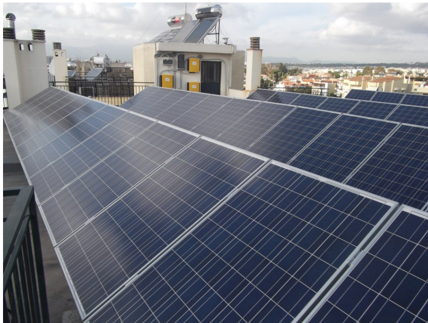
Εικόνα 2.38: Πάνελ στοιχισμένα σε σταθερή βάση για παραγωγή ρεύματος σε οικία στην περιοχή της Πάτρας
