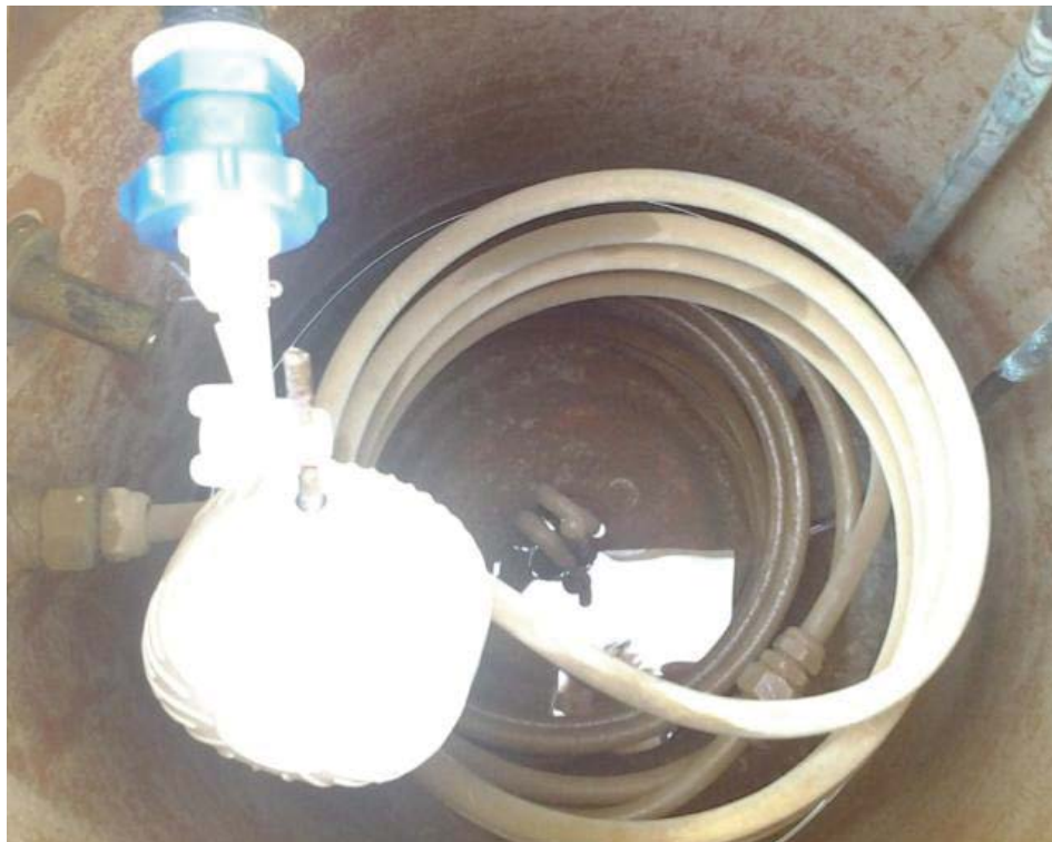
Εικόνα 5.11 : Αδειασμα δεξαμενής αποθήκευσης ζεστού νερού του οικίσκου κατά την πειραματική διαδικασία
