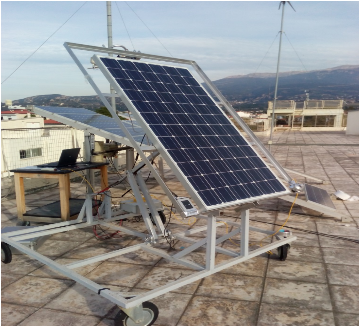
Εικόνα 2.34: Πάνελ προσανατολισμένο νότια στην οροφή του εργαστηρίου ΑΠΕ
