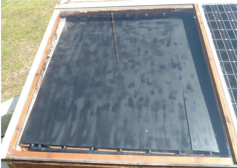
Εικόνα 5.9 : Καθαρισμός συλλέκτη στέγης του Ενεργειακού οικίσκου
