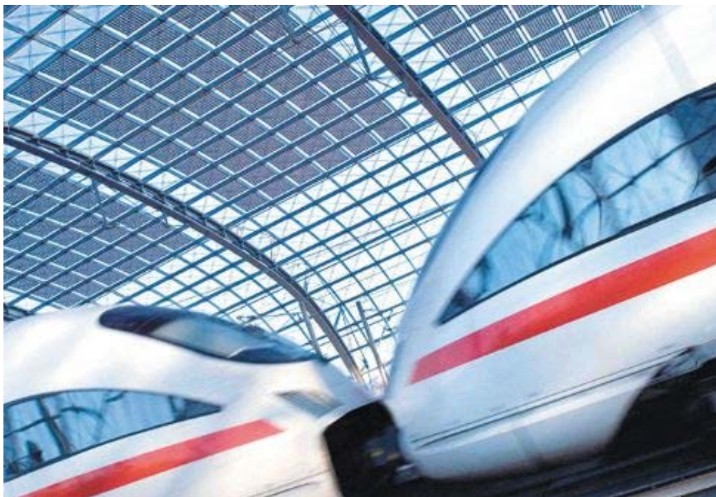
Εικόνα 2.44: Ενσωματωμένο σε κτίριο Φ/Β Σύστημα
