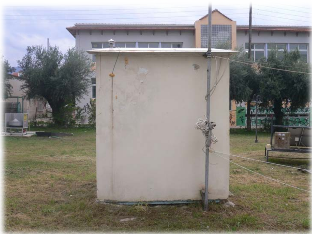
Εικόνα 4.24:βόρεια πλευρά οικίσκου
