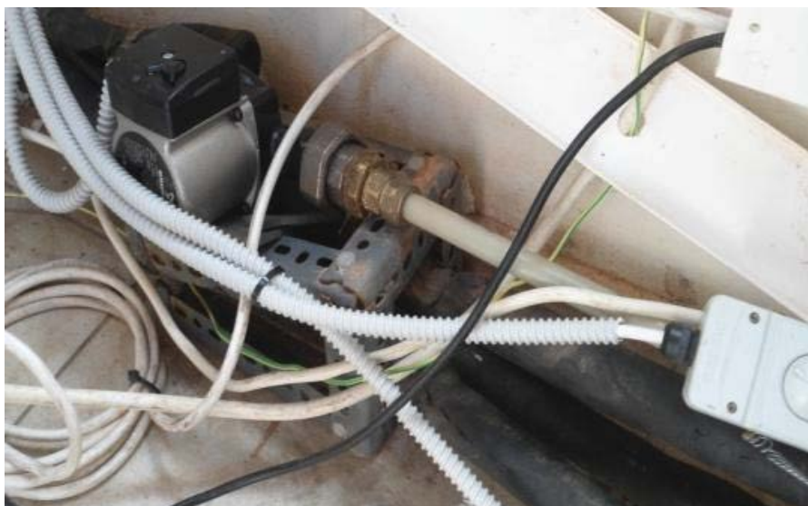
Εικόνα 4.39: Κυκλοφορητής ενδοδαπέδιας θέρμανσης
