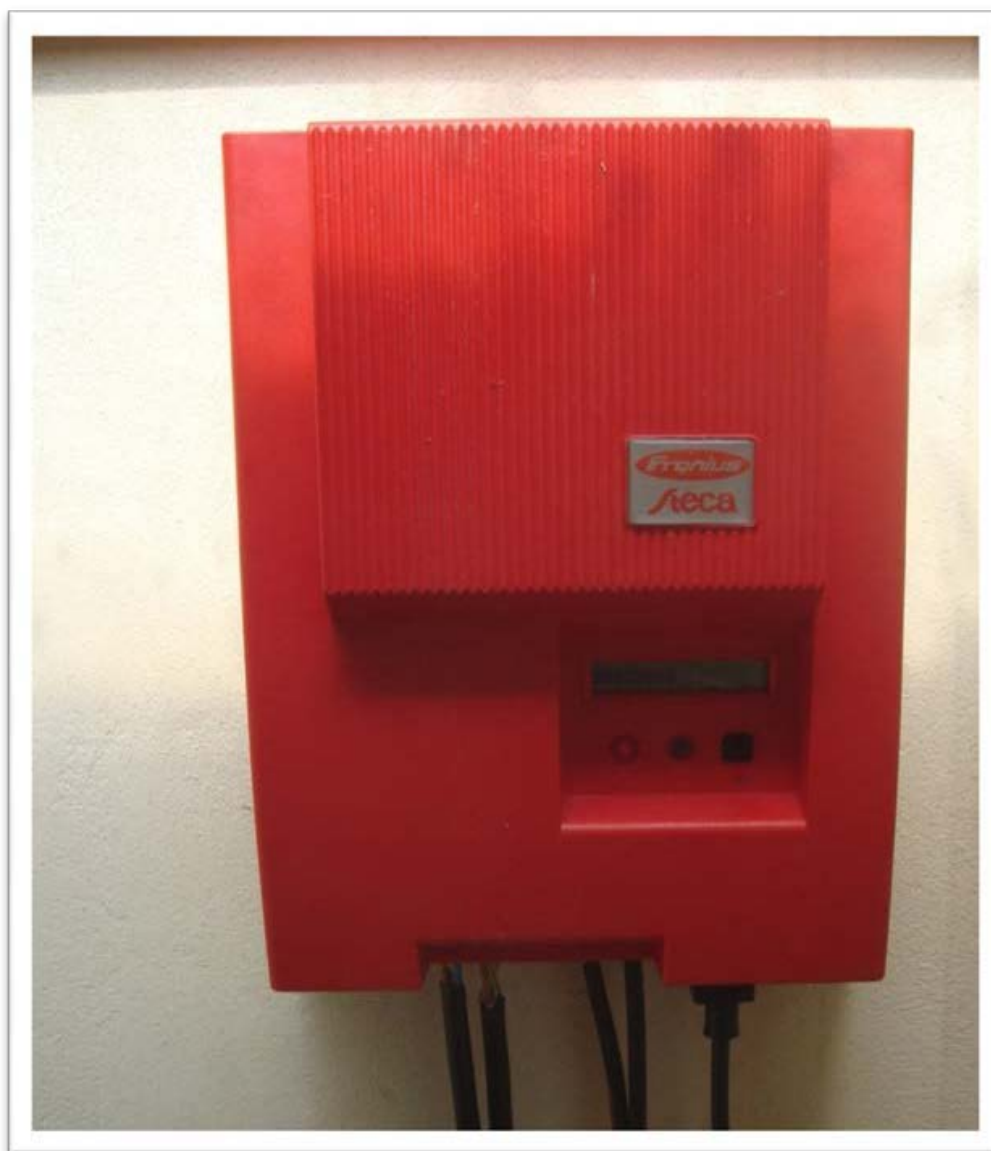
Εικόνα 4.46: Μετατροπέας (inverter) DC/AC STECCA 900 RI)
