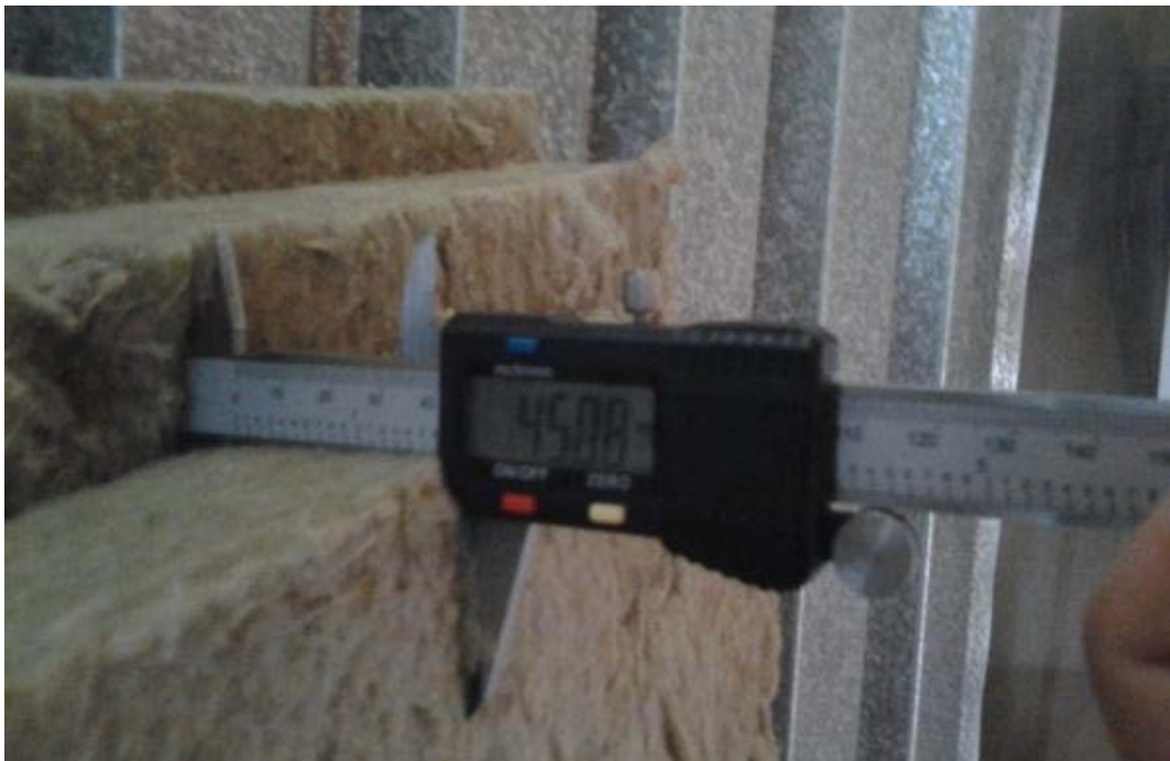
Εικόνα 5.17 : Μόνωση συλλέκτη στέγης οικίσκου
