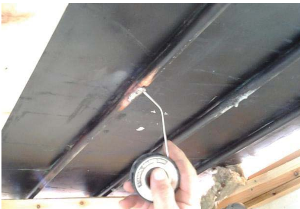
Εικόνα 5.18 : Επισκευές στον συλλέκτη της στέγης
