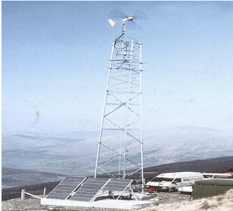
Εικόνα 2.2: Συνδυασμός PV-γεννήτριας-ανεμογεννήτριας σε ορεινή περιοχή μακράν του δικτύου για την κάλυψη των ενεργειακών αναγκών κατά περίπτωση.
