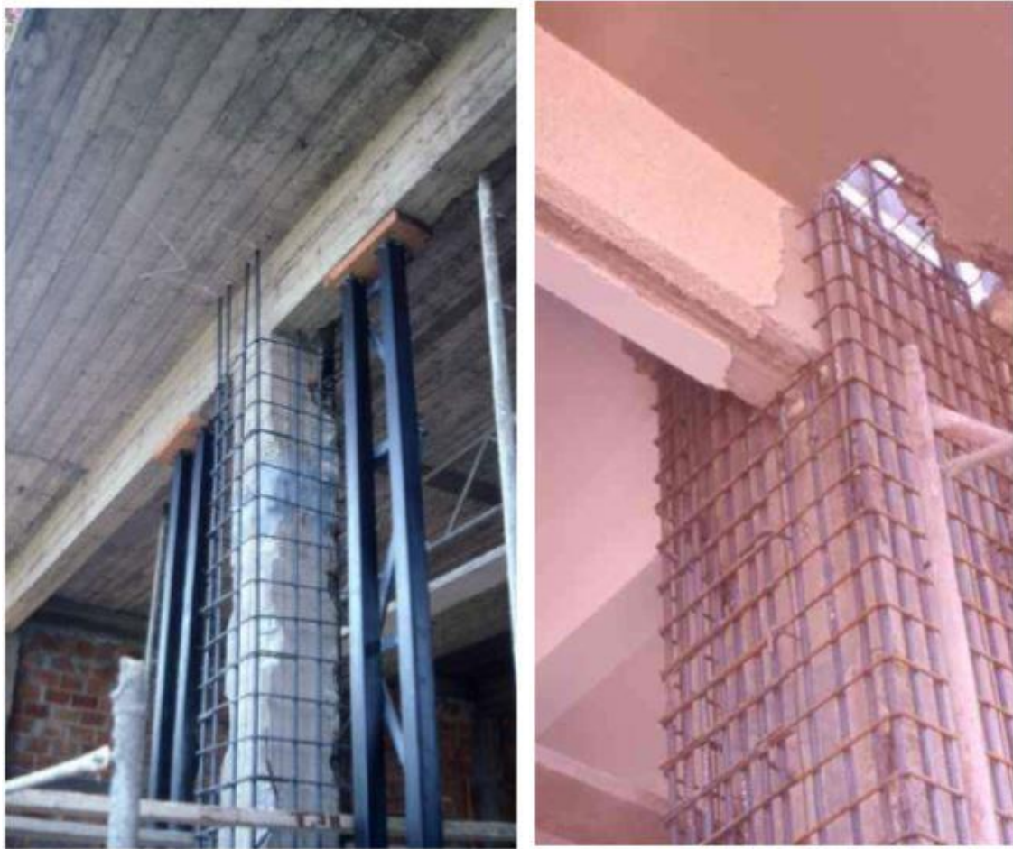
Σχήμα 2.1: Τυπικοί κλωβοί οπλισμού για μανδύες Οπλισμένου Σκυροδέματος (Παναγόπουλος Γ.)
