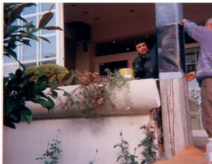
Σχήμα 2.7: Ενίσχυση με μανδύες από ινοπλισμένα πολυμερή (Παναγόπουλος Γ.)
