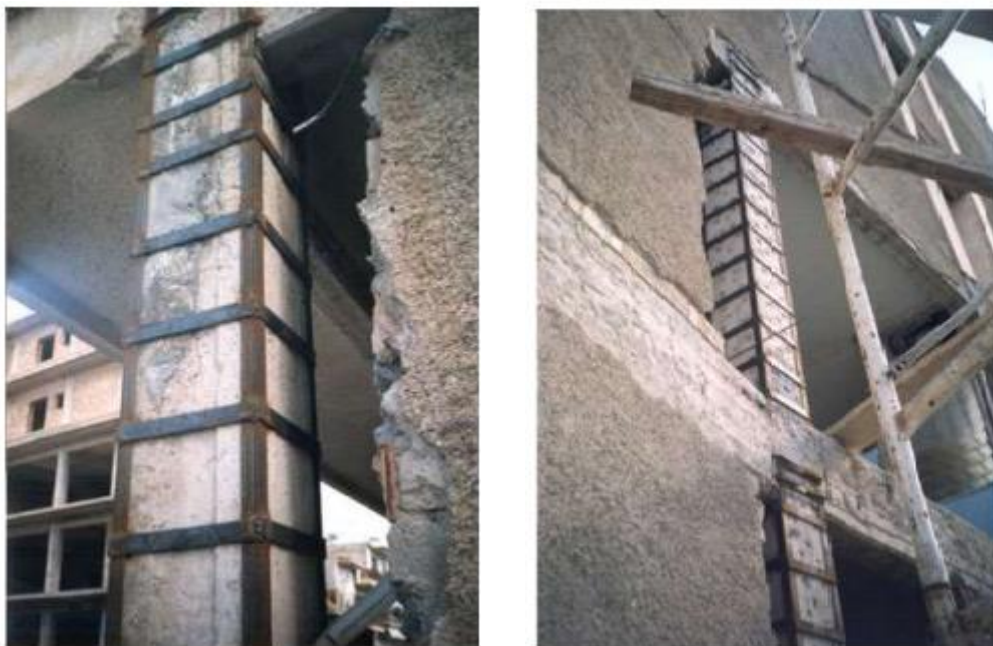
Σχήμα 2.6: Περίσφιγξη με χαλύβδινες λάμες (Παναγόπουλος Γ.)
