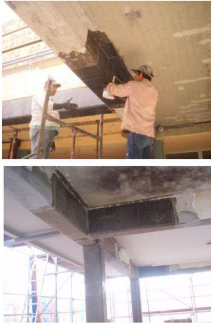
Σχήμα 2.12: Διατμητική ενίσχυση με ινοπλισμένα πολυμερή (μανδύες(Παναγόπουλος Γ.)
