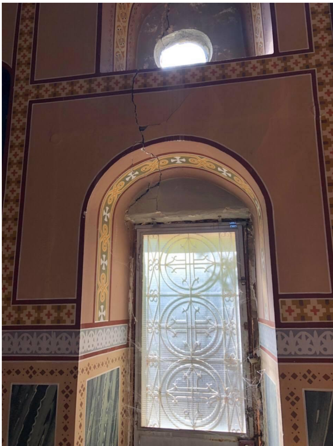
Εικόνα 4.24: Αστοχία που έχει δημιουργηθεί στο παράθυρο
