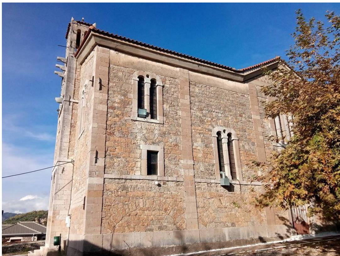
Εικόνα 3.2 : Η κλίση του εδάφους στη Νότια πλευρά της εκκλησίας
