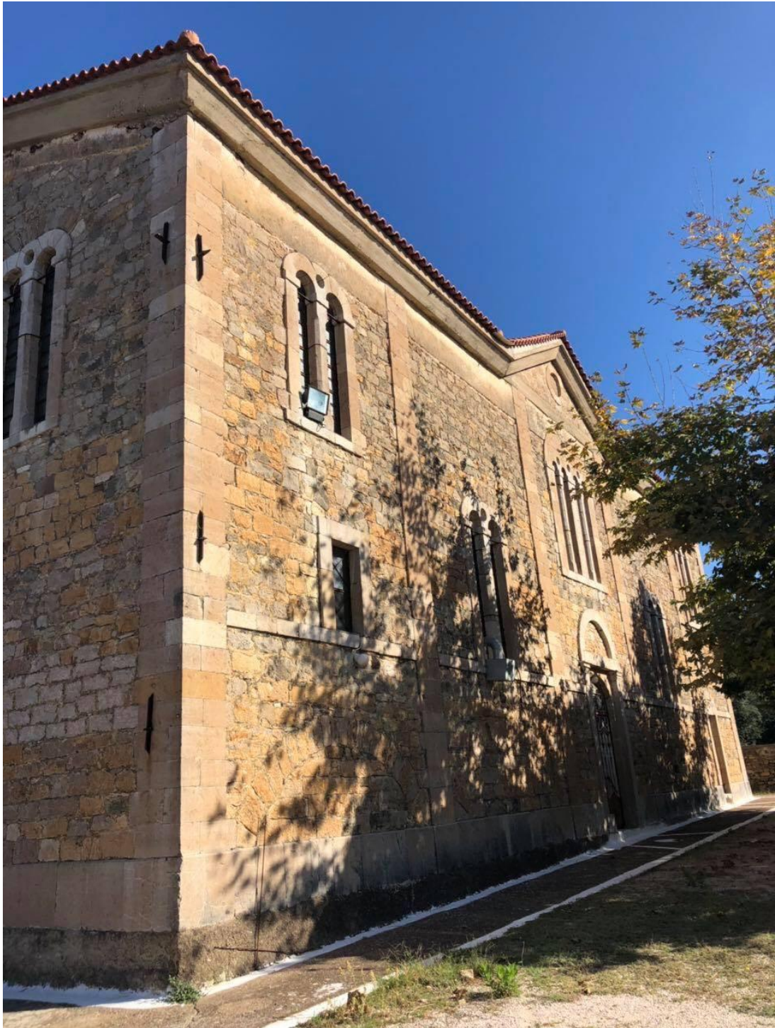
Εικόνα 4.10: Νότια όψη της εκκλησίας
