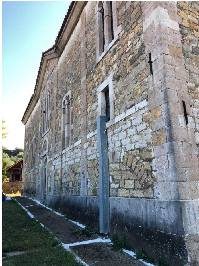
Εικόνα 4.14: Η βόρεια όψη της εκκλησίας
