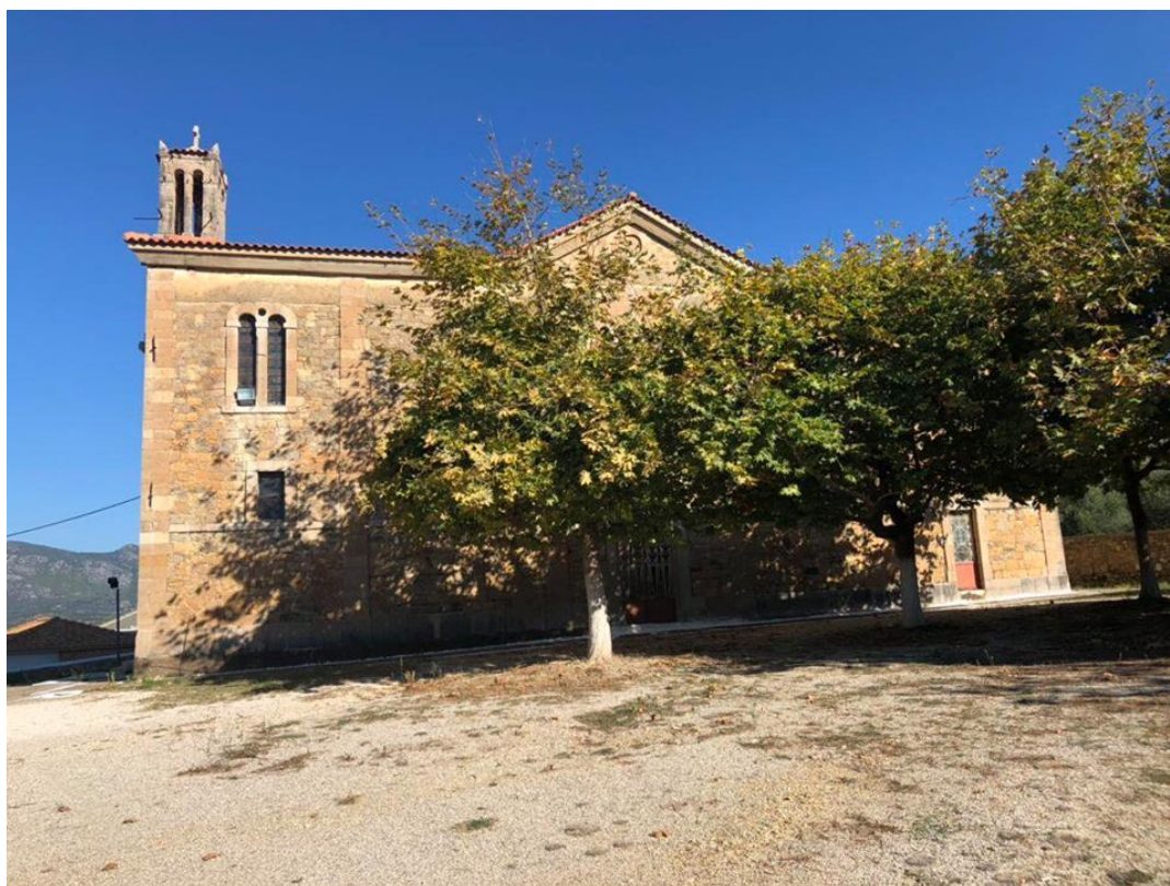
Εικόνα 3.3 : Η κλίση του εδάφους στη Νότια πλευρά της εκκλησίας
