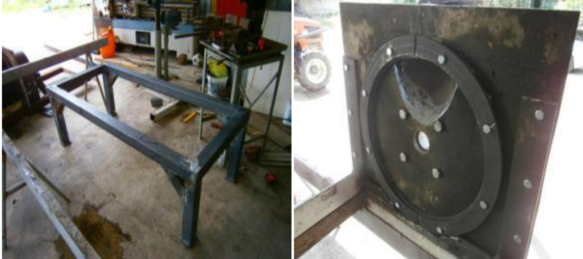
Εικόνα 51: Αρχικό στάδιο κατασκευής.
