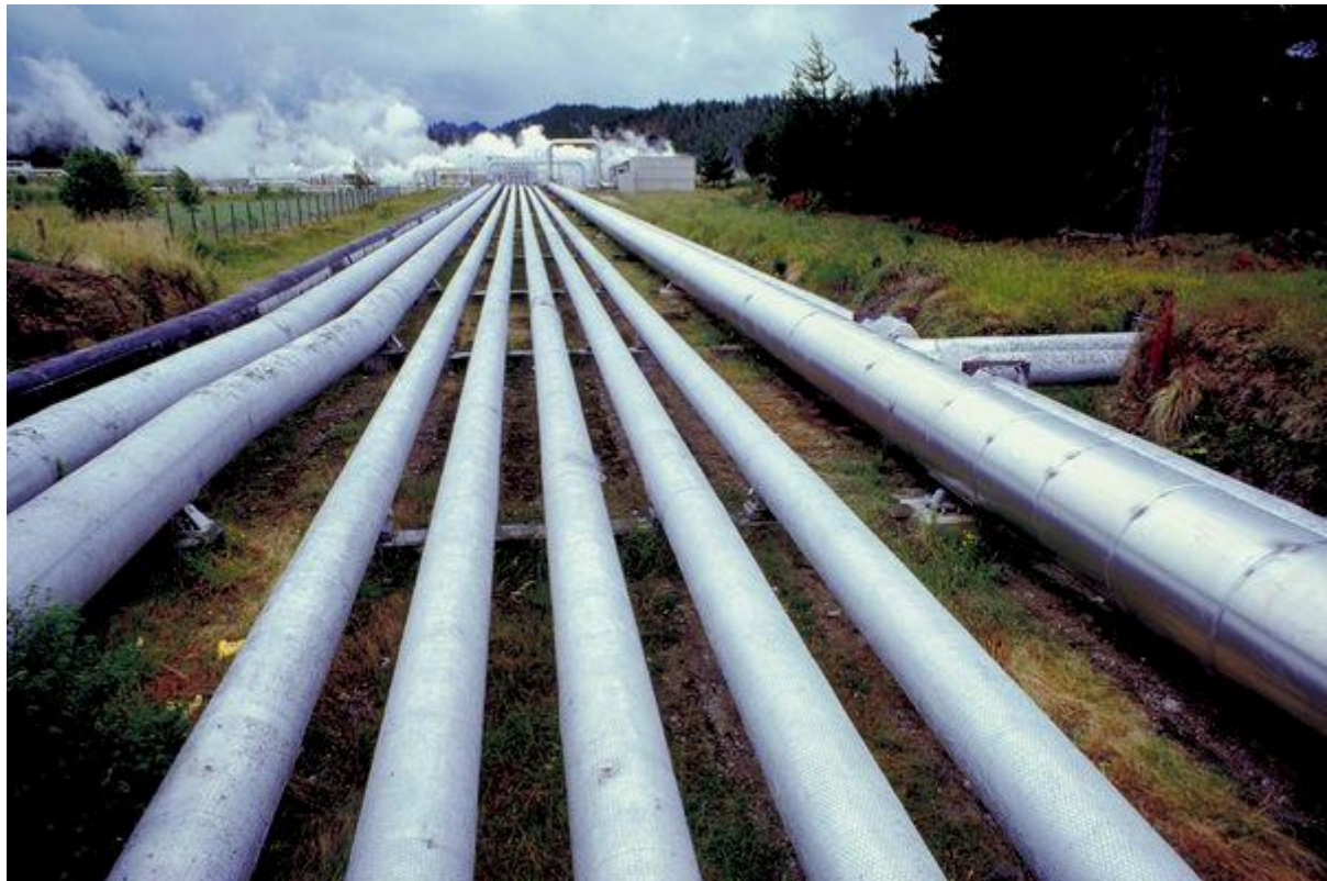
Εικόνα 3.6. Pipe sleeper or track 27
