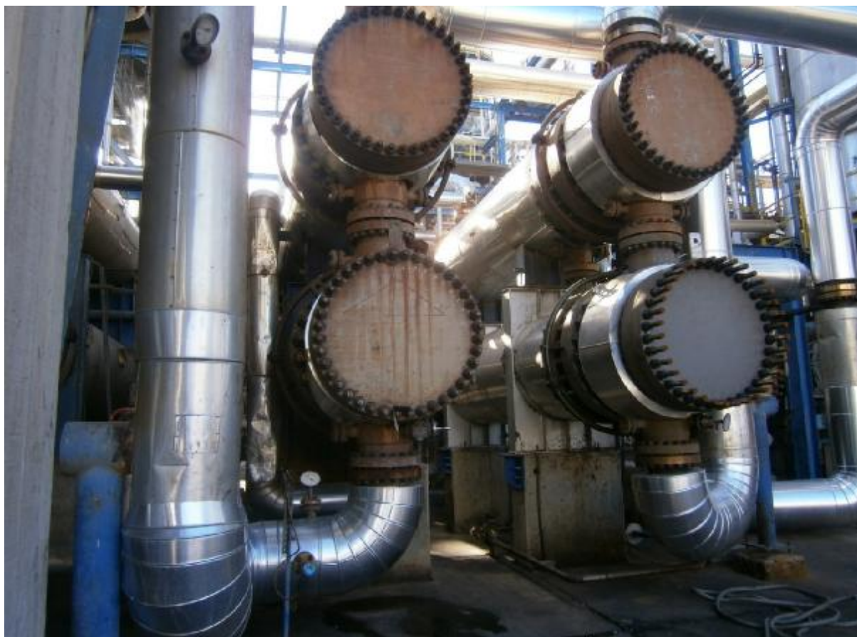
Εικόνα 3.28: Φωτογραφία εναλλακτών από διυλιστήριο σε κατάσταση λειτουργίας 51
