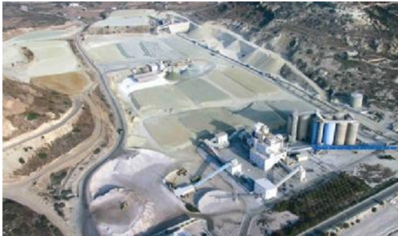
Εικ.1.2 Οι εγκαταστάσεις της εταιρίας S&B Βιομηχανικά Ορυκτά Α.Ε. στα Βούδια
