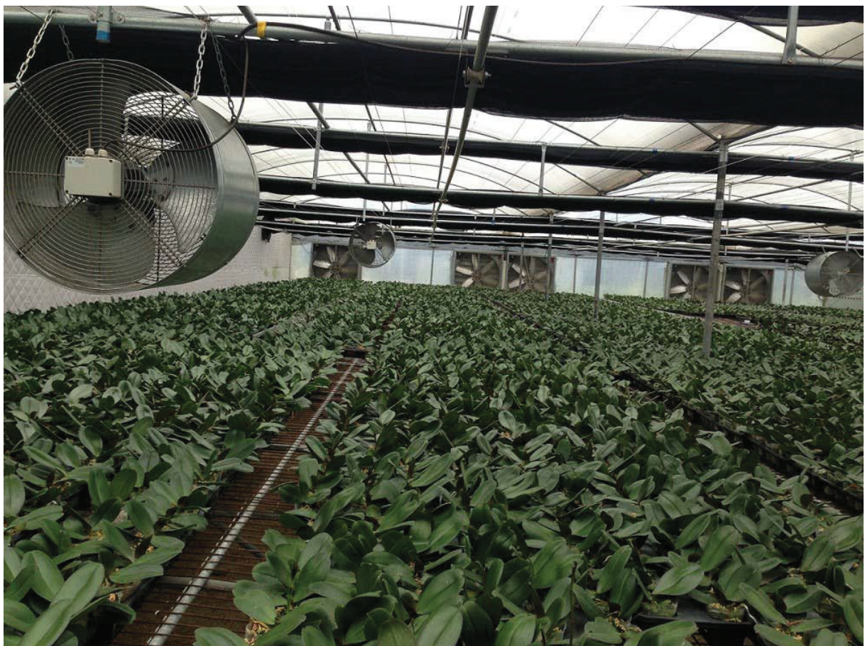
Εικόνα 10. Συστήματα εξαερισμού και ανακυκλοφορίας αέρα σε μεγάλη θερμοκηπιακή μονάδα.
