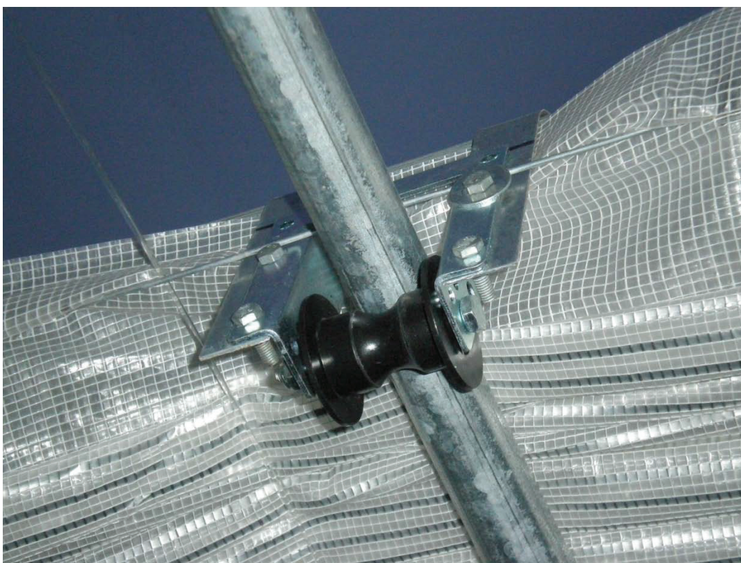
Εικόνα 18. Ράμπα στήριξης με τμήμα του μηχανισμού αναδίπλωσης θερμοκουρτίνας αλουμινίου.
