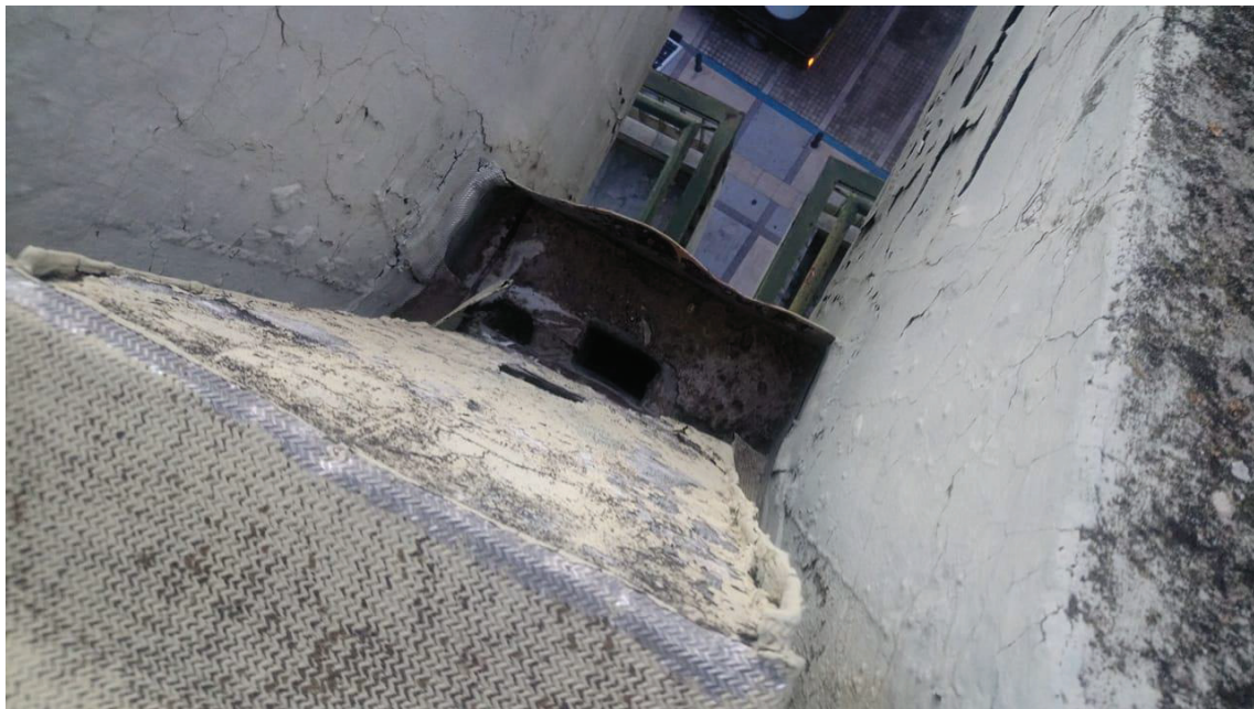
Εικόνα 2. Εκβολή υδρορροής δώματος
