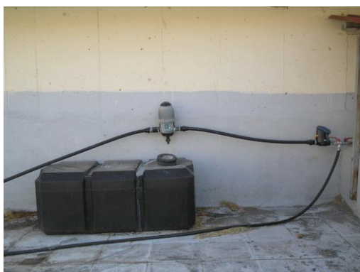
Εικόνα 3. Δοσομετρική εγχυτική αντλία και δοχείο βασικού διαλύματος
