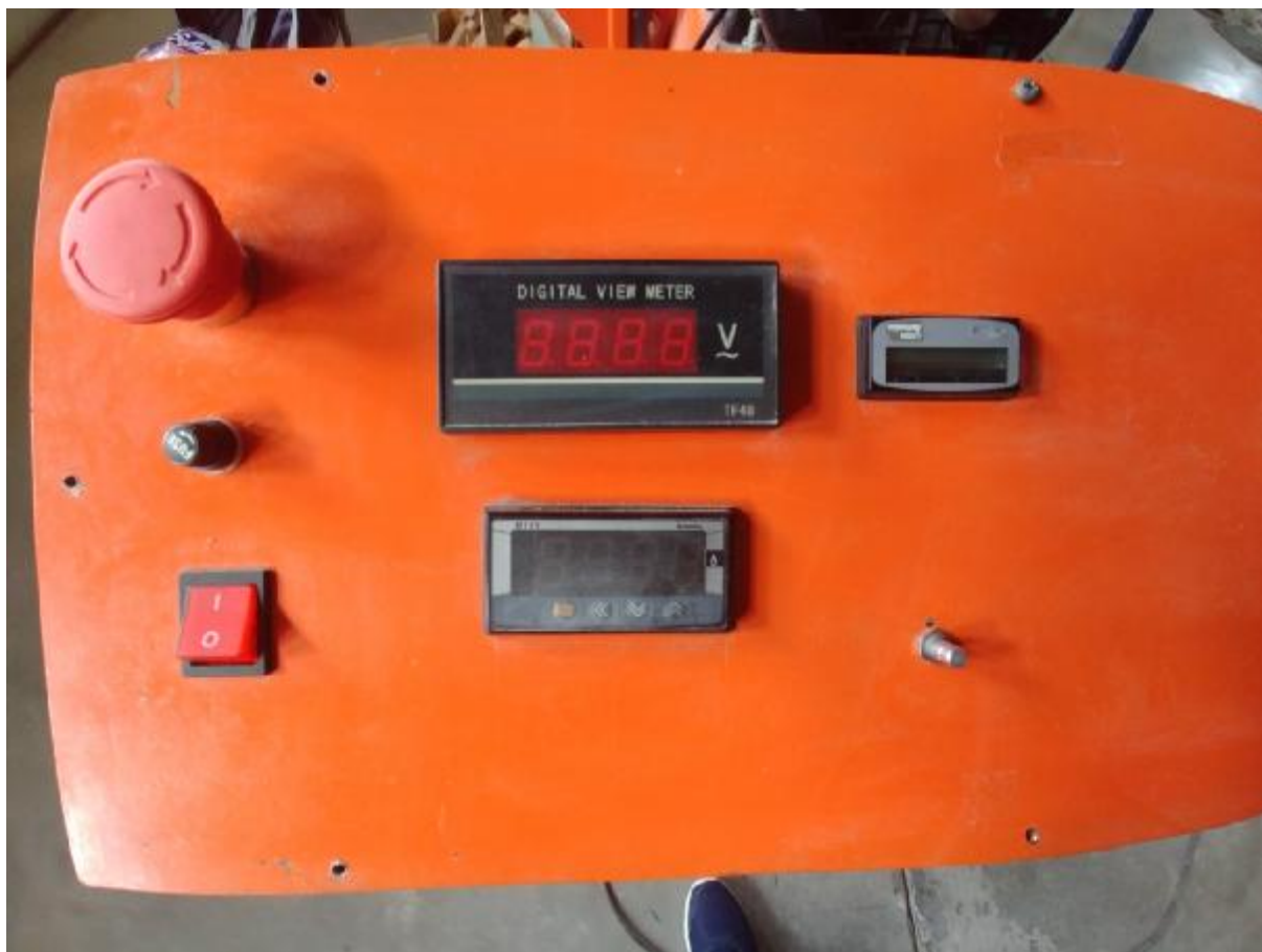
Εικόνα 22: Υλοποίηση πίνακα ελέγχου.
