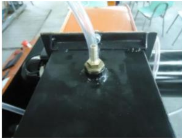
Εικόνα 16: Σωλήνας για την μέτρηση του μανομετρικού για τον αγωγό κατάθλιψης [9].
