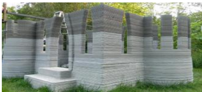
Εικόνα 2-3: Κάστρο κατασκευασμένο μέσω 3D εκτύπωσης
