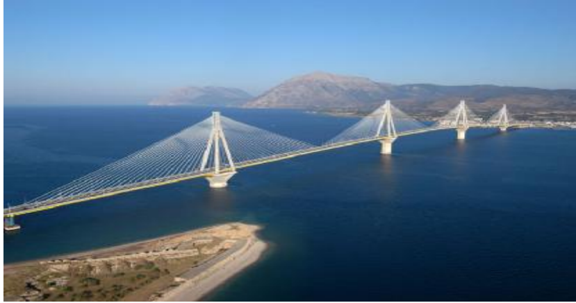
Εικόνα 3 Γέφυρα Ρίου Αντιρρίου
