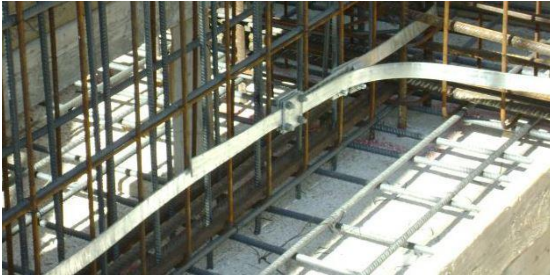
Εικόνα 24: Ισοδυναμικό πλέγμα
