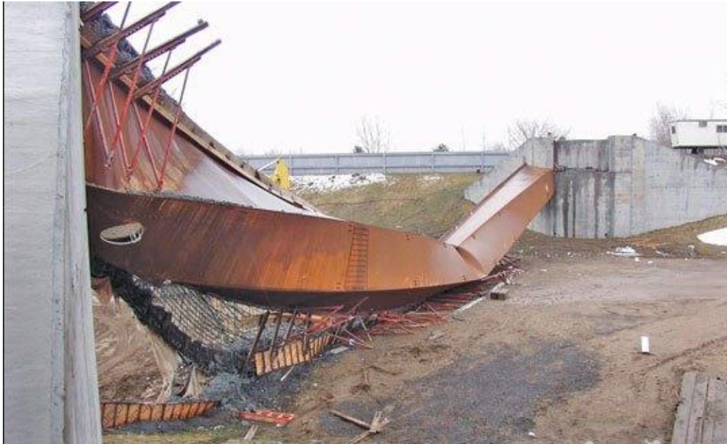
Εικόνα 6: Πλευρικός στρεπτικός λυγισμός Βιβλιογραφία(6)
