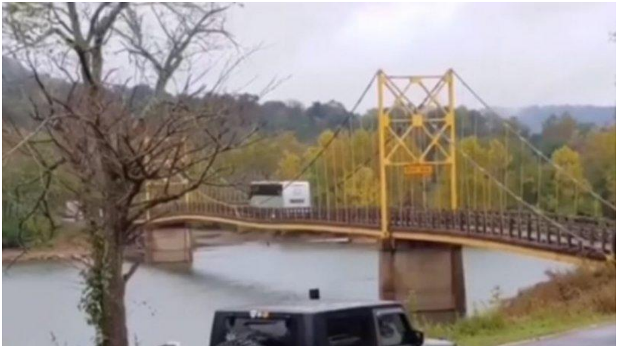
Εικόνα 8: Τοπικός λυγισμός Βιβλιογραφία(6)
