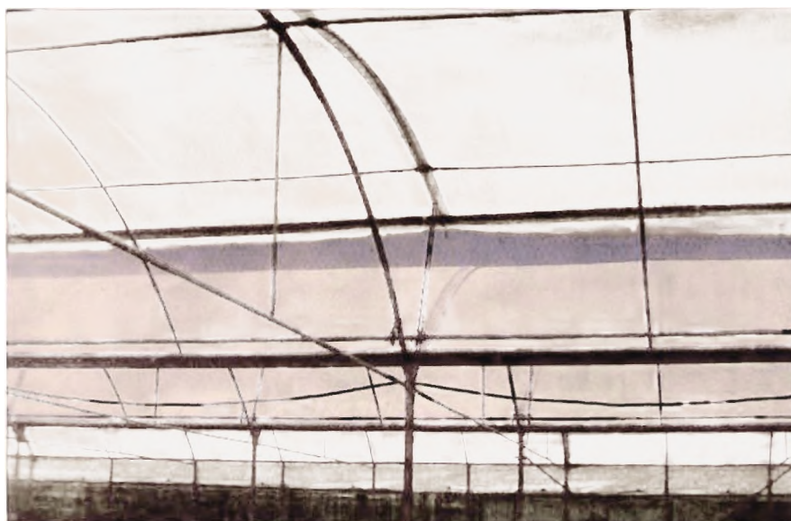
Εικ.2: Η κατασκευή θα πρέπει να εξασφαλίζει τον αναγκαίο εξαερισμό αλλά και την βελτίωση της υγρασίας ανάλογα με την εποχή
