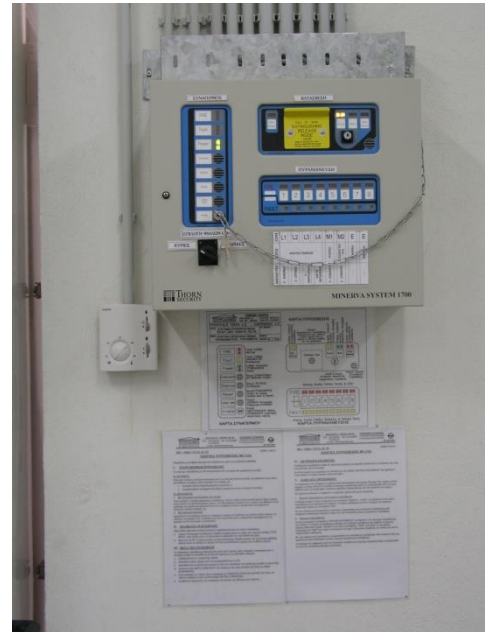
Εικόνα 19: Πίνακας Πυρανίχνευσης-Πυρόσβεσης
