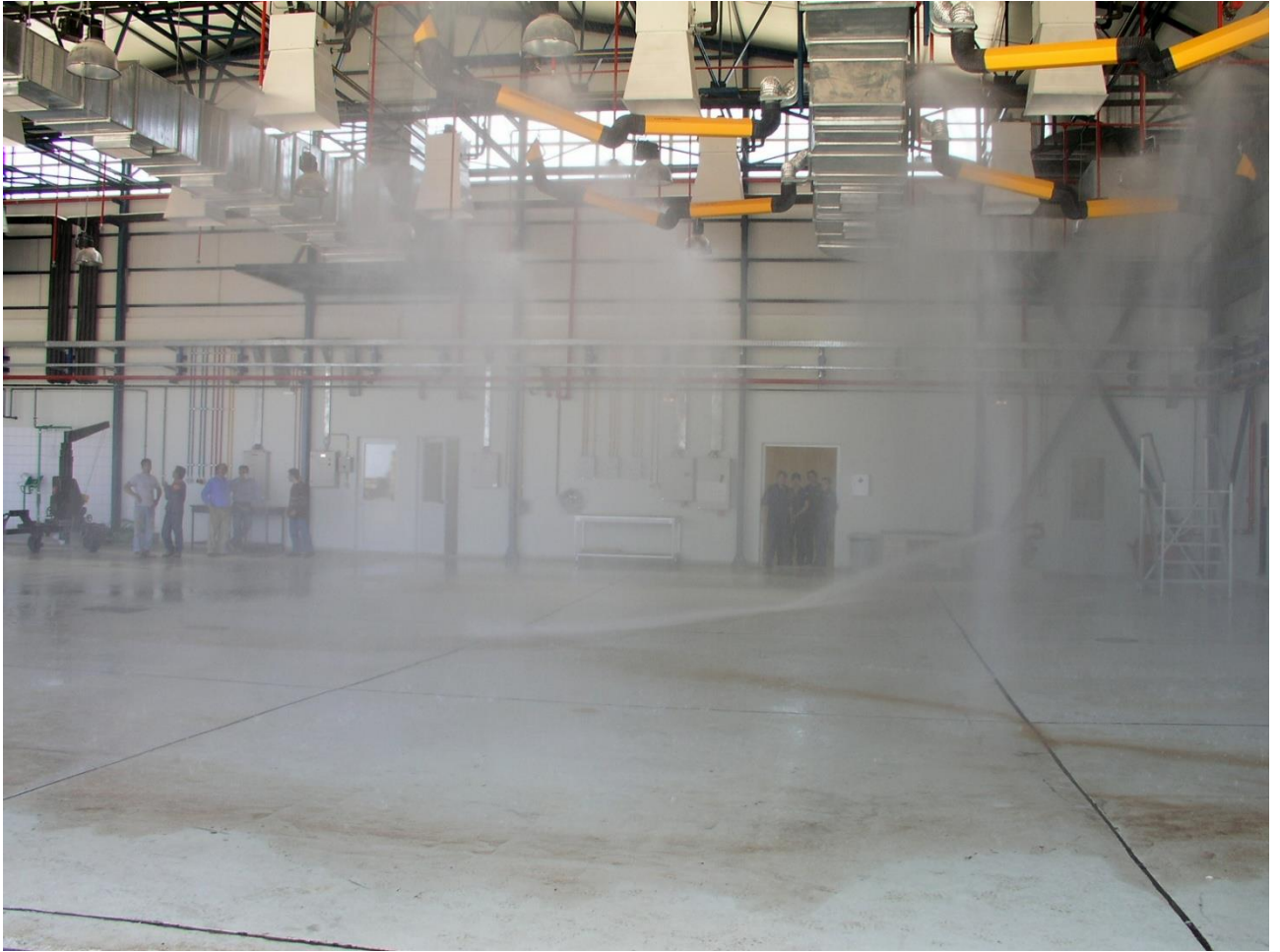
Εικόνα 16: Δοκιμή λειτουργίας συστήματος καταιονισμού αφρού νερού σε υπόστεγο συντήρησης αεροσκαφών.
