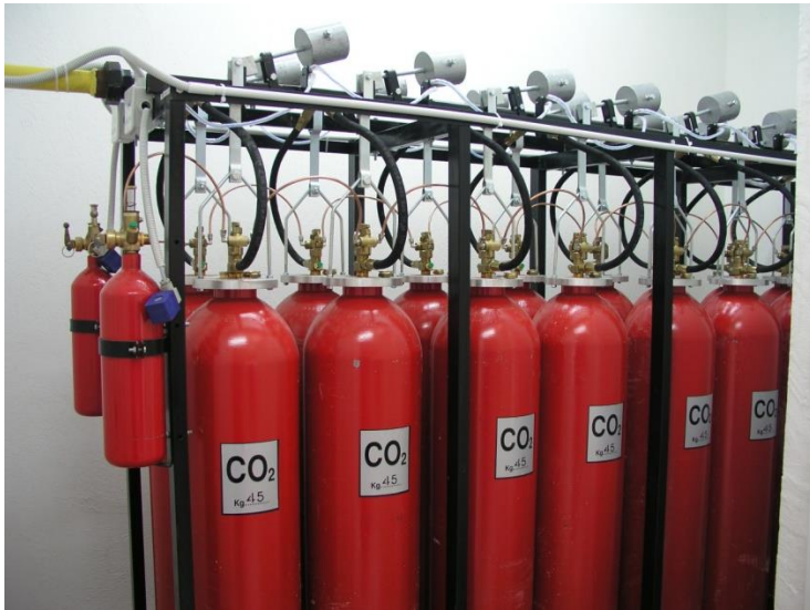
Εικόνα 18: Συστοιχία φιαλών CO 2 κύριων-εφεδρικών με τους πιλότους ενεργοποίησης
