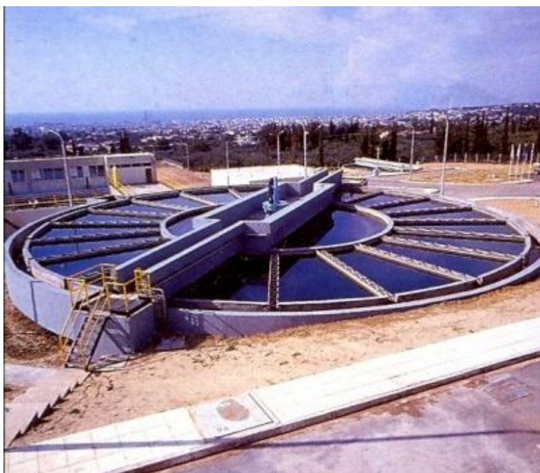
Εικόνα 14: Μονάδα κροκίδωσης – καθίζησης Ριγανόκαμπου [14]
