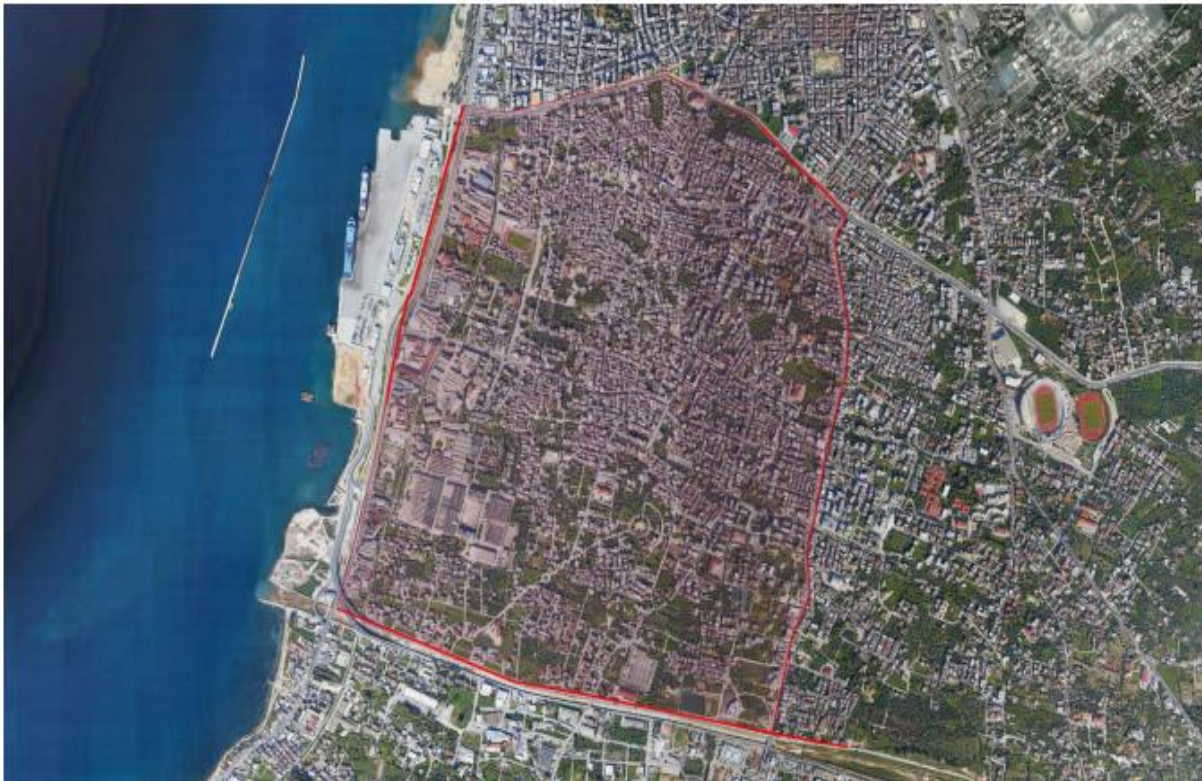
Εικόνα 5: Περιοχή αντικατάσταση αγωγών ύδρευσης [17]
