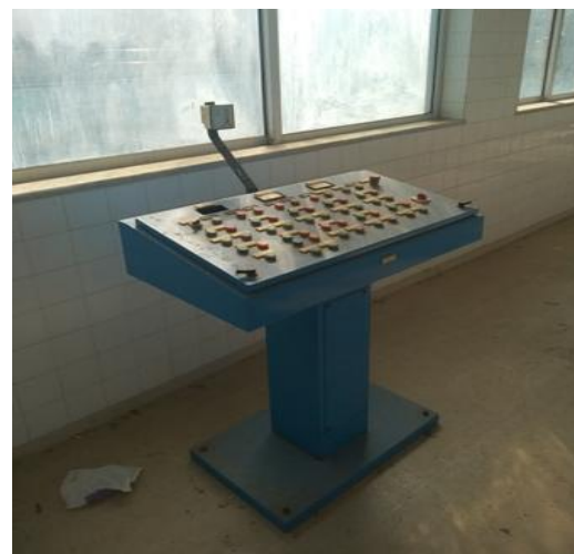
Εικόνα 19: Ανθρώπινος έλεγχος πλύσης Ριγανόκαμπου [14].
