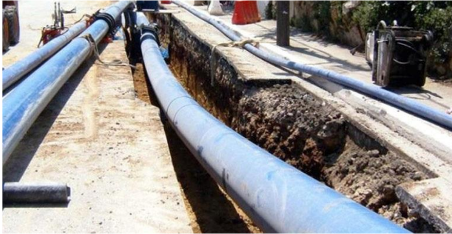
Εικόνα 6: Αντικατάσταση παλαιών αγωγών ύδρευσης [17]
