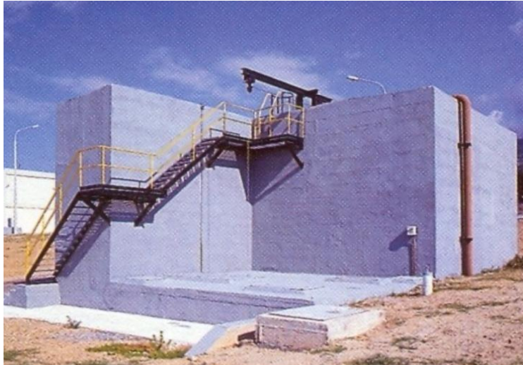
Εικόνα 11: Μονάδα Πιεζόθραυσης Ριγανόκαμου [14].
