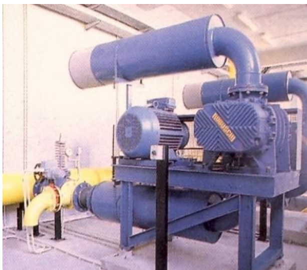
Εικόνα 17: Αεροσυμπιεστής αέρα πλύσης Ριγανόκαμπου [14].
