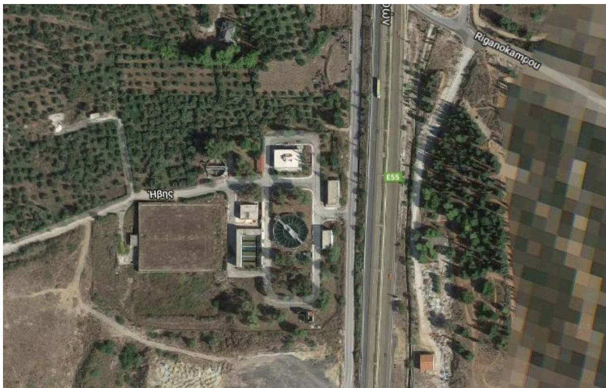
Εικόνα 10: Εγκαταστάσεις επεξεργασίας νερού Ριγανόκαμπου (Google Maps).
