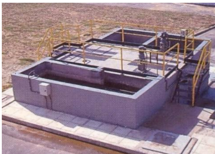
Εικόνα 13: Μονάδα Ταχείας Ανάμιξης Ριγανόκαμπου [14].
