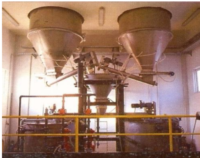
Εικόνα 12: Παραγωγή Διαλύματος Θεικού Αργιλίου Ριγανόκαμπου [14].
