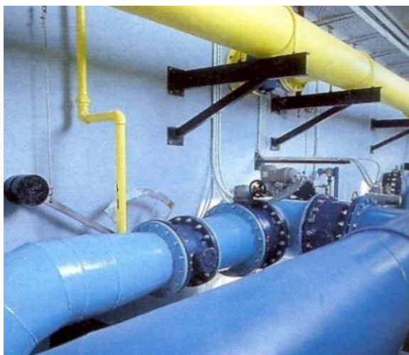
Εικόνα 18: Δικλίδες διαχείρισης πλύσης Ριγανόκαμπου [14].
