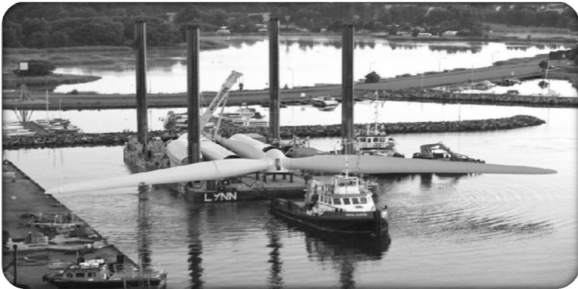
Εικόνα 2.22: Μεταφορά προσυναρμολογημένου στροφέα (70 μέτρα διάμετρος) για τοποθέτηση στο αιολικό πάρκο Yttre Stengrund.
