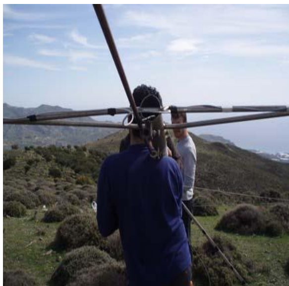
Εικόνα 1.7: Εγκατάσταση Ανεμολογικού Ιστού.
