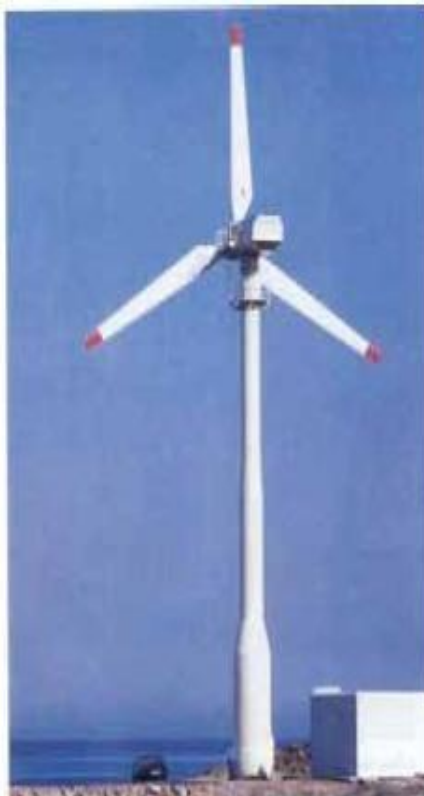
Εικόνα 2.9: Ανεμογεννήτριες με Χαλύβδινους και Δικτυωτούς πύργους αντίστοιχα.
