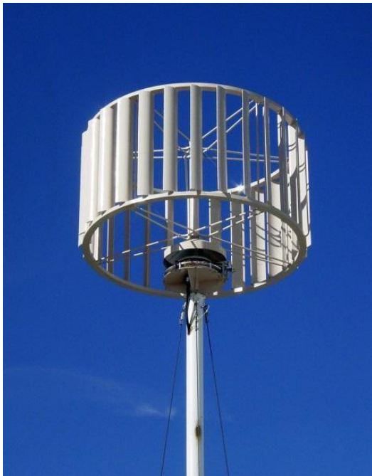
Εικόνα 2.3: Ανεμογεννήτριες Κατακόρυφου Άξονα τύπου Darrieus.
