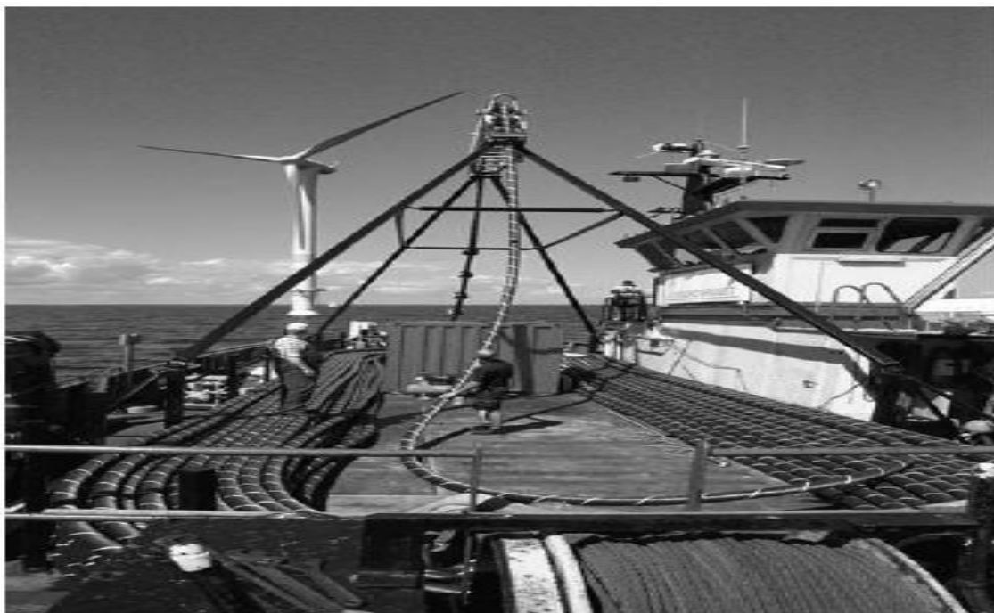
Εικόνα 4.5: Τοποθέτηση καλωδίων με ειδικό εξοπλισμό.
