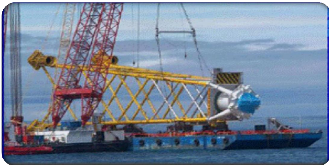
Εικόνα 2.20: Θεμελίωση με Μεταλλικό Τετράποδο.
