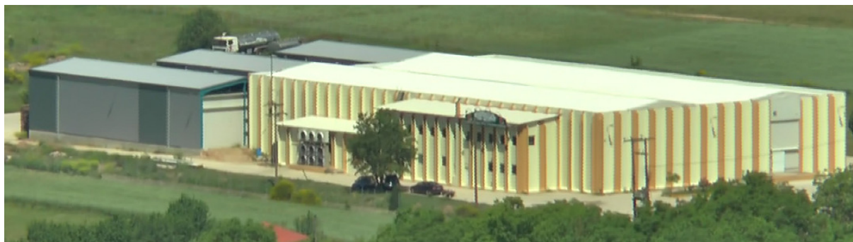
Εικόνα 4.7: Μονάδα Ωρίμανσης - Ψύξης.
