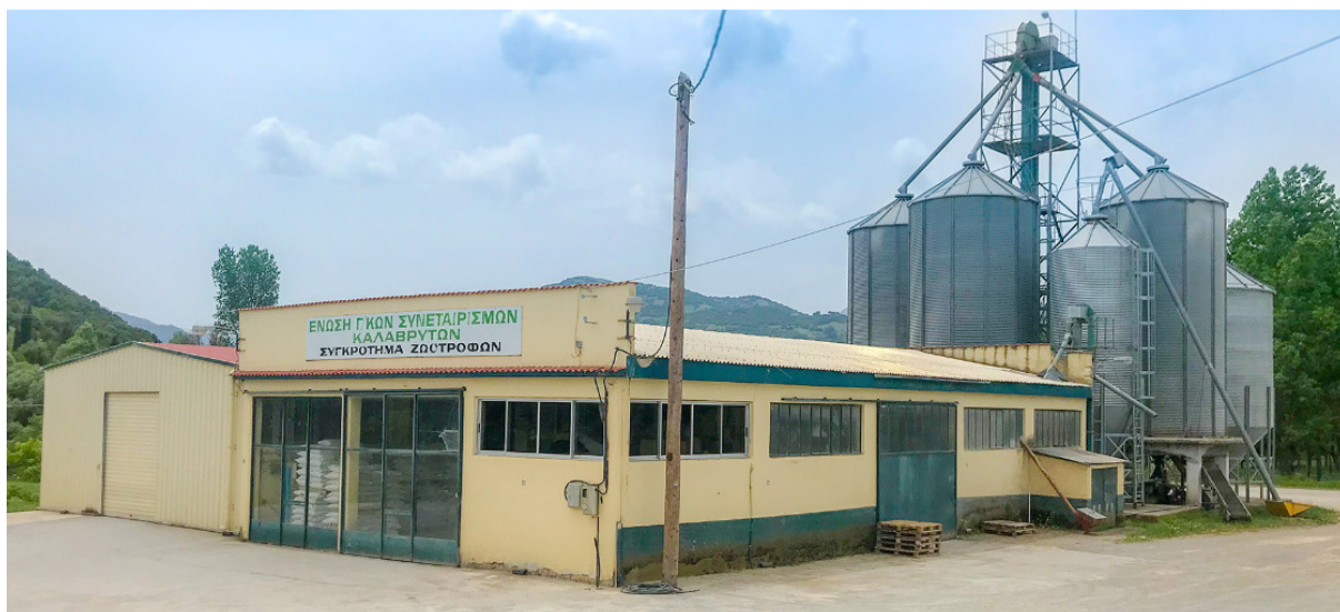
Εικόνα 4.8: Συγκρότημα Αποθήκευσης & Παραγωγής Μιγμάτων Ζωοτροφών.
