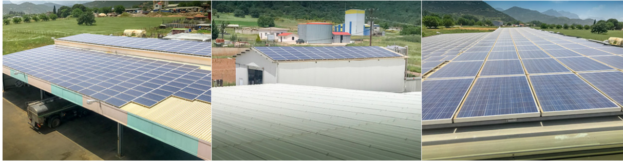
Εικόνα 4.10: Φωτοβολταϊκά στις ταράτσες των εγκαταστάσεων του Συνεταιρισμού Καλαβρύτων.
