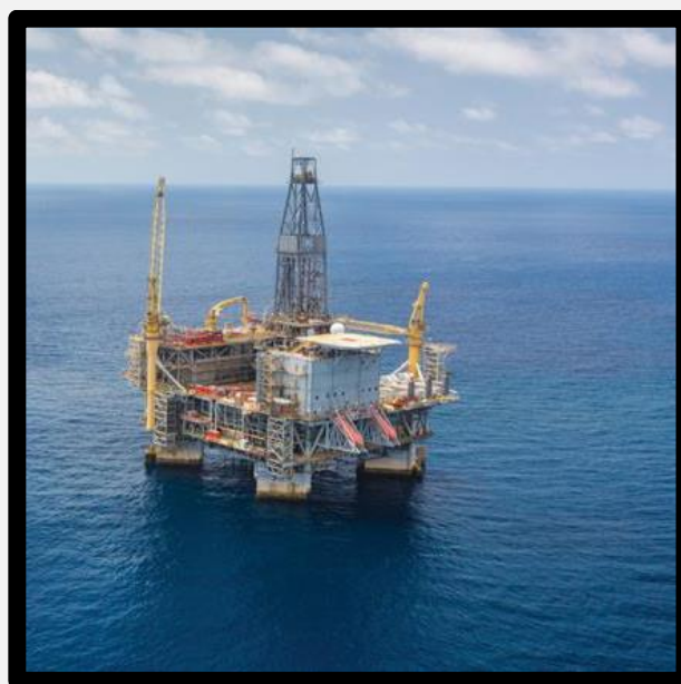
Εικόνα 2.3.2 : Υπεράκτια Κατασκευή Αλουμινίου
