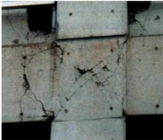
Σχ. 4.5 Διαμητική αστοχία εξωτερικών κόμβων: (α) Σεισμός Hyogo-ken Nanbu, Ιαπωνία, 1995 και (β) Σεισμός Καλαμάτας, 1986 ( fib 2003).
