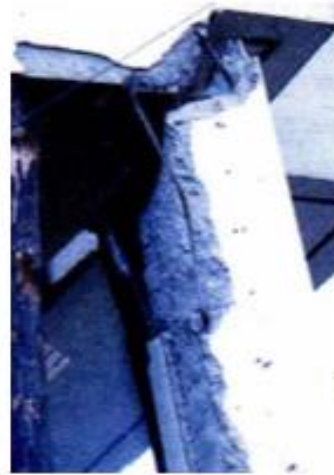
Σχ. 4.5 Διαμητική αστοχία εξωτερικών κόμβων: (α) Σεισμός Hyogo-ken Nanbu, Ιαπωνία, 1995 και (β) Σεισμός Καλαμάτας, 1986 ( fib 2003).
