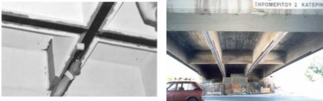
Σχ. 3.1 Παραδείγματα εφαρμογής ελασμάτων για την καμπτική ενίσχυση δοκών.
