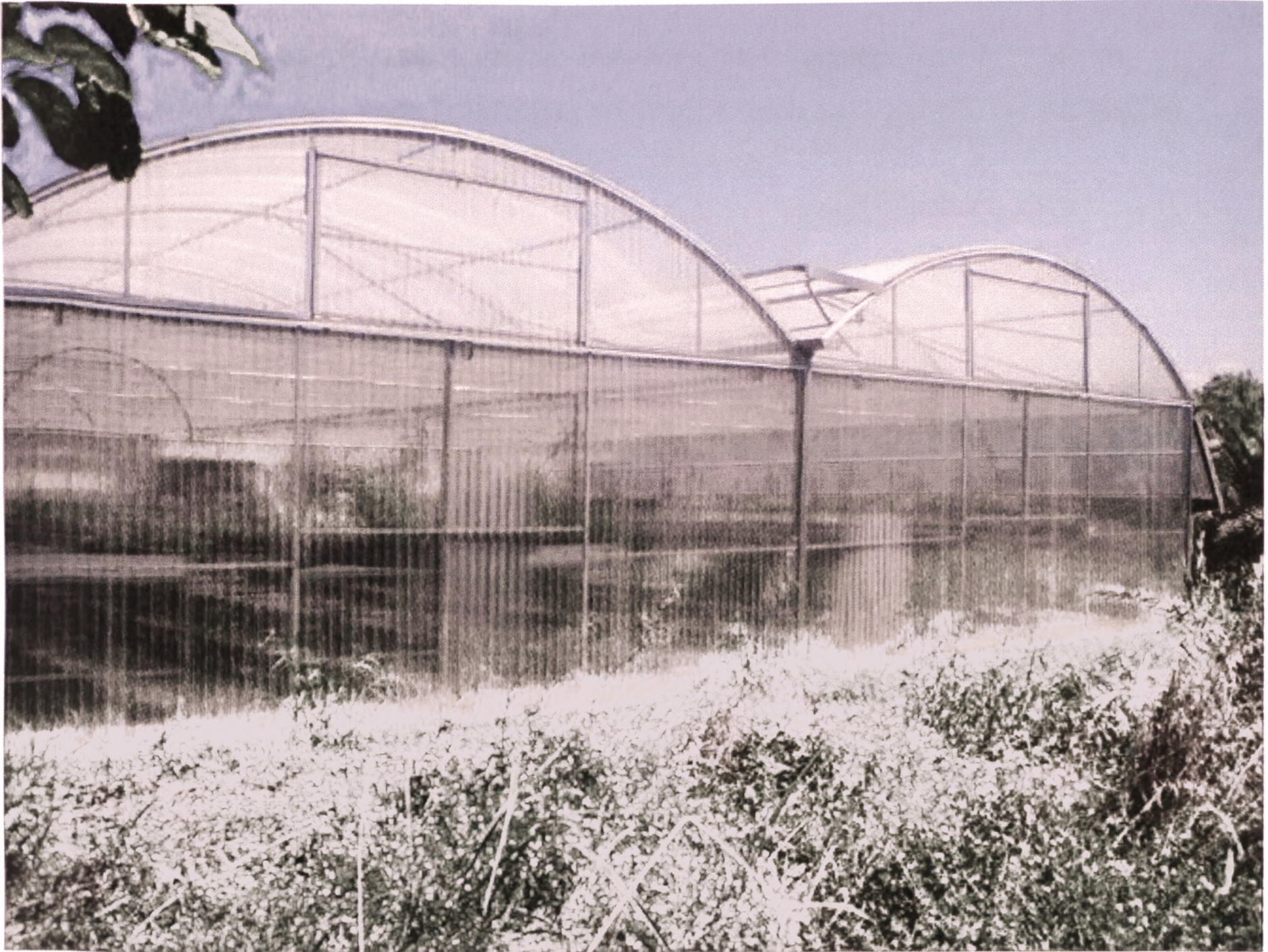
Εικόνα 19 : θερμοκήπιο τύπου multi-span
