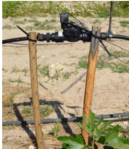
α) Τοποθέτηση αισθητήρα υγρασίας εδάφους. β) Τοποθέτηση ηλεκτροβαλβίδας.
