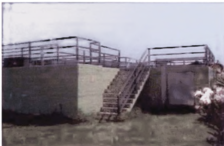
Εικ. 26 Εγκαταστάσεις βιολογικού καθαρισμού Ι. Π Μεσολογίου
