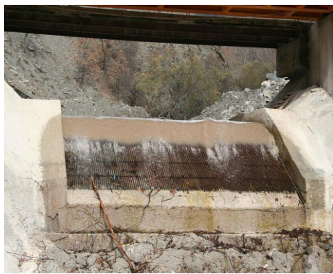
Εικόνα 3.4 Υδροληψία Εσχαρισμός
