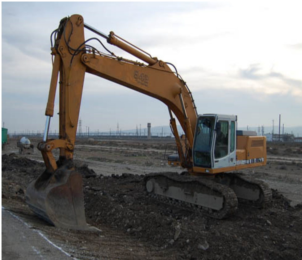
Εικόνα 8 : Εκσκαφή – διαμόρφωση εδάφους.
