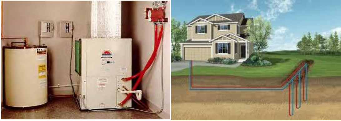
Εικόνα 1.10: Γεωθερμική αντλία θερμότητας εδάφους GHP (Βραχόπουλος, 2009)
