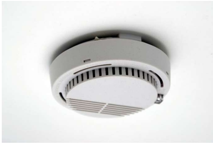
Σχήμα 3.9: Αισθητήρας ανίχνευσης καπνού τοποθετημένος σε οροφή
