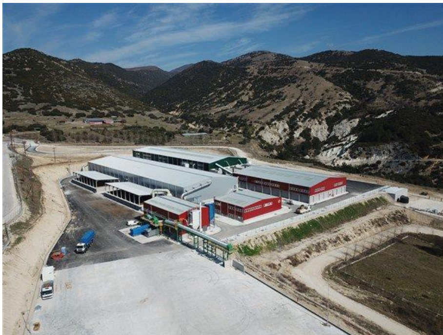
Εικόνα 1.1 Η μονάδα ολοκληρωμένης διαχείρισης απορριμμάτων του νομού Σερρών [8].
