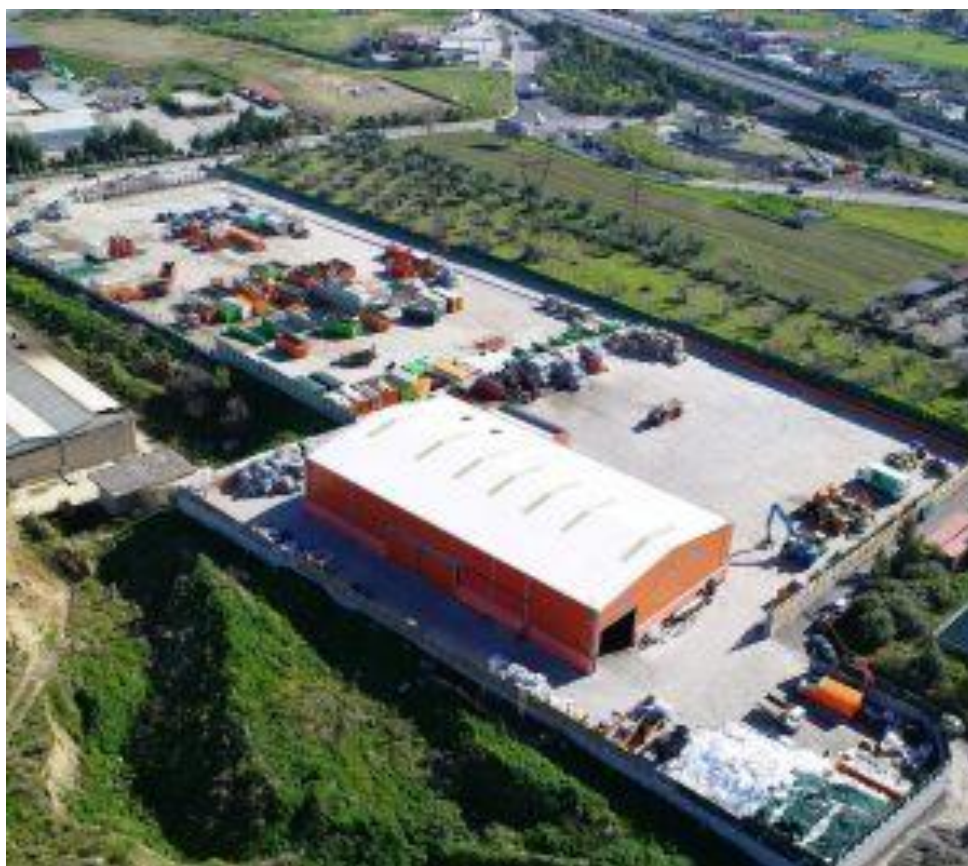
Εικόνα 5.1 Οι εγκαταστάσεις της μονάδας ανακύκλωσης μετάλλων της εταιρείας VA.STE.ECO EVOLUTION Ε.Π.Ε. στη Βοιωτία [14].
