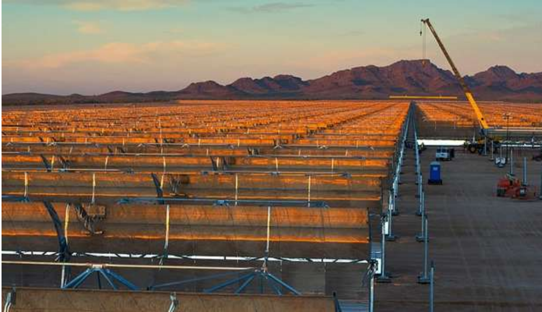
Εικόνα 2.2: Σύστημα παραβολικών κοίλων κατόπτρων στην Αριζόνα (πηγή: Abengoa Solar / Wikimedia Commons). 43
