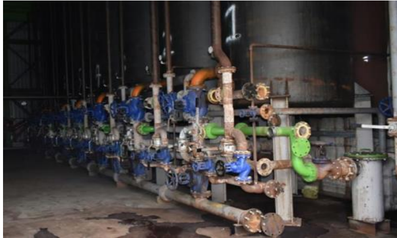
Εικόνα 5: Εκχυλιστήρες διατεταγμένοι σε σειρά [22]
