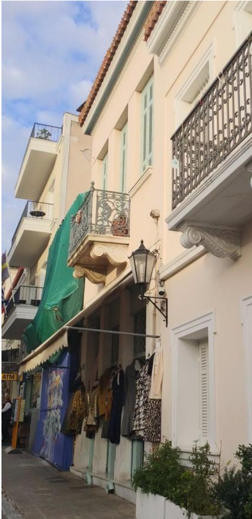
Εικόνα 73 Κτίριο επί της οδού Βύρωνος
