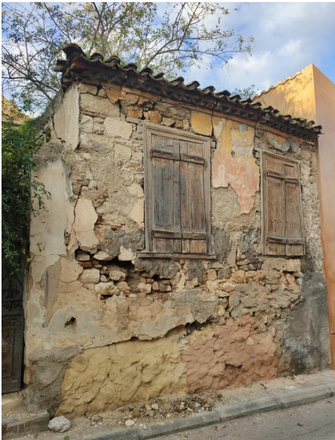
Εικόνα 25 Κτίριο επί της οδού Βάκχου
