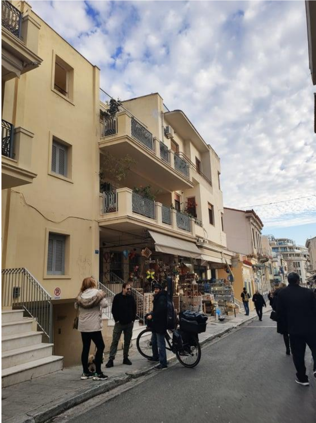
Εικόνα 61 Κτίριο επί της οδού Βύρωνος
