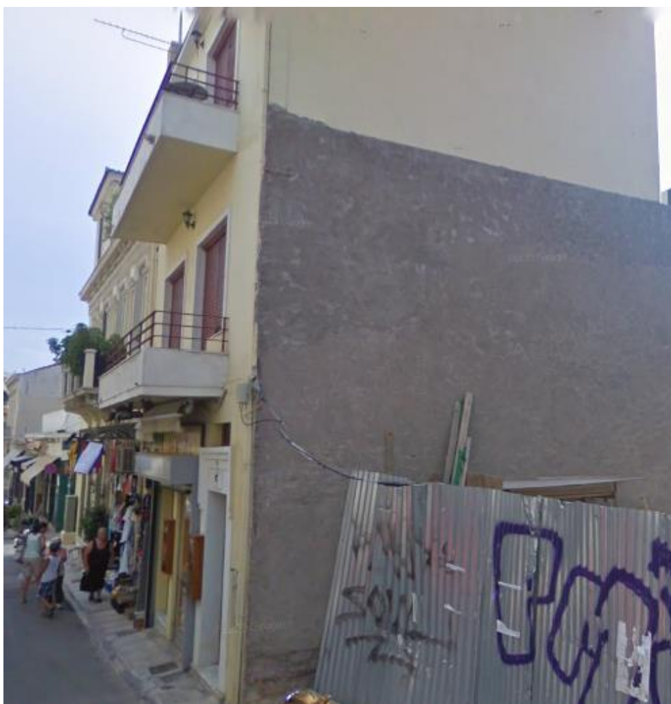
Εικόνα 50 Κτίριο επί της οδού Βύρωνος
