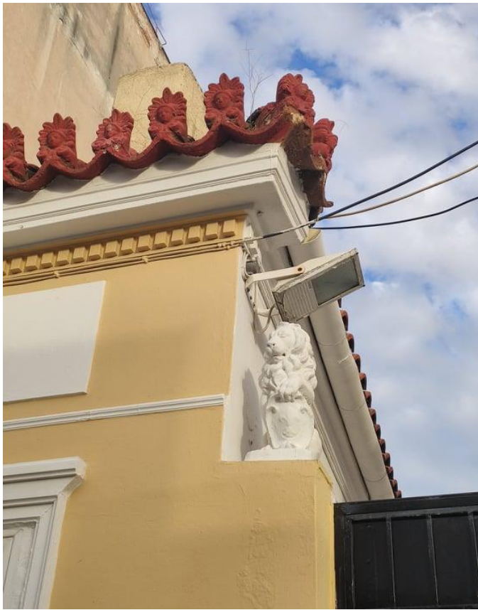
Εικόνα 64 Κτίριο επί της οδού Βύρωνος
