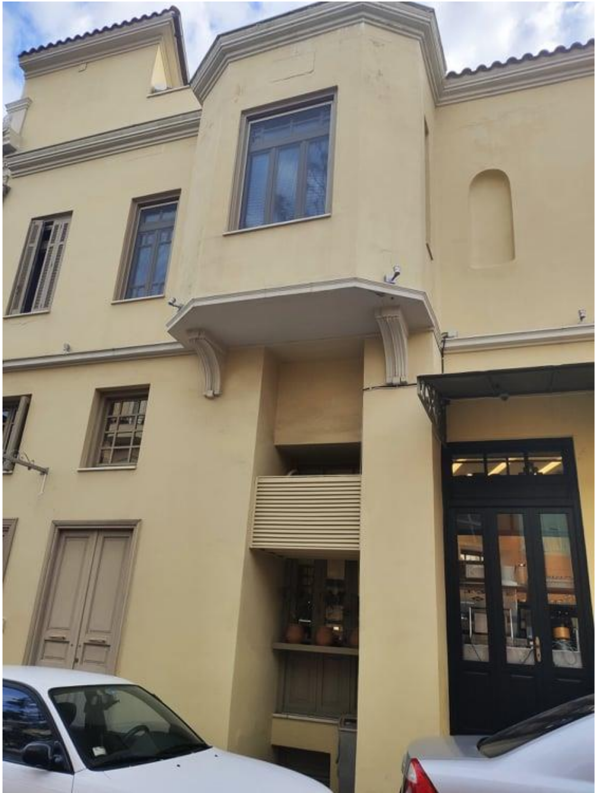
Εικόνα 57 Κτίριο επί της οδού Βύρωνος
