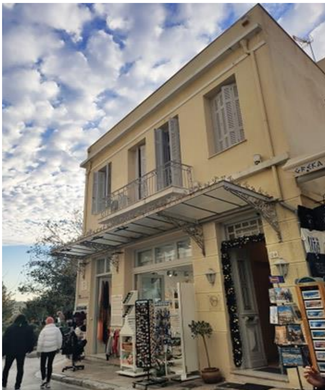
Εικόνα 37 Κτίριο στην συμβολή των οδών Διονυσίου Αεροπαγίτου και Βύρωνος
