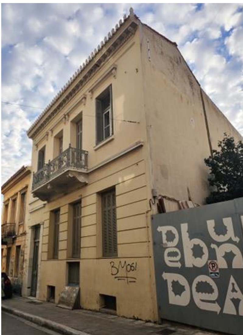
Εικόνα 44 Κτίριο επί της οδού Βύρωνος
