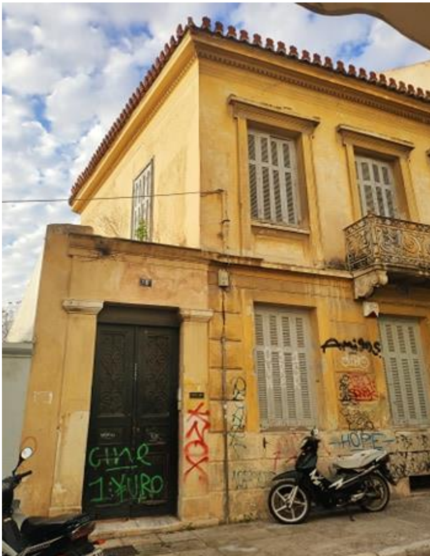
Εικόνα 42 Κτίριο επί της οδού Βύρωνος
