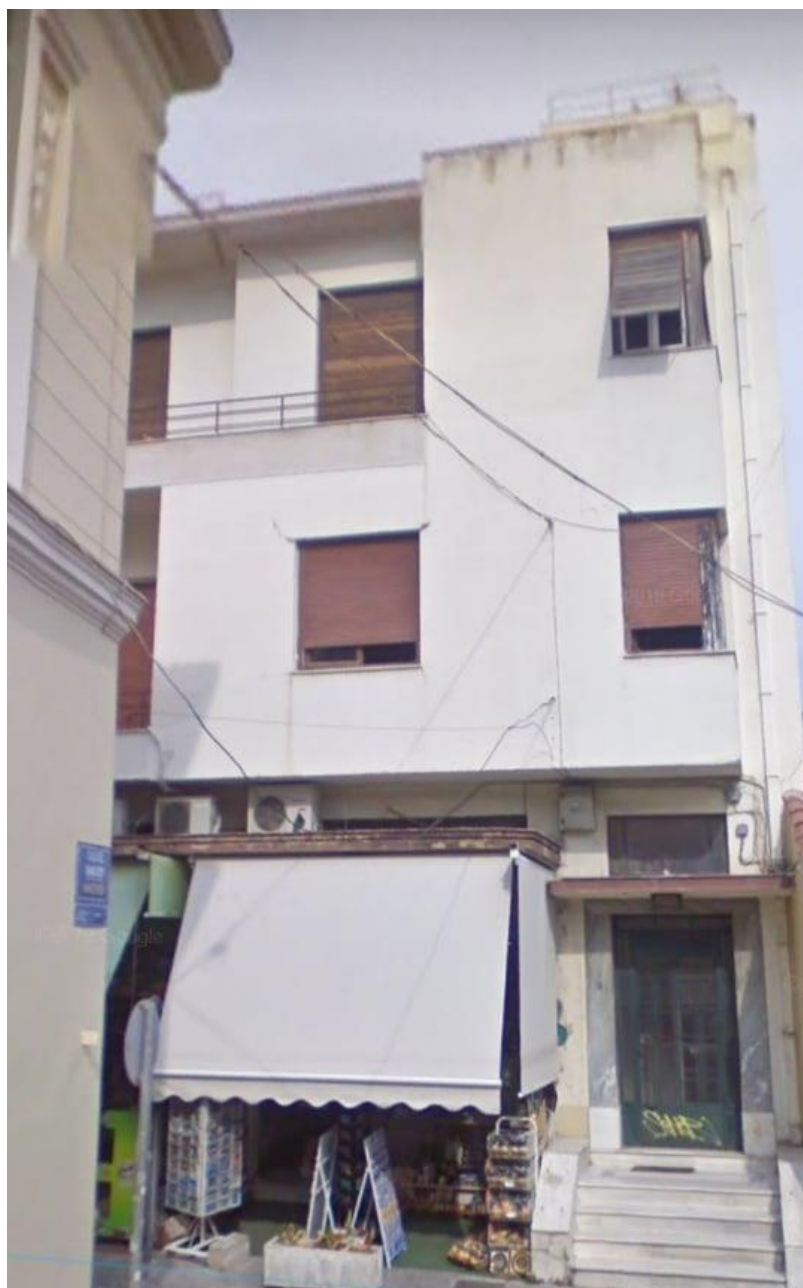
Εικόνα 62 Κτίριο επί της οδού Βύρωνος
