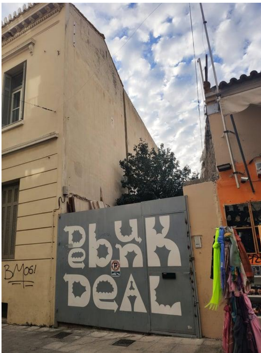
Εικόνα 45 Κτίριο επί της οδού Βύρωνος
