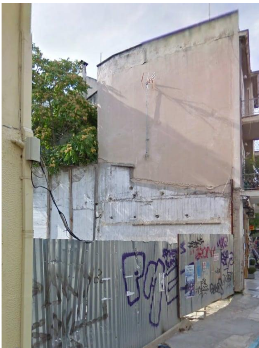
Εικόνα 51 Κτίριο επί της οδού Βύρωνος
