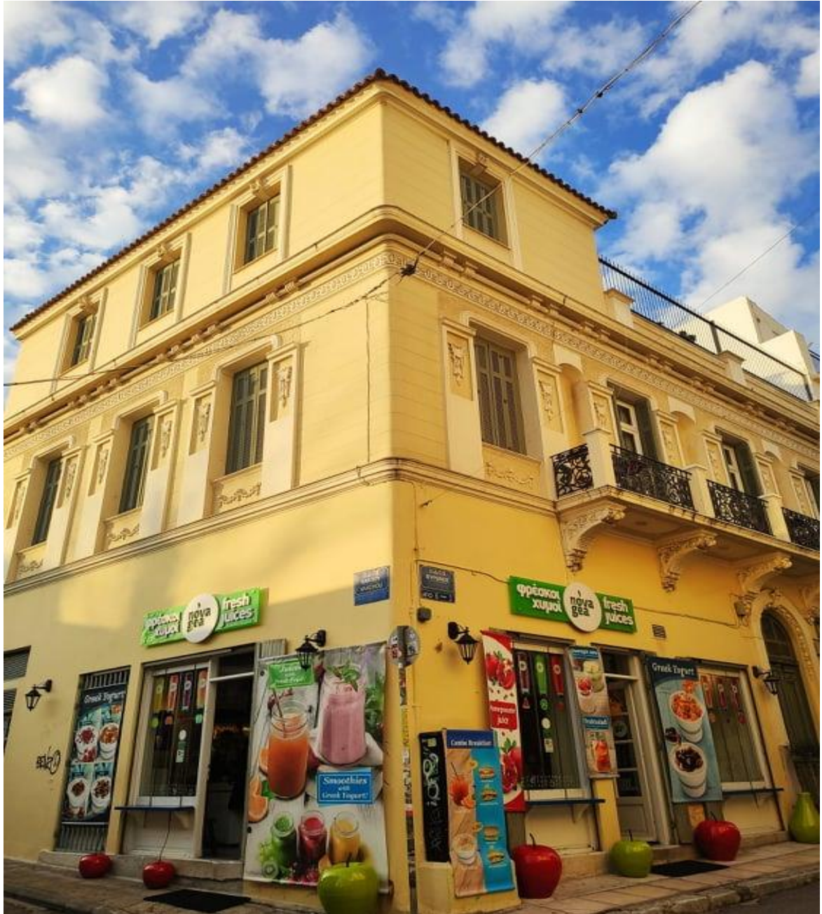
Εικόνα 36 Κτίριο στην συμβολή των οδών Βάκχου και Βύρωνος
