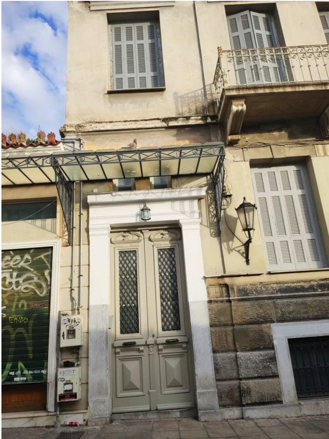
Εικόνα 66 Κτίριο επί της οδού Βύρωνος
