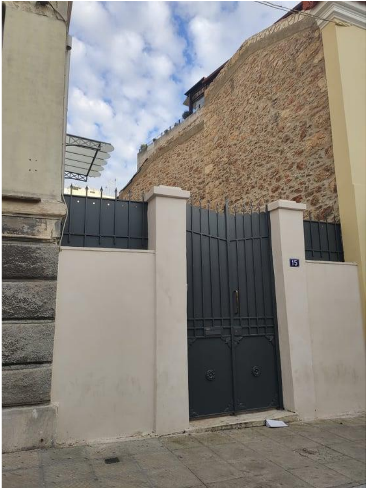
Εικόνα 69 Κτίριο επι της οδού Βύρωνος
