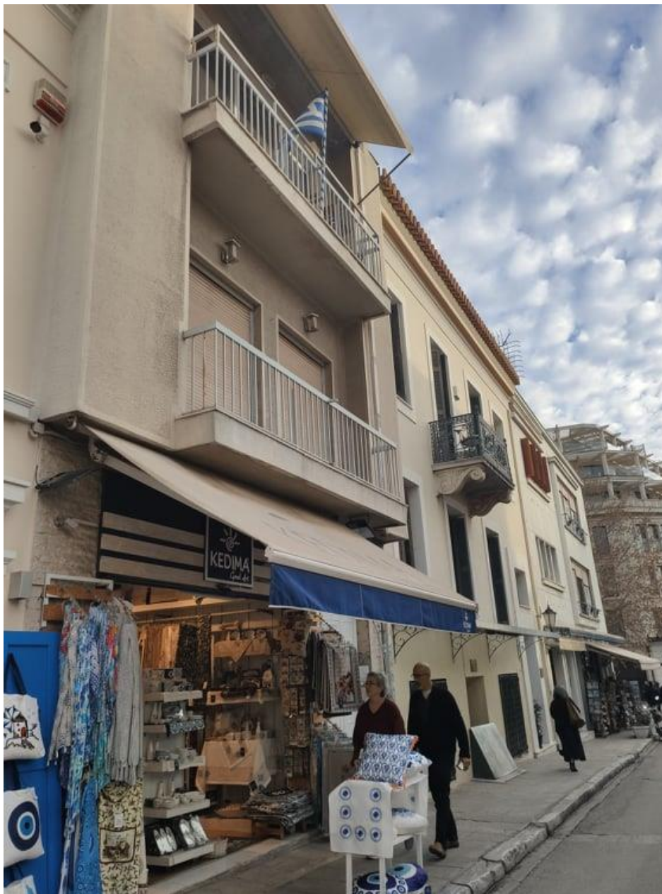
Εικόνα 75 Κτίριο επί της οδού Βύρωνος
