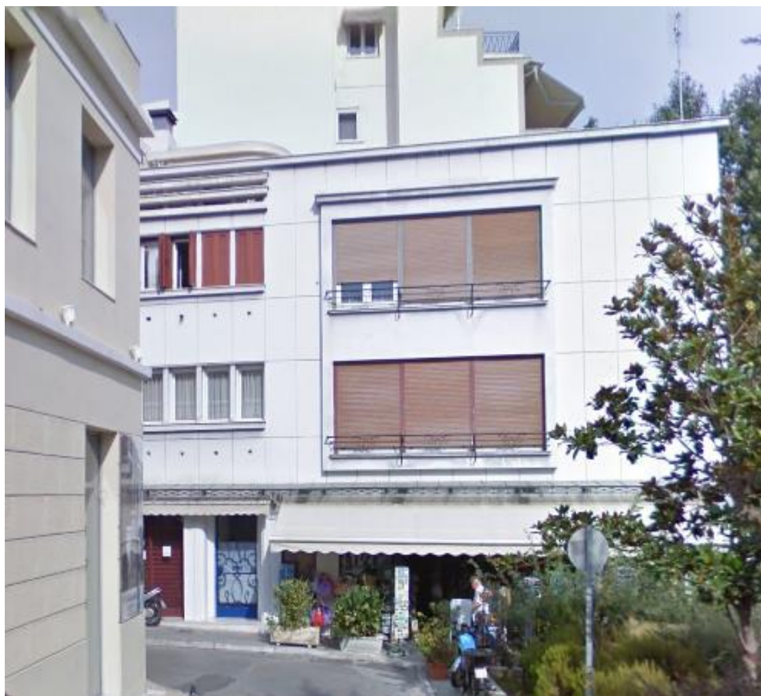
Εικόνα 76 Κτίριο στην συμβολή των οδών Βύρωνος και Διονυσίου Αεροπαγίτου
