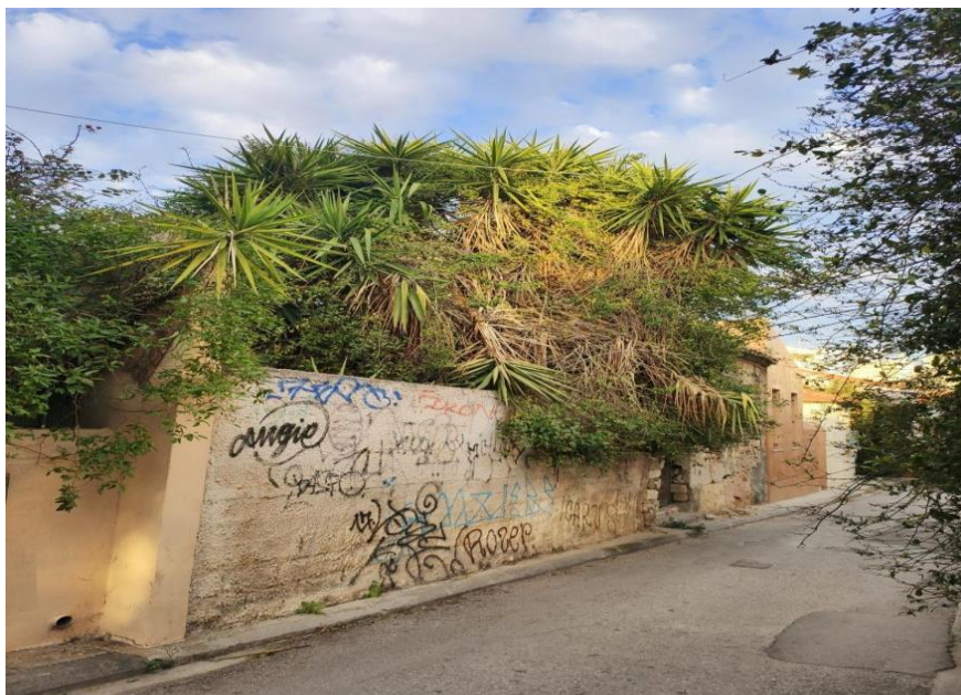
Εικόνα 27 Κτίριο επί της οδού Βάκχου
