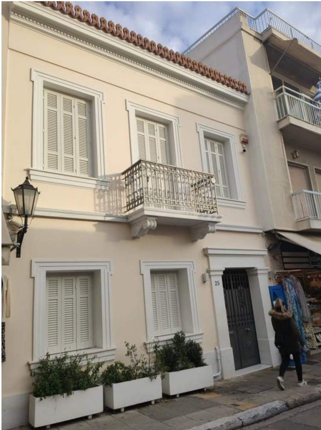
Εικόνα 74 Κτίριο επί της οδού Βύρωνος
