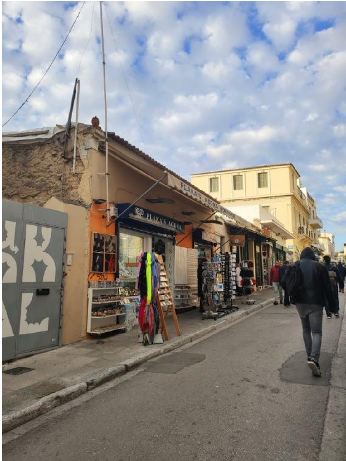
Εικόνα 46 Κτίριο επί της οδού Βύρωνος
