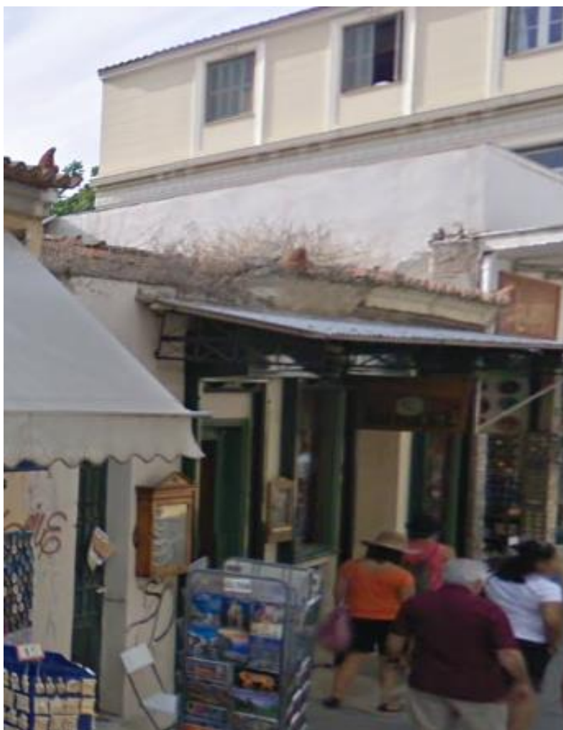
Εικόνα 47 Κτίριο επί της οδού Βύρωνος
