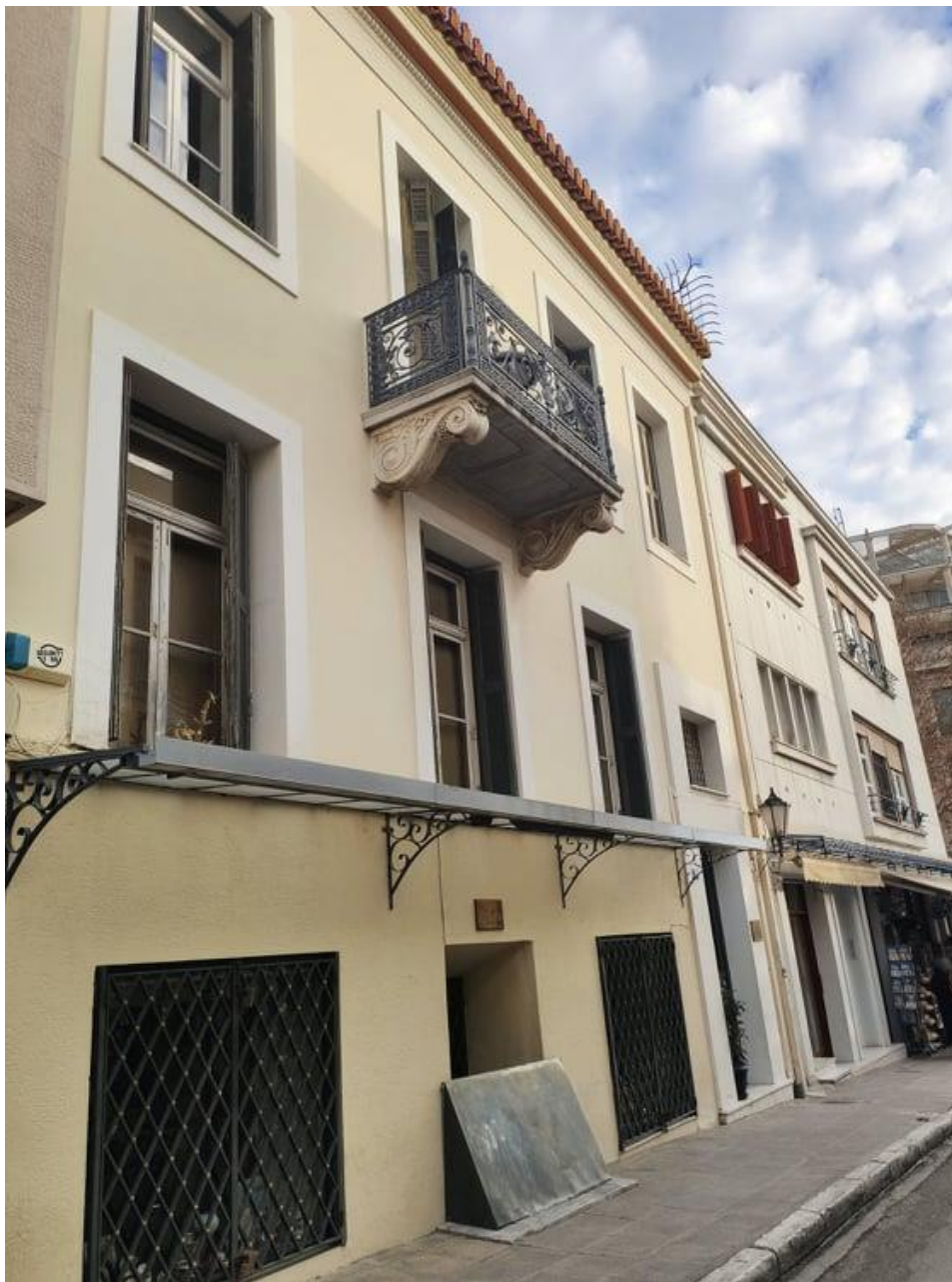
Εικόνα 75 Κτίριο επί της οδού Βύρωνος
