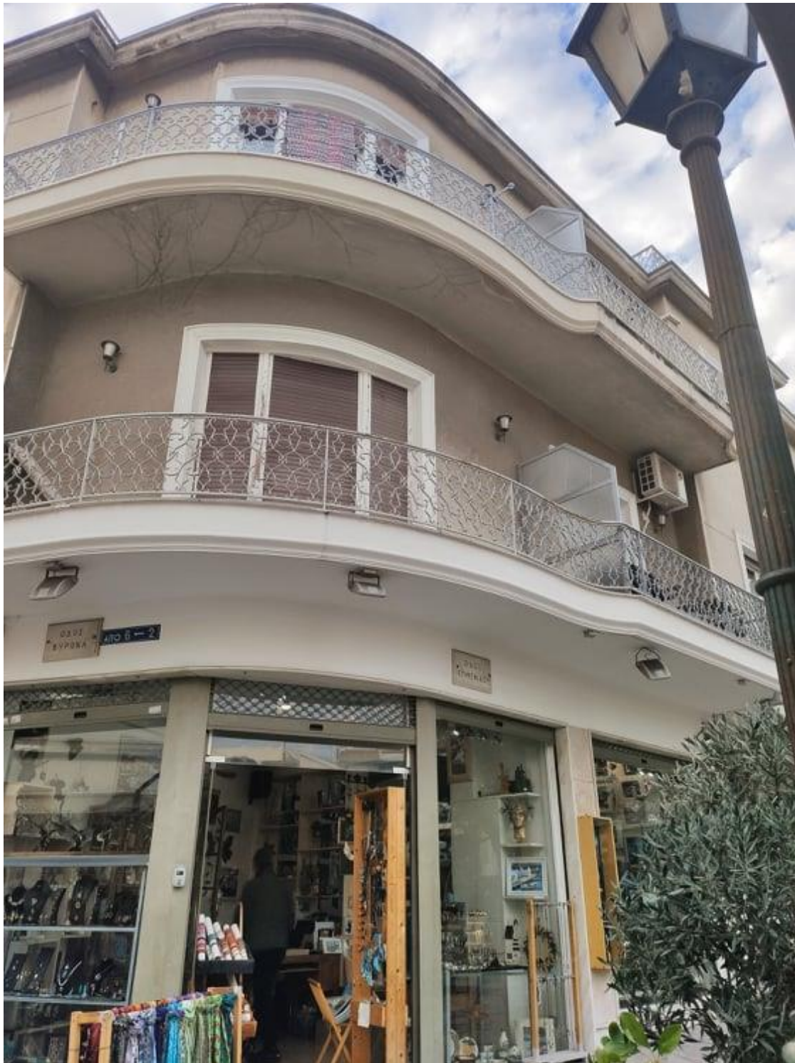
Εικόνα 54 Κτίριο επί της οδού Βύρωνος
