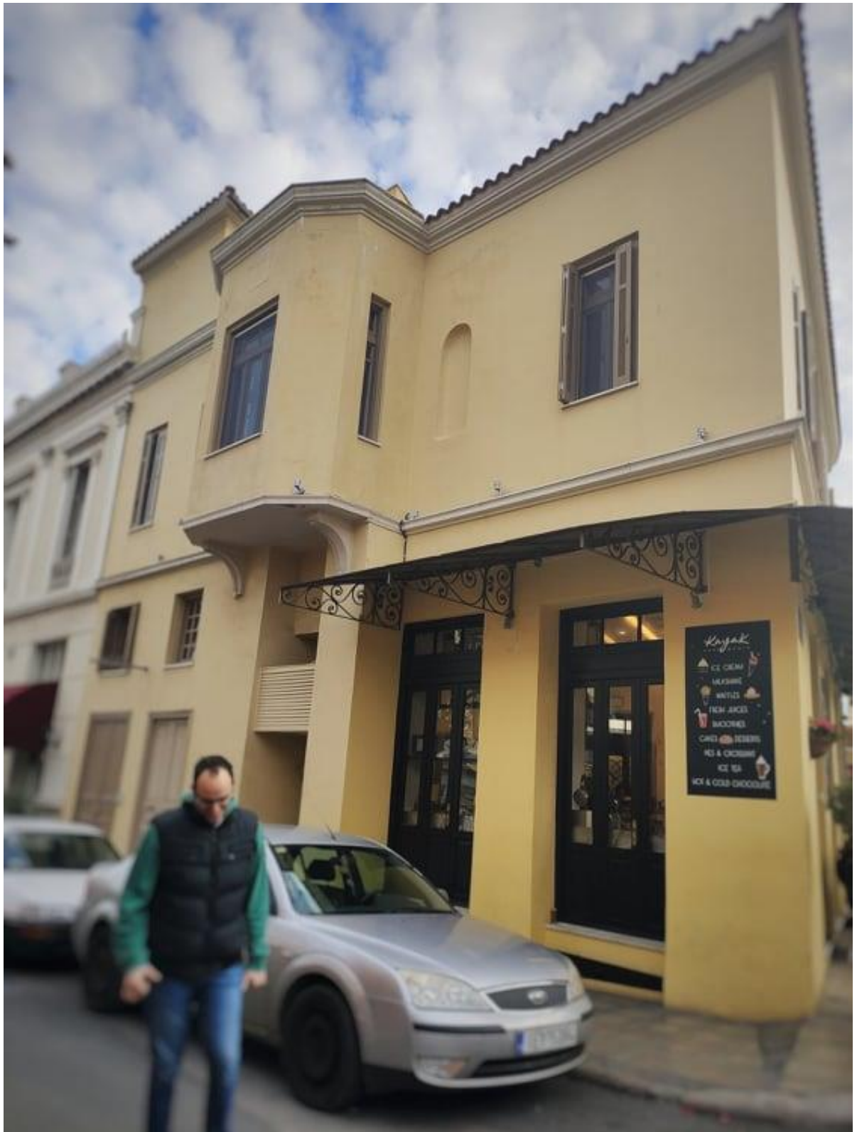
Εικόνα 56 Κτίριο επί της οδού Βύρωνος
