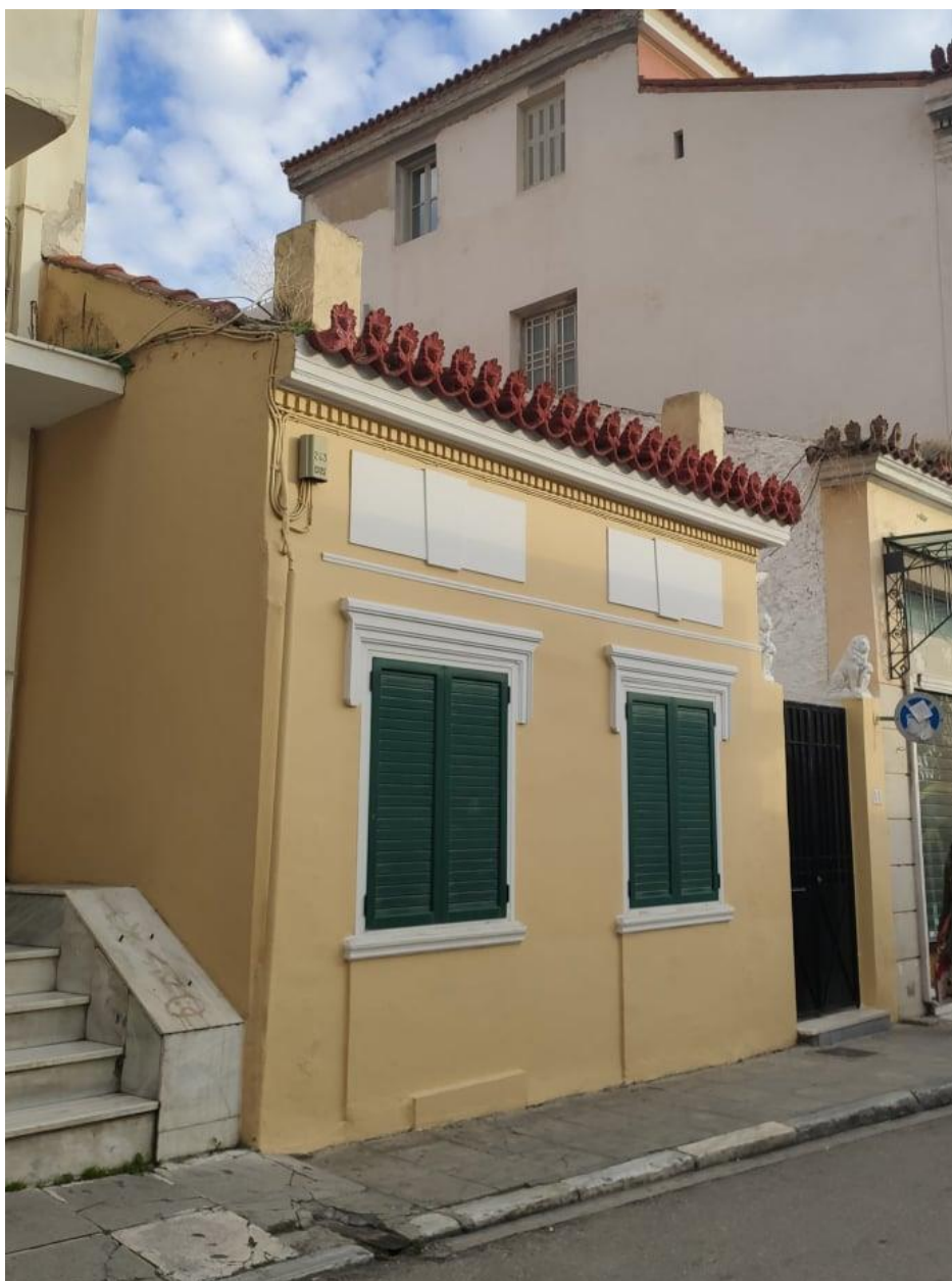
Εικόνα 63 Κτίριο επί της οδού Βύρωνος
