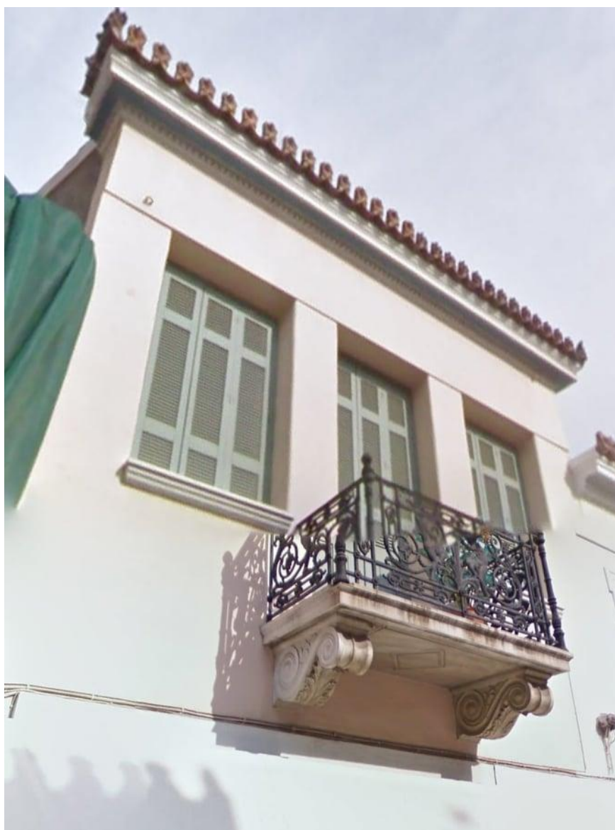
Εικόνα 72 Κτίριο επι της οδού Βύρωνος
