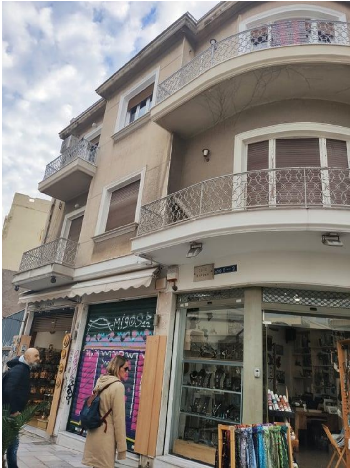
Εικόνα 53 Κτίριο επί της οδού Βύρωνος
