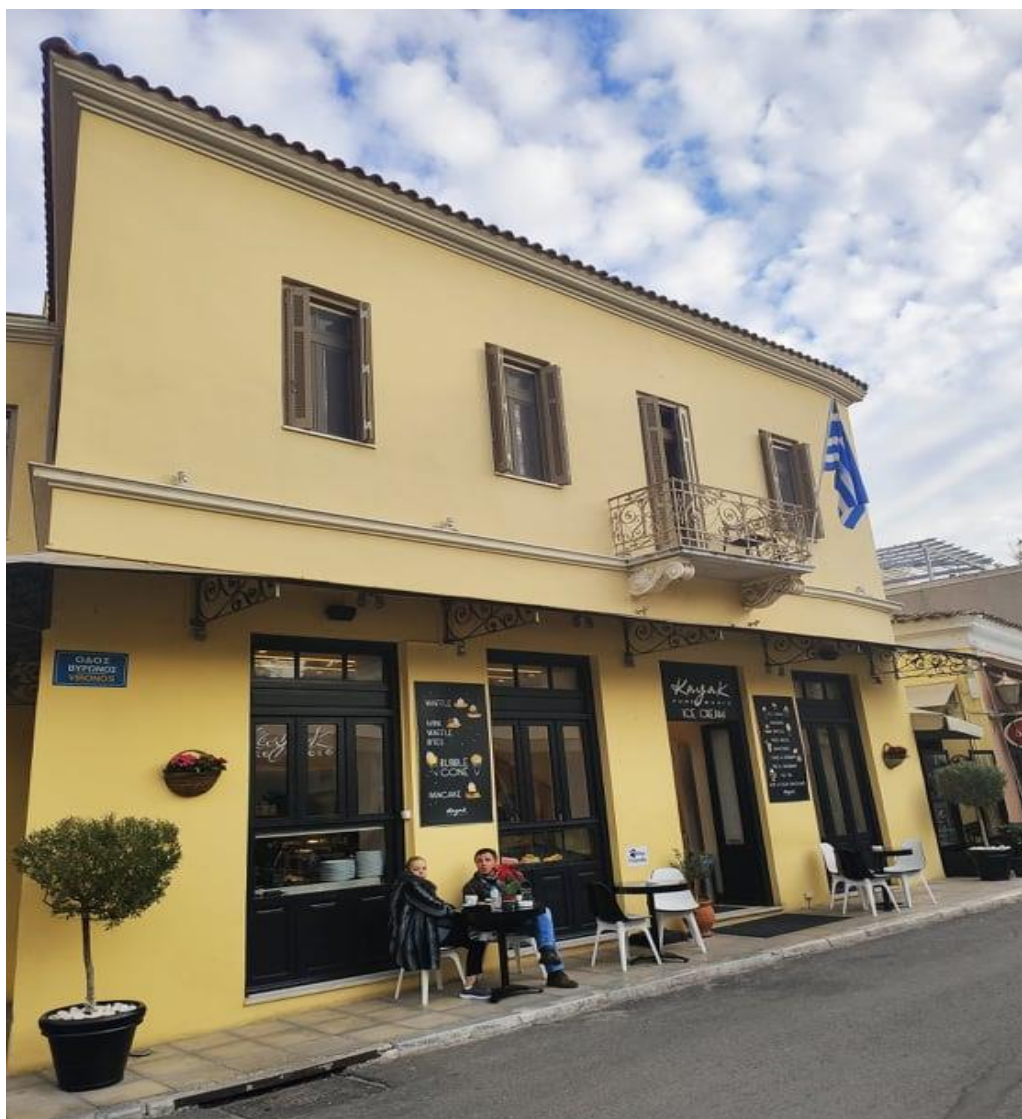
Εικόνα 55 Κτίριο επί της οδού Βύρωνος
