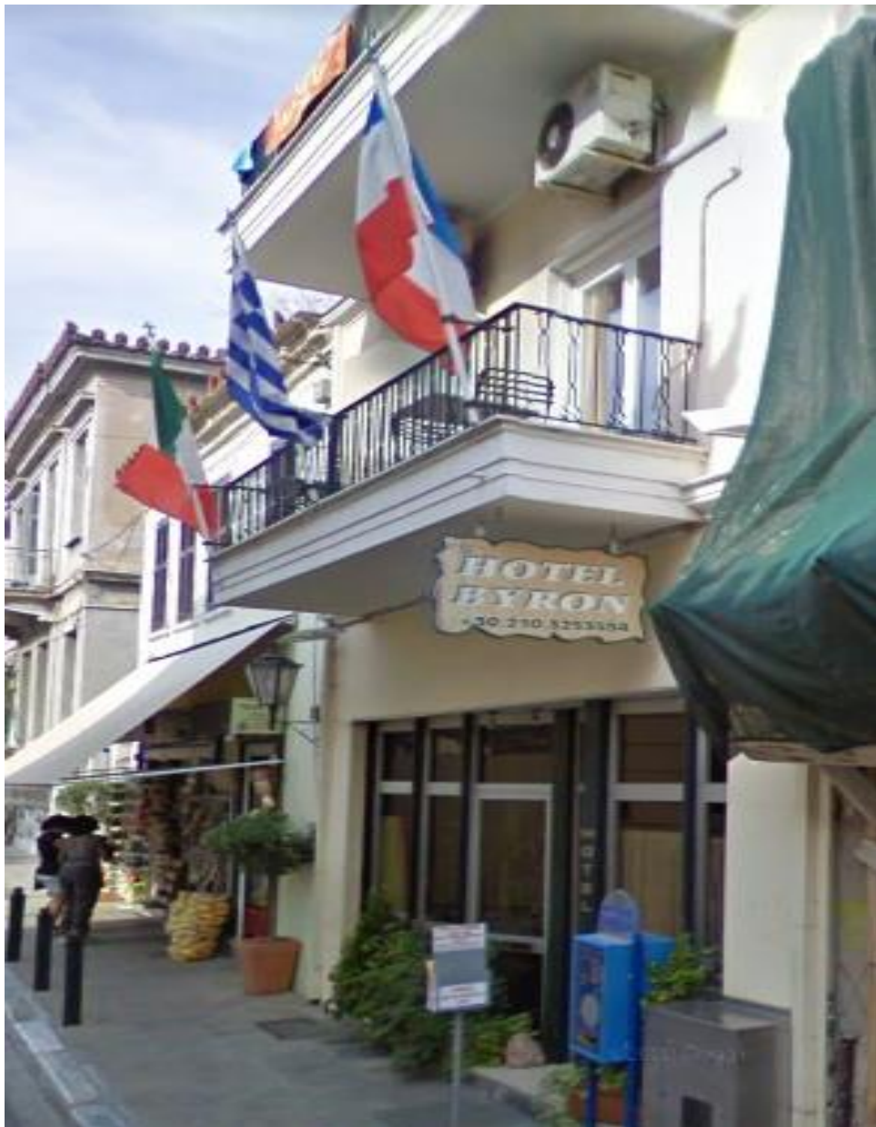
Εικόνα 70 Κτίριο επί της οδού Βύρωνος
