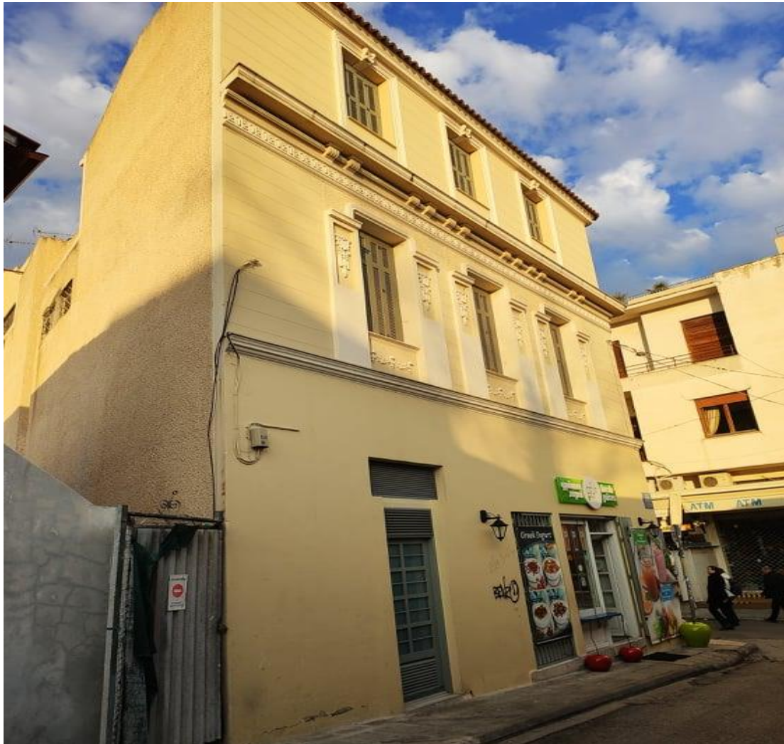
Εικόνα 35 Κτίριο στην συμβολή των οδών Βάκχου και Βύρωνος
