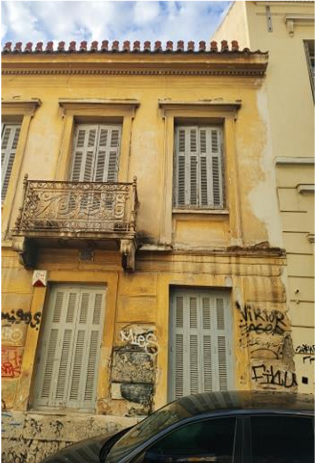
Εικόνα 43 Κτίριο επί της οδού Βύρωνος
