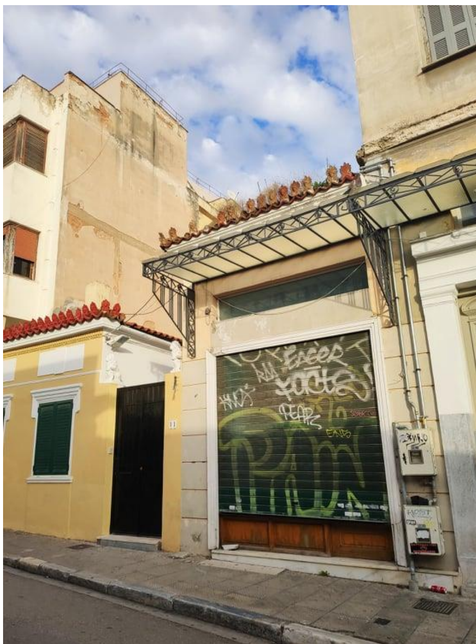
Εικόνα 65 Κτίριο επί της οδού Βύρωνος
