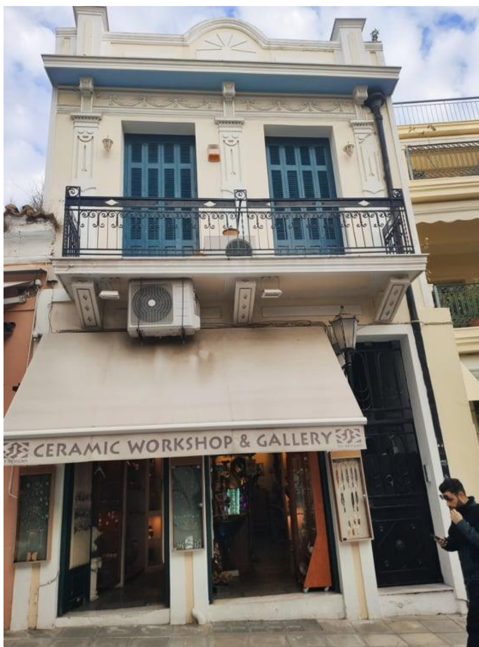
Εικόνα 59 Κτίριο επί της οδού Βύρωνος
