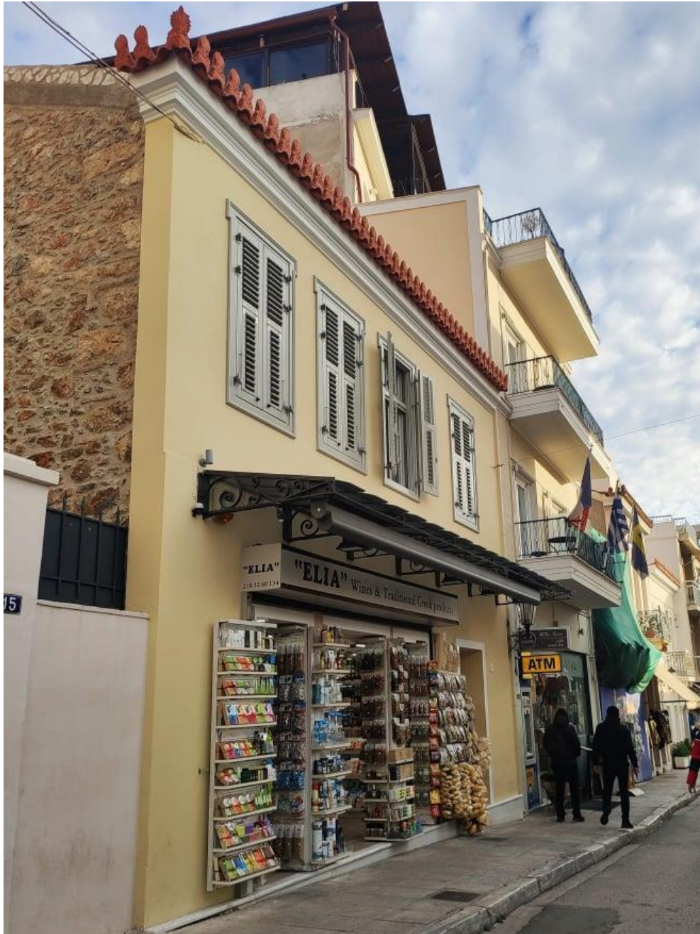
Εικόνα 68 Κτίριο επι της οδού Βύρωνος
