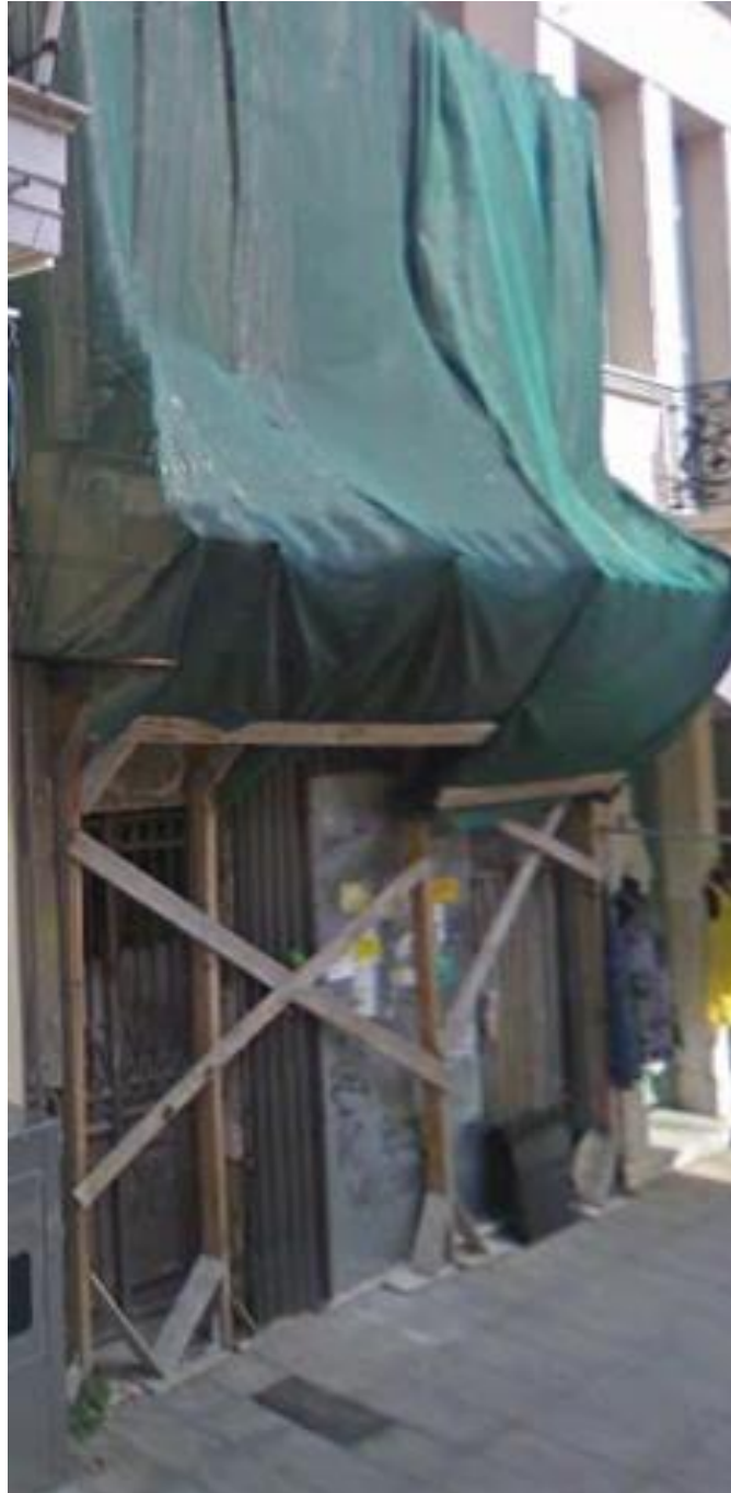
Εικόνα 71 Κτίριο επί της οδού Βύρωνος
