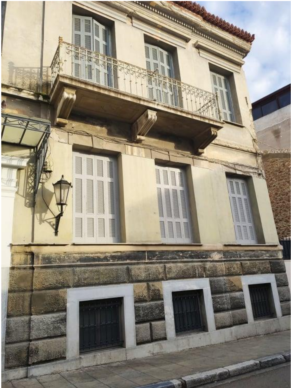
Εικόνα 67 Κτίριο επί της οδού Βύρωνος
