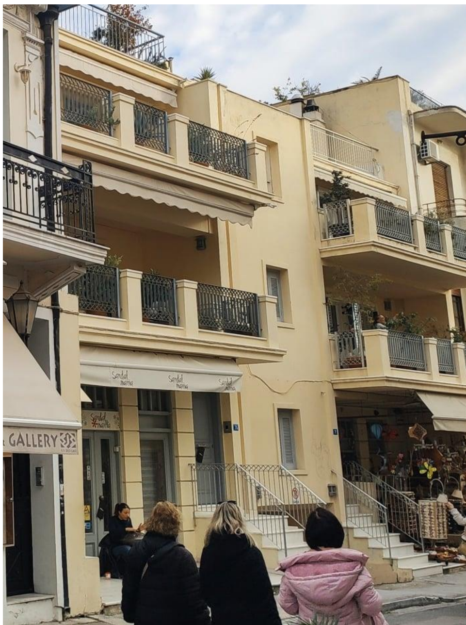
Εικόνα 60 Κτίριο επί της οδού Βύρωνος
