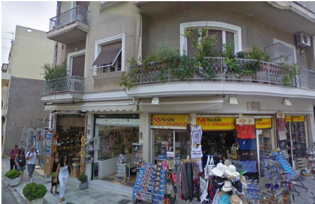
Εικόνα 52 Κτίριο επί της οδού Βύρωνος
