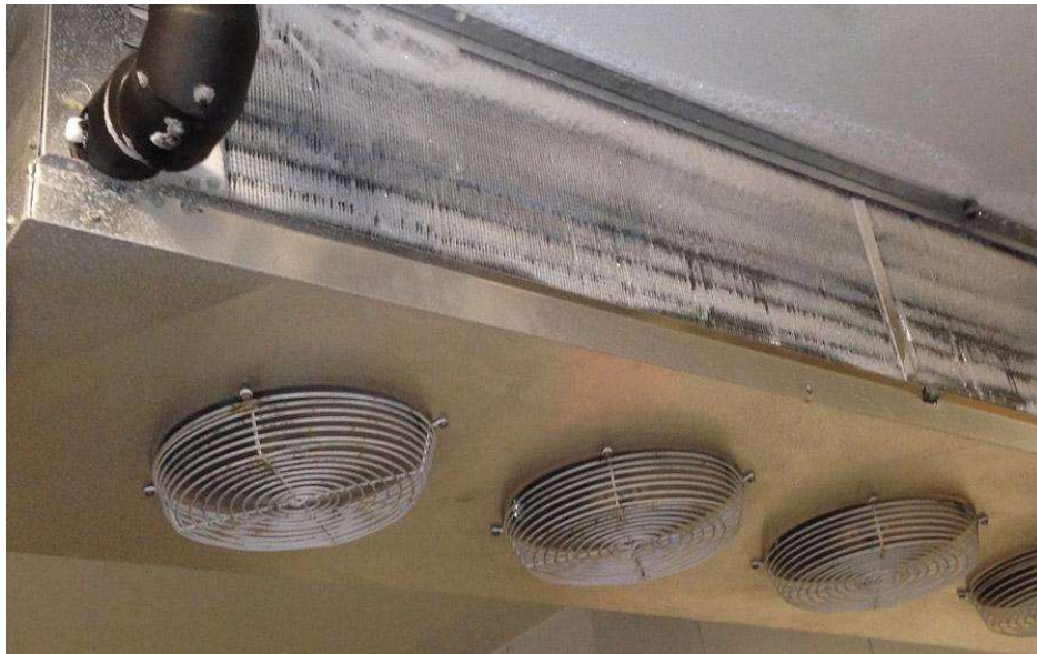
Εικόνα 3.14: Εξατμιστής εξαναγκασμένης κυκλοφορίας που έχει υποστεί το φαινόμενο του παγοφραγμού.
