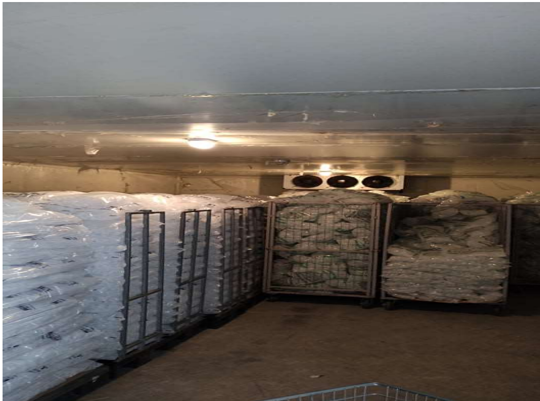
Εικόνα 2.5: Ψυκτικός θάλαμος αποθήκευσης πάγου. (Πηγή: Ψυκτική Εγκατάσταση στο Αίγιο)
