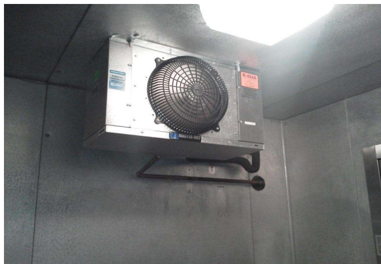
Εικόνα 3.13: Εξατμιστής εξαναγκασμένης κυκλοφορίας τοποθετημένος στην οροφή του ψυκτικού θαλάμου.
