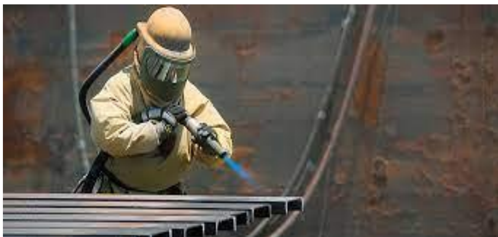
Σχ.4.1 Χειροκίνητη αμμοβολή ανοικτού τύπου
