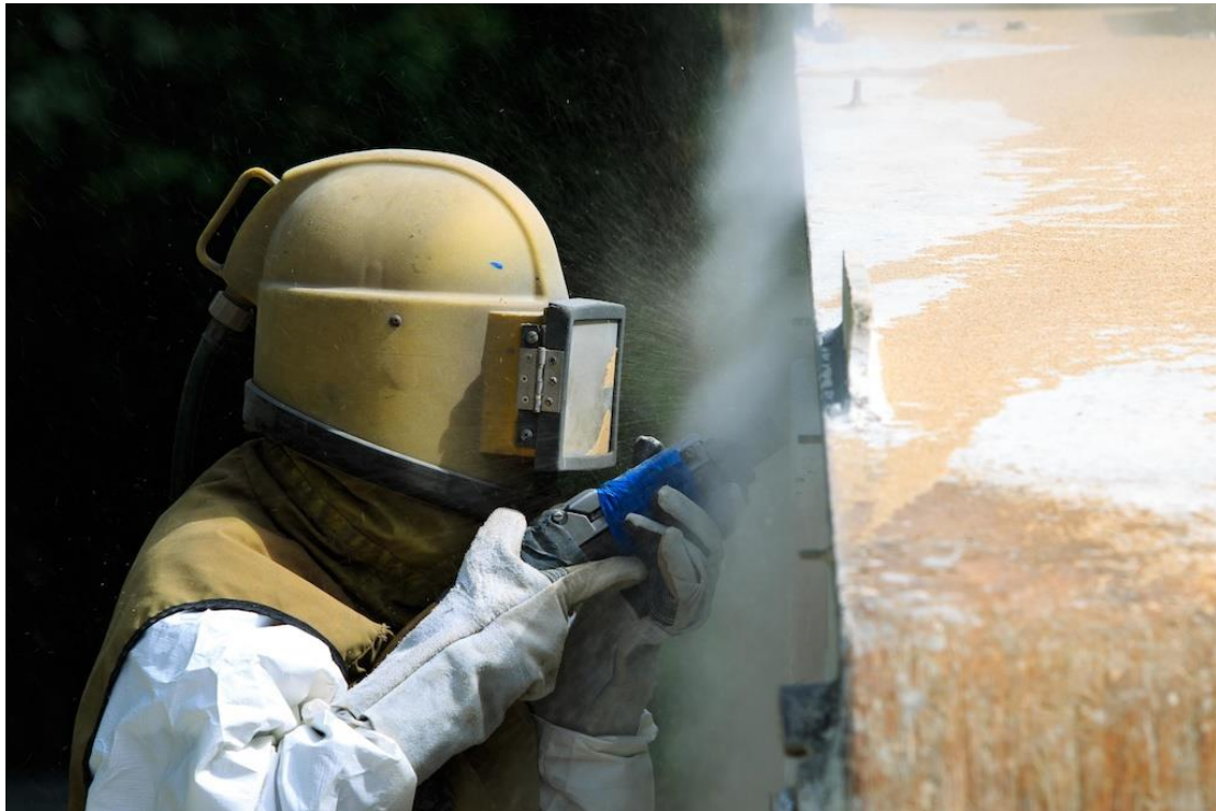
Σχ. 1.1 Χειροκίνητη αμμοβολή
