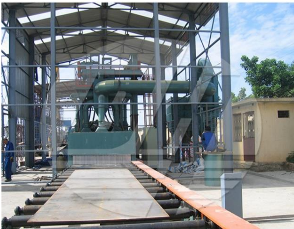
Σχ.4.6 Μηχανή Αμμοβολής πλακών χάλυβα εν ώρα λειτουργίας[3]
