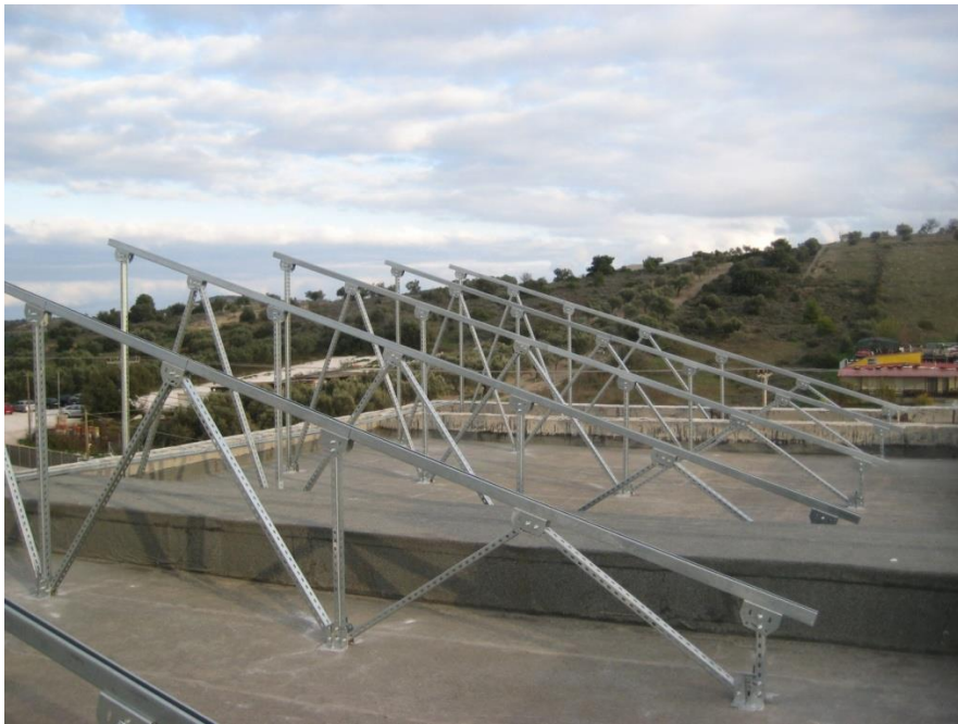
Εικόνα 4-3 Οι πακτωμένες βάσεις στήριξης
