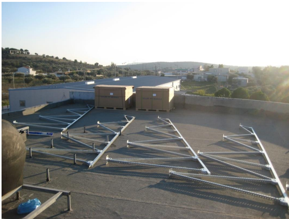
Εικόνα 4-2 Οι βάσεις στήριξης μεταφέρονται σε κομμάτια και συναρμολογούνται επί τόπου, στον χώρο της εγκατάστασης
