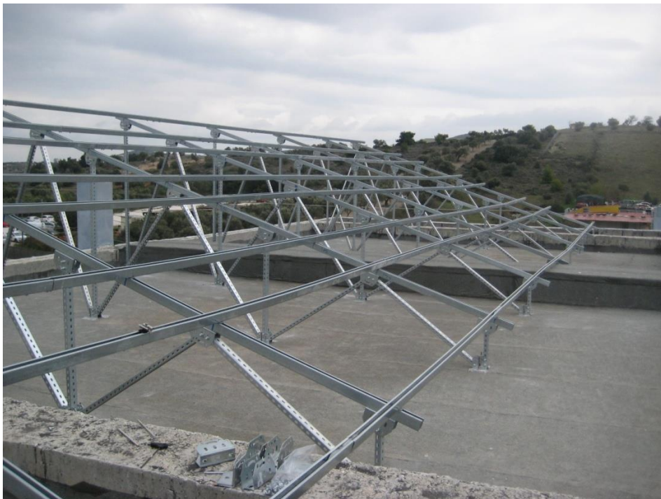
Εικόνα 4-4 Οι ράγες στήριξης των πάνελ τοποθετούνται κατά μήκος των βάσεων στήριξης
